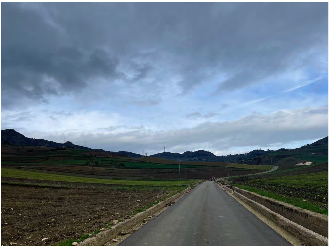
Foto 24 – Panoramica UR 07 (cavidotto)
