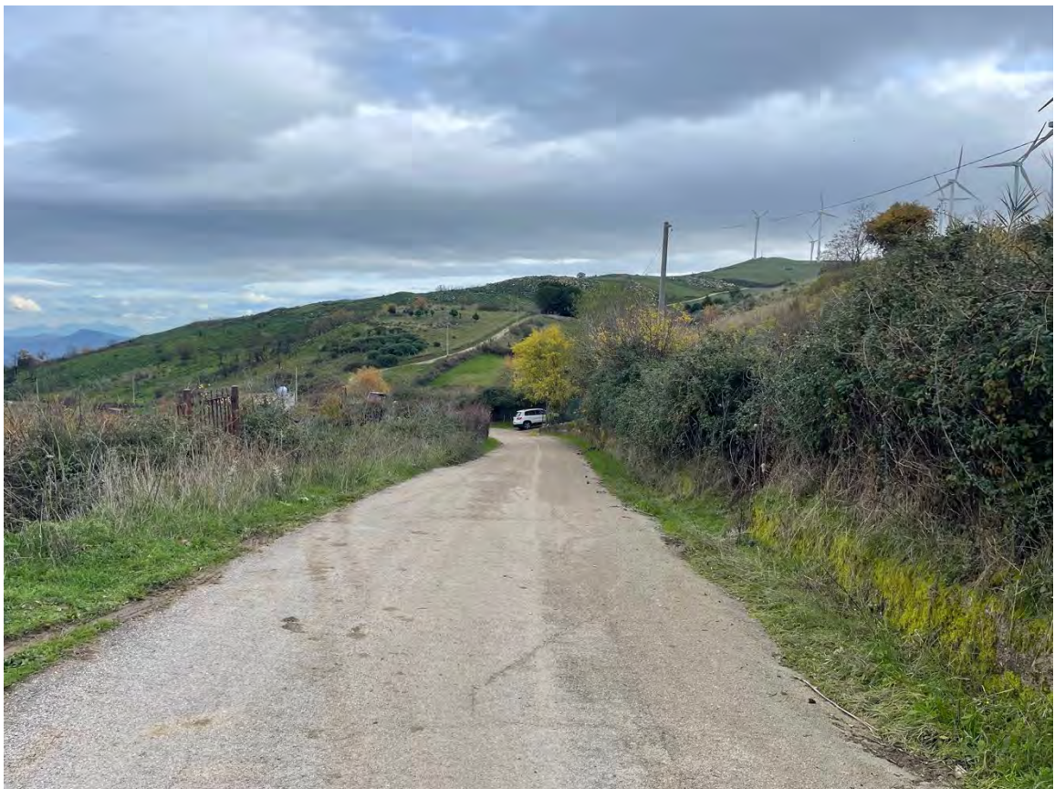
Foto 32 – Panoramica UR 07 (cavidotto)
