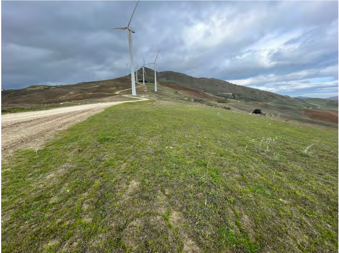
Foto 41 – Panoramica UR 10 (aerogeneratore CF-04_r)
