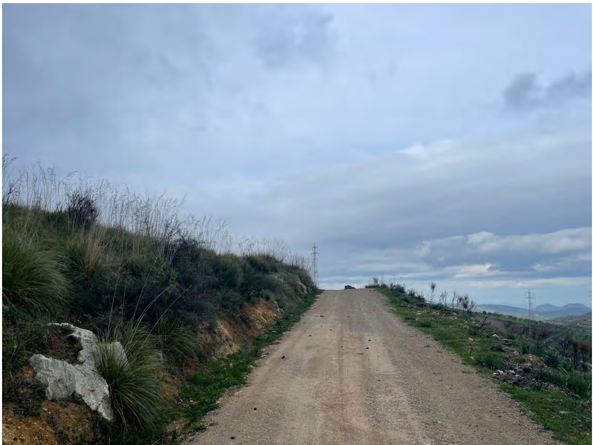
Foto 18 – Panoramica UR 05 (viabilità e cavidotto)
