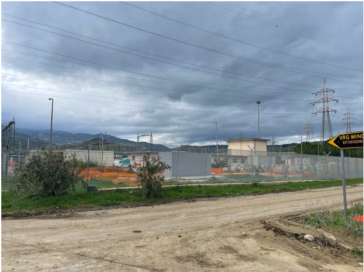
Foto 25 – Panoramica UR 07 (Sottostazione Utente Ciminna)
