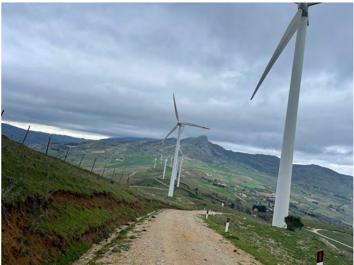
Foto 50 – Panoramica UR 13 (aerogeneratore CF-07_r)
