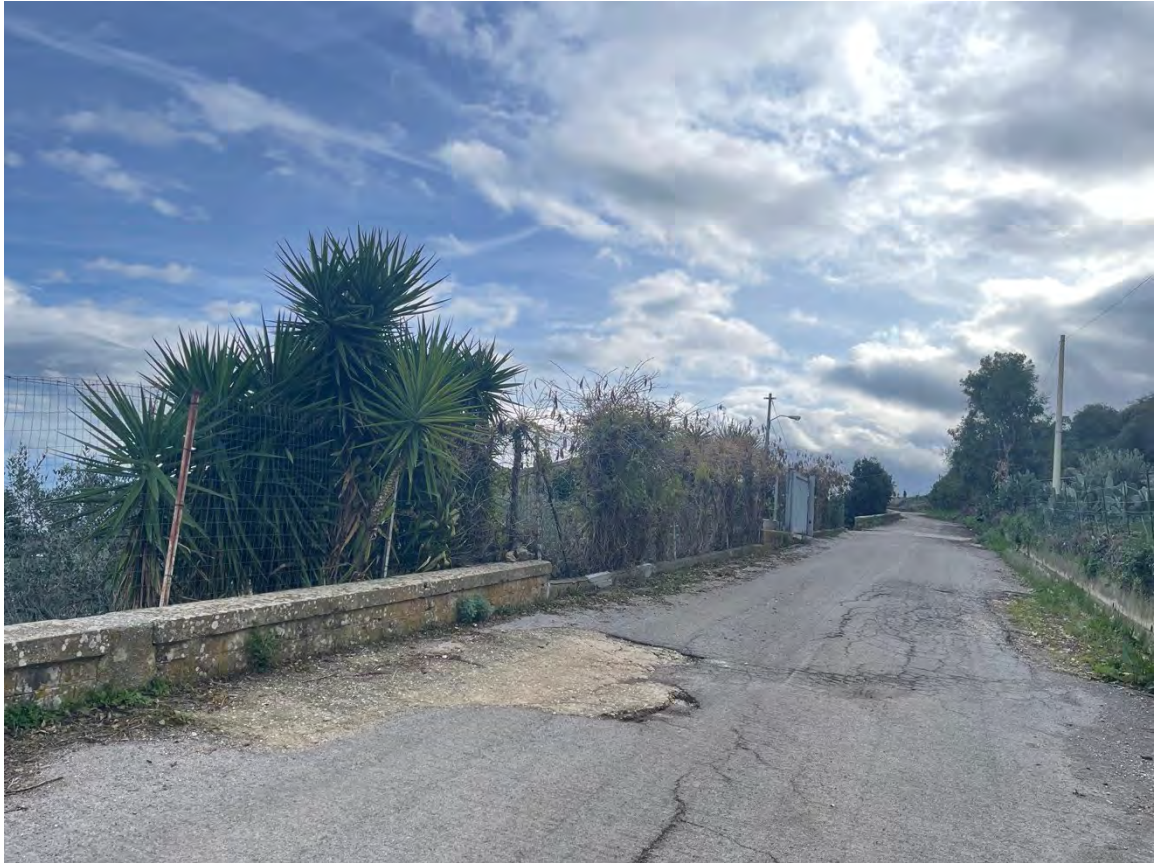
Foto 29 – Panoramica UR 07 (cavidotto)
