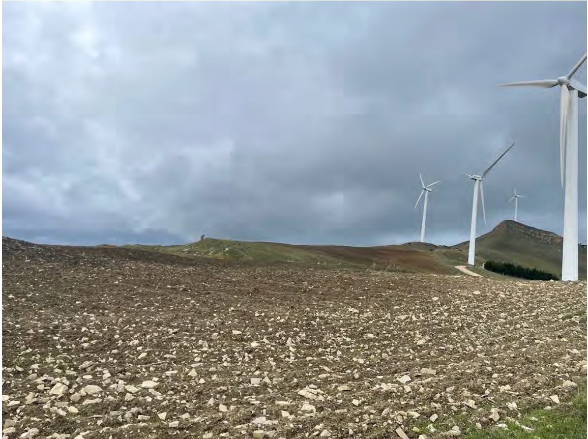
Foto 37 – Panoramica UR 09 (aerogeneratore CF-03_r)
