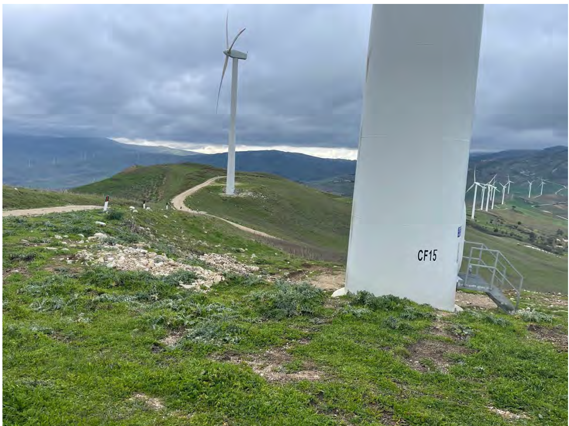
Foto 48 – Panoramica UR 12 (aerogeneratore CF-02_r)
