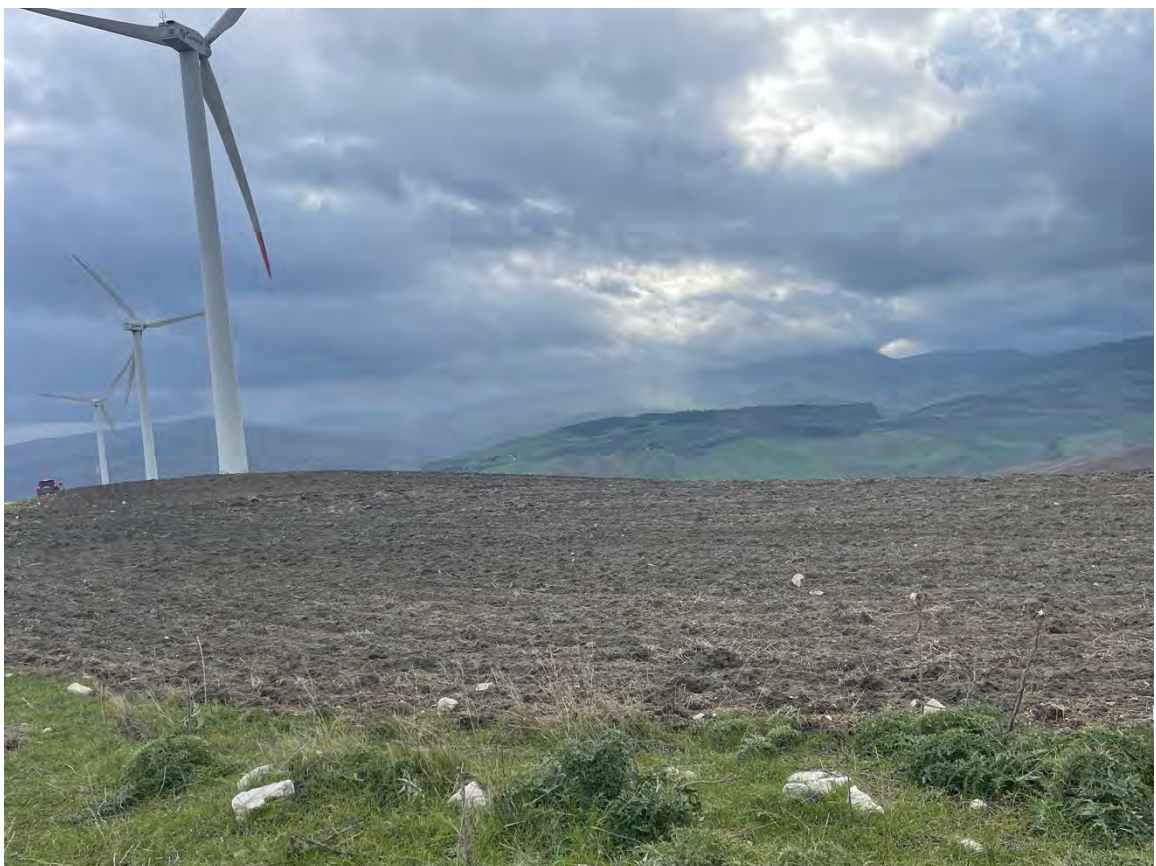
Foto 40 – Panoramica UR 10 (aerogeneratore CF-04_r)
