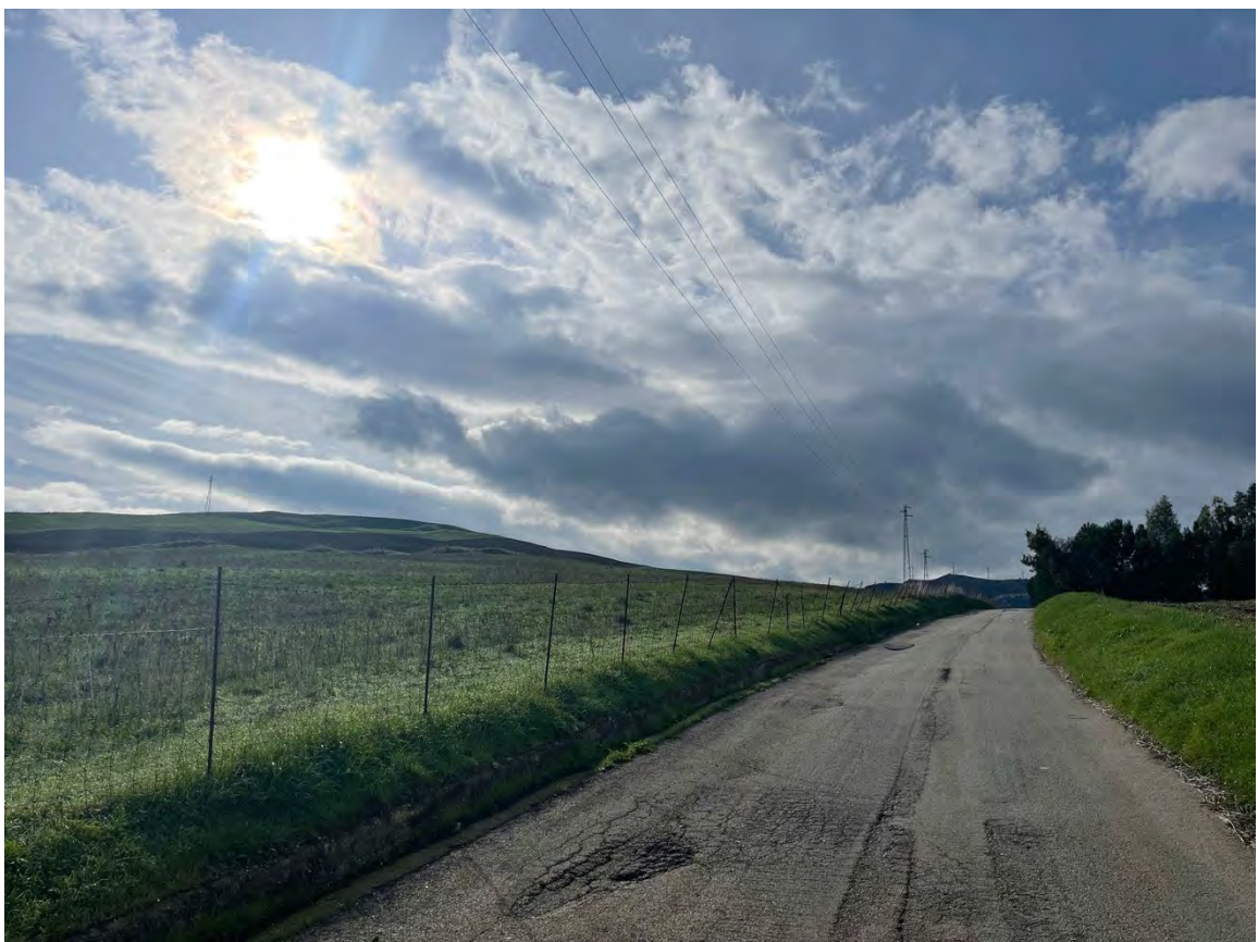
Foto 26 – Panoramica UR 07 (cavidotto)
