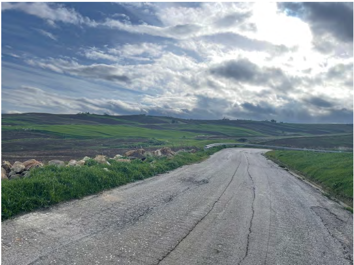
Foto 28 – Panoramica UR 07 (cavidotto)
