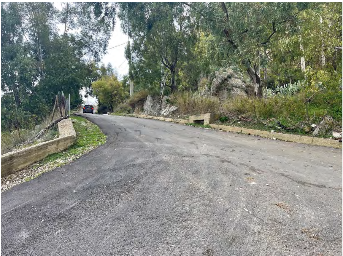
Foto 22 – Panoramica UR 07 (cavidotto)
