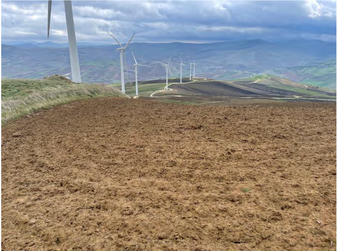
Foto 39 – Panoramica UR 09 (aerogeneratore CF-03_r)
