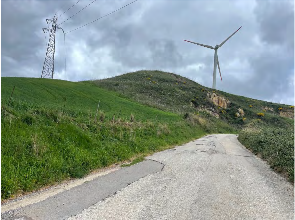
Foto 59 – Panoramica UR 16 (cavidotto)
