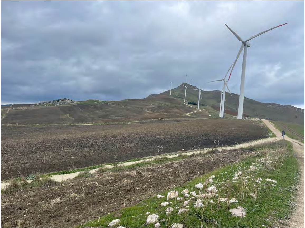
Foto 43 – Panoramica UR 10 (aerogeneratore CF-04_r)
