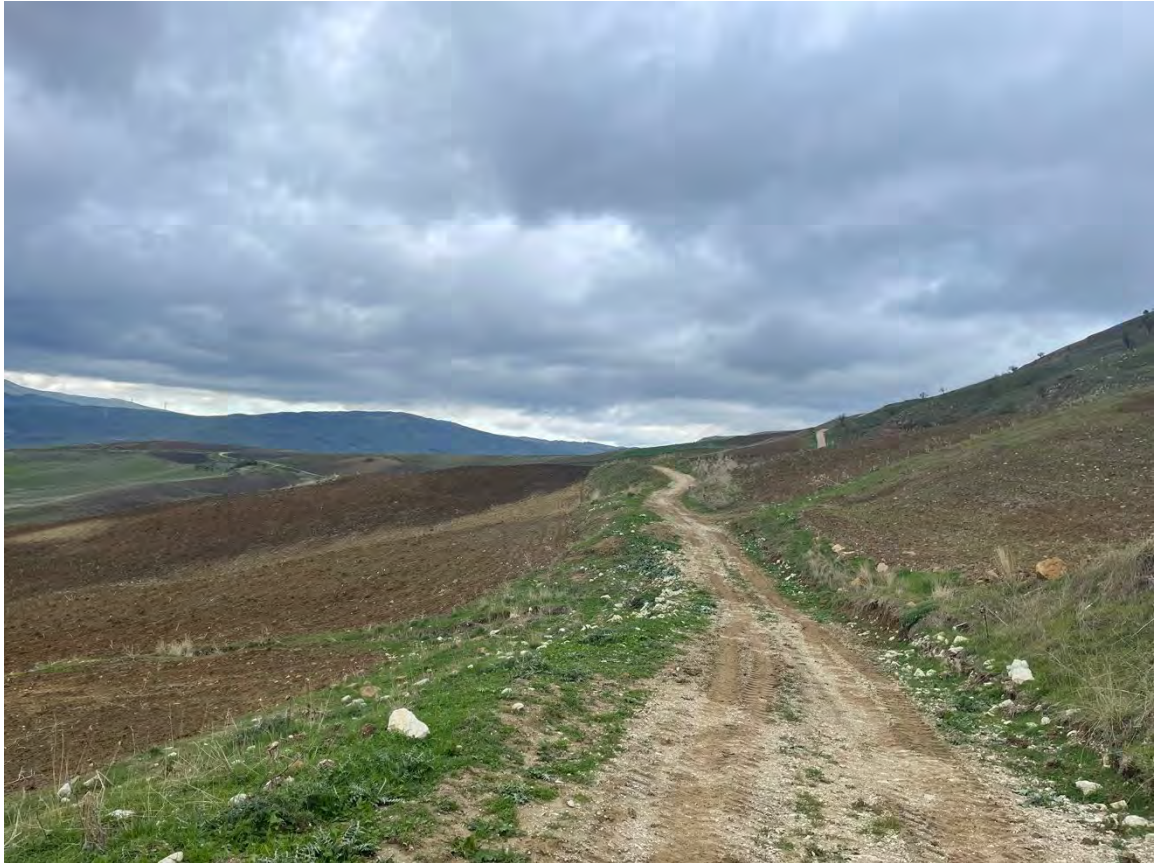
Foto 35 – Panoramica UR 08 (viabilità e cavidotto)
