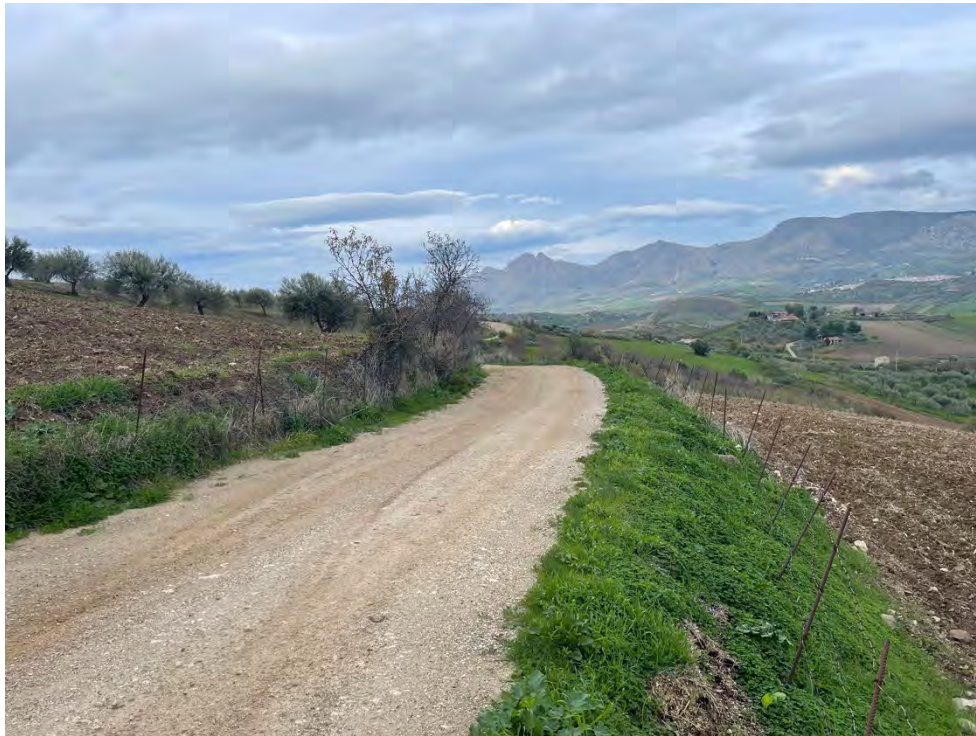
Foto 1 – Panoramica UR 01 (viabilità e cavidotto)
