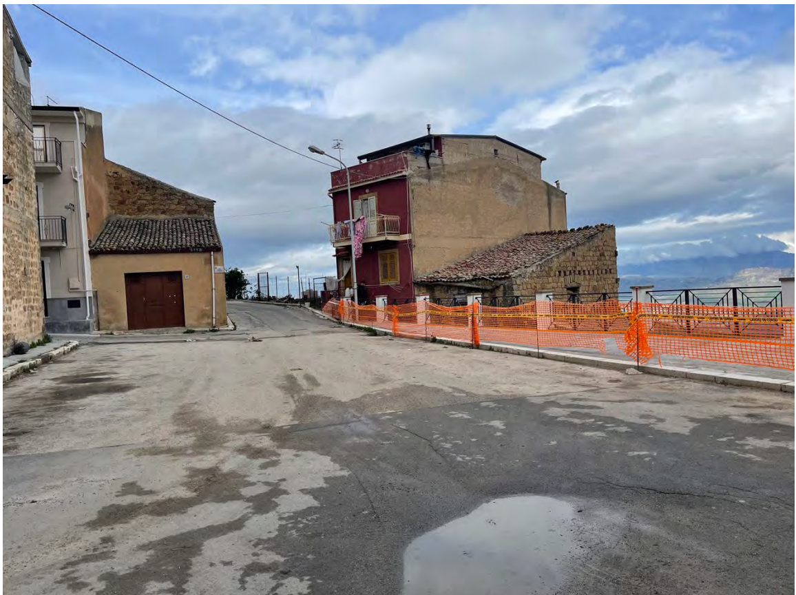
Foto 30 – Panoramica UR 07 (cavidotto)
