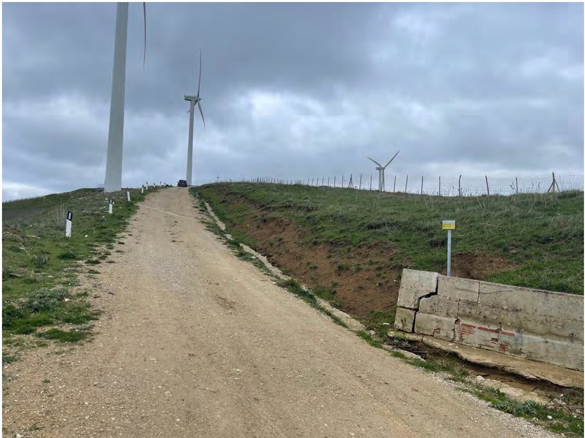
Foto 49 – Panoramica UR 12 (aerogeneratore CF-02_r)
