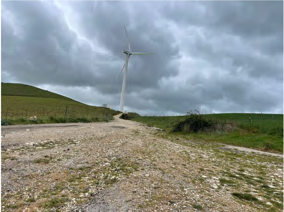
Foto 57 – Panoramica UR 15 (viabilità e cavidotto)
