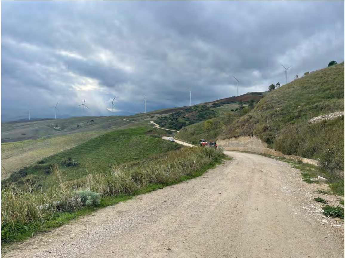
Foto 33 – Panoramica UR 08 (viabilità e cavidotto)
