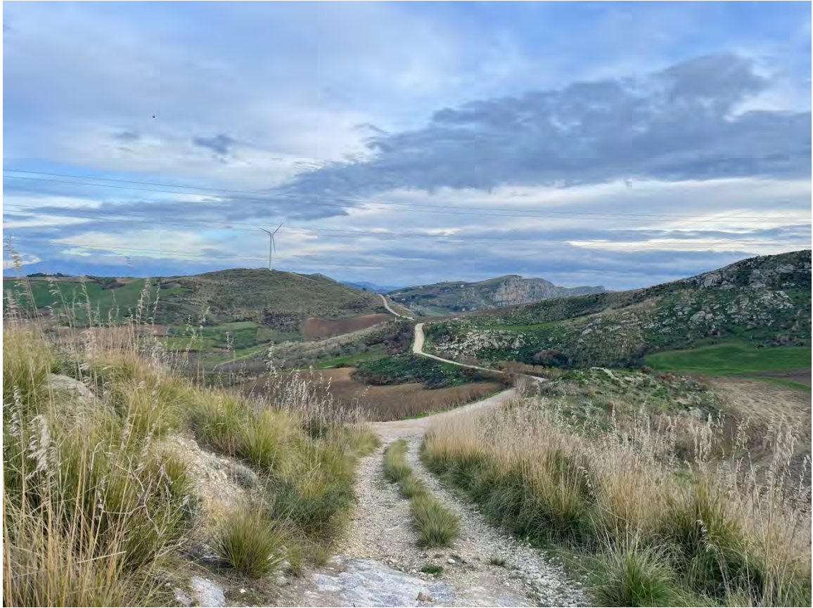
Foto 17 – Panoramica UR 05 (viabilità e cavidotto)
