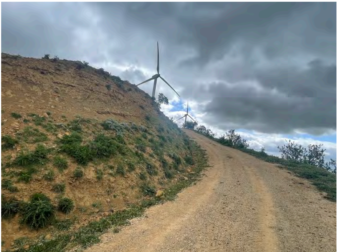
Foto 58 – Panoramica UR 15 (viabilità e cavidotto)
