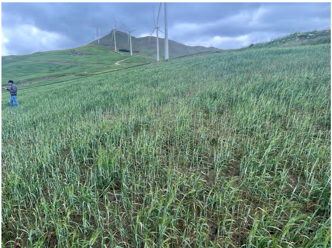
Foto 42 – Panoramica UR 10 (aerogeneratore CF-04_r)
