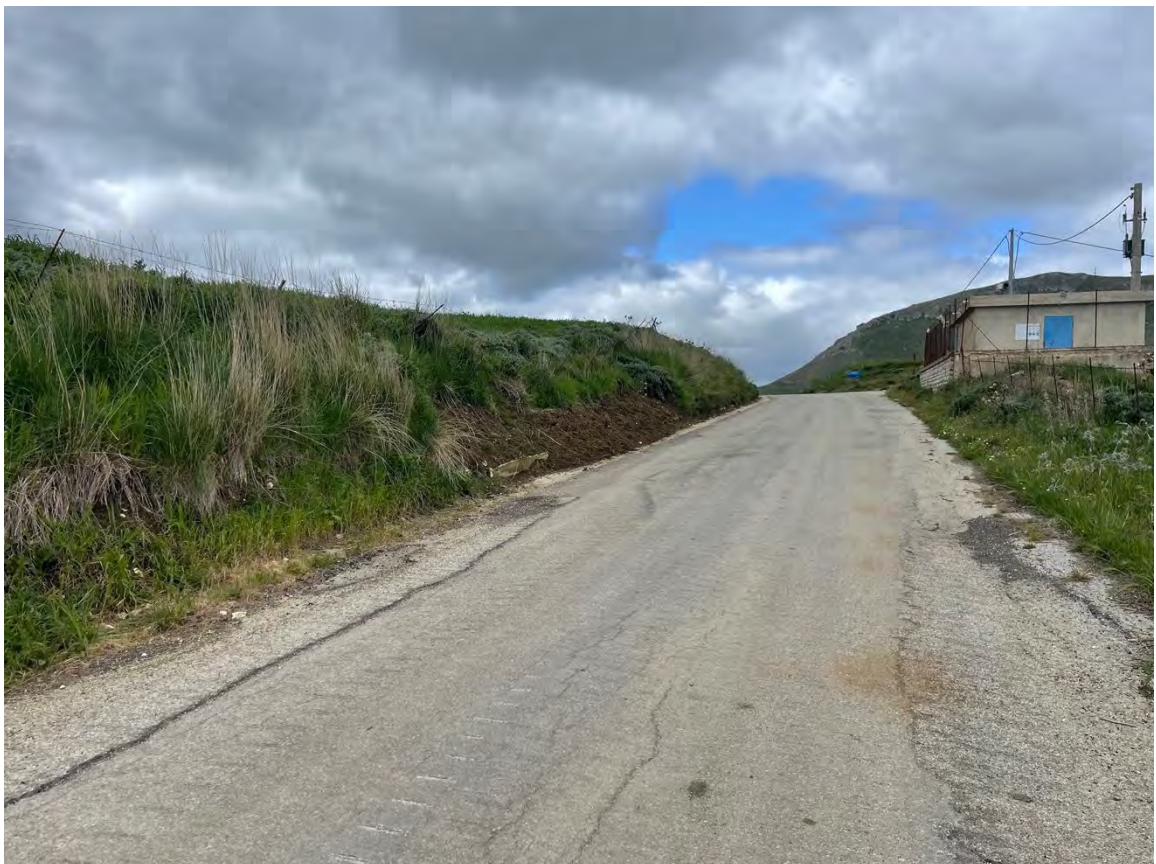
Foto 60 – Panoramica UR 16 (cavidotto)
