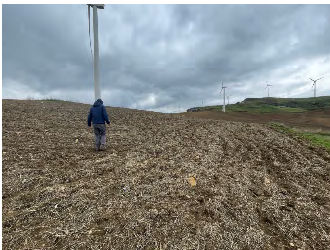
Foto 10 – Panoramica UR 03 (aerogeneratore VF-01_r)
