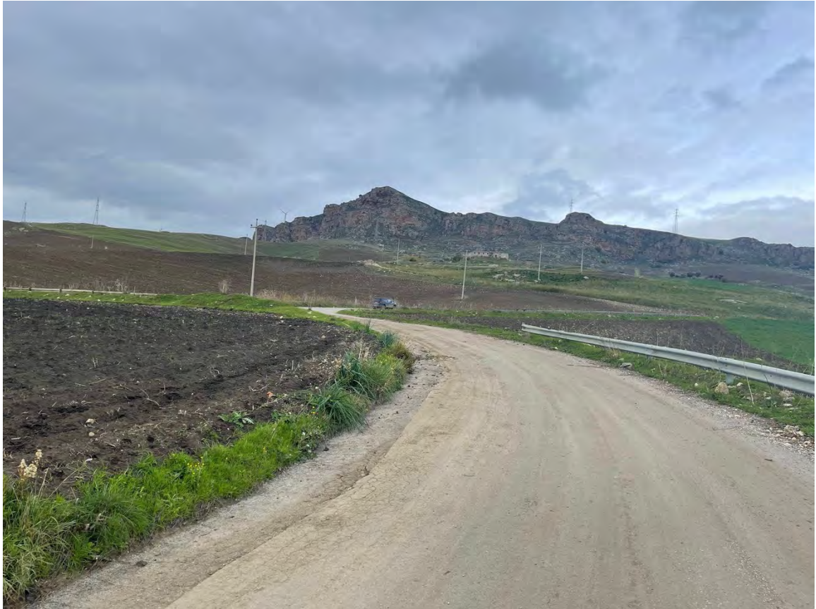
Foto 23 – Panoramica UR 07 (cavidotto)
