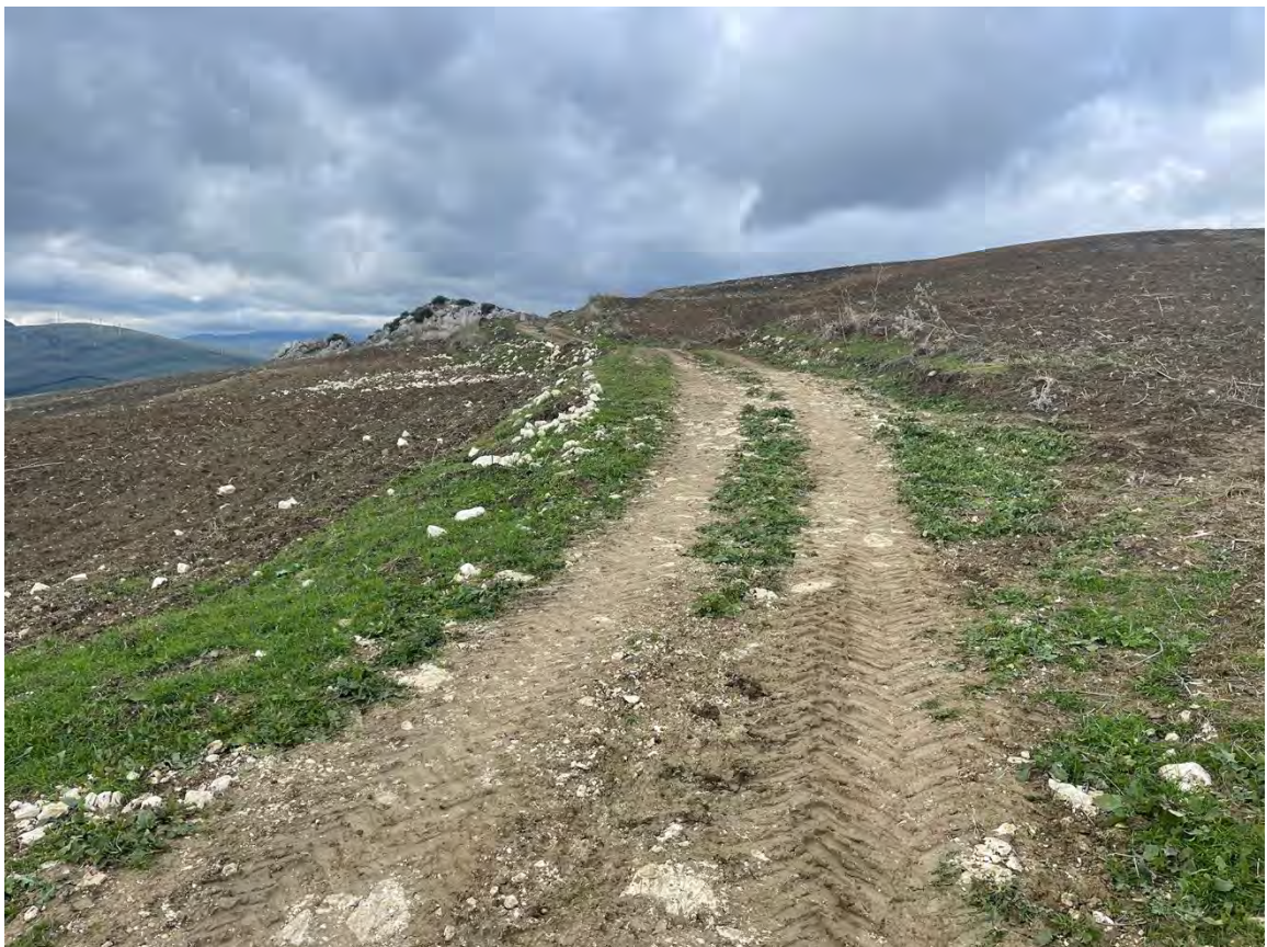
Foto 34 – Panoramica UR 08 (viabilità e cavidotto)
