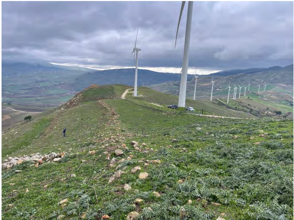
Foto 47 – Panoramica UR 12 (aerogeneratore CF-02_r)
