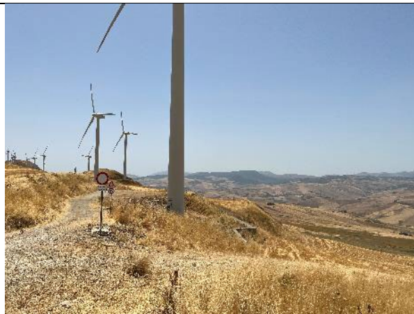
Area installazione aerogeneratore CF-06_r
