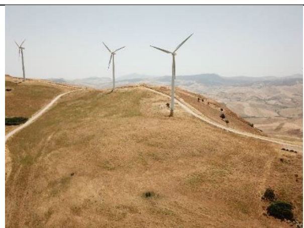
Area installazione aerogeneratore CF-07_r
