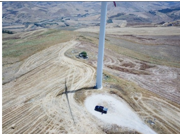
Area installazione aerogeneratore CF-05_r
