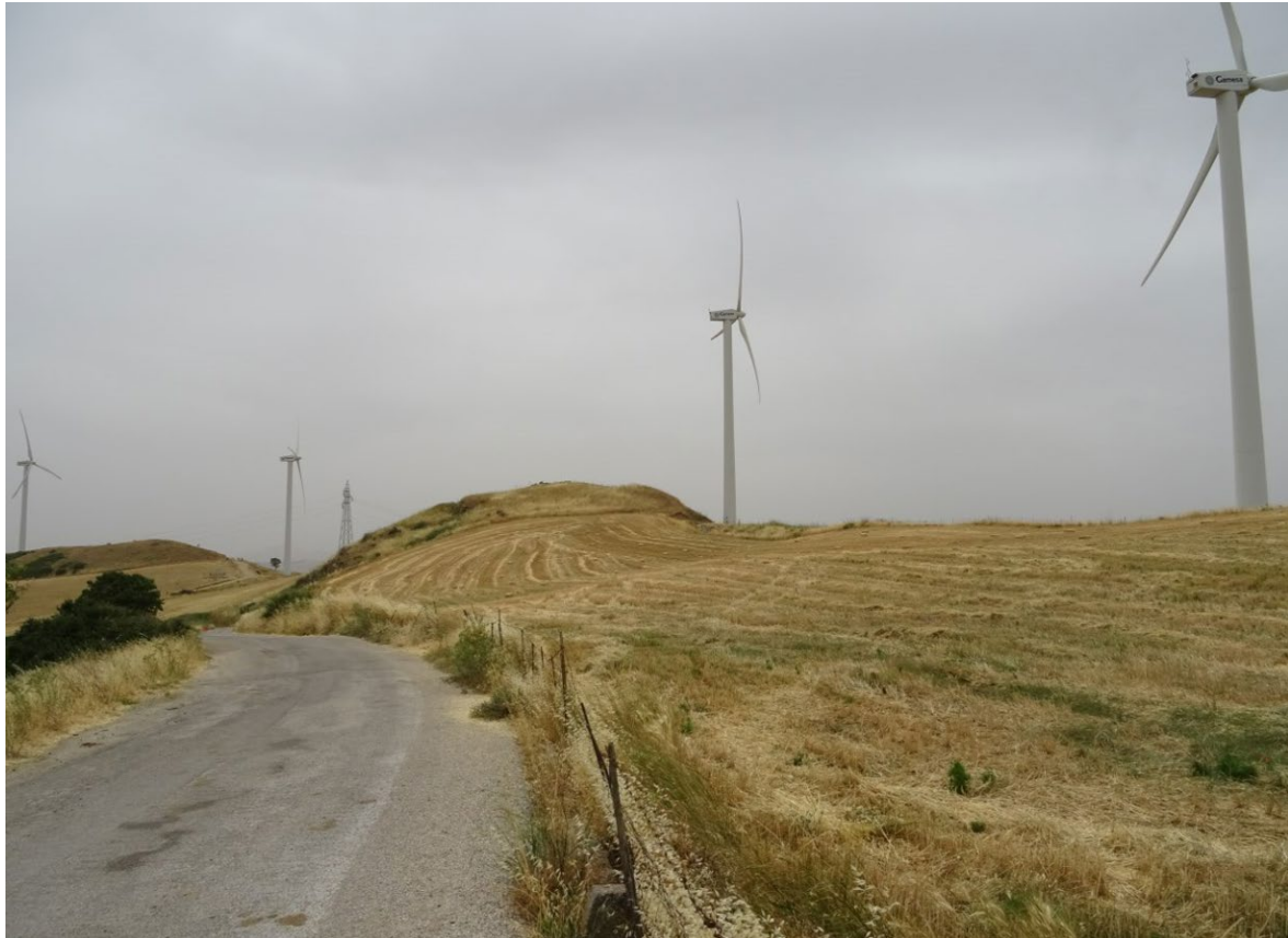
Figura 6-1: Vista strada SP82
