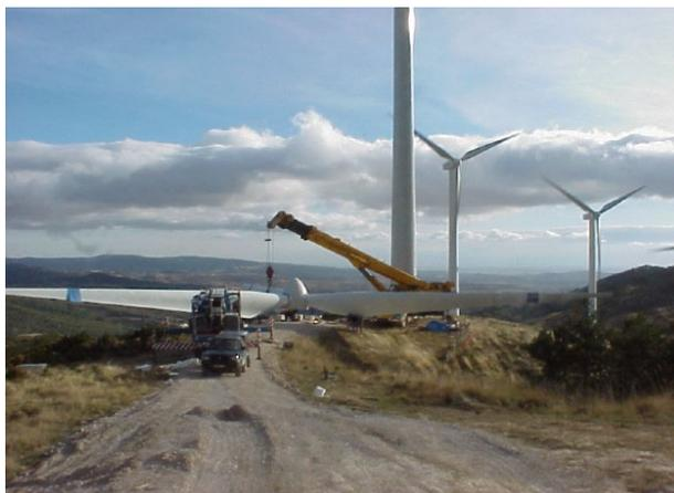
**Figura 3-2: Esempio ingombro del rotore a terra**
