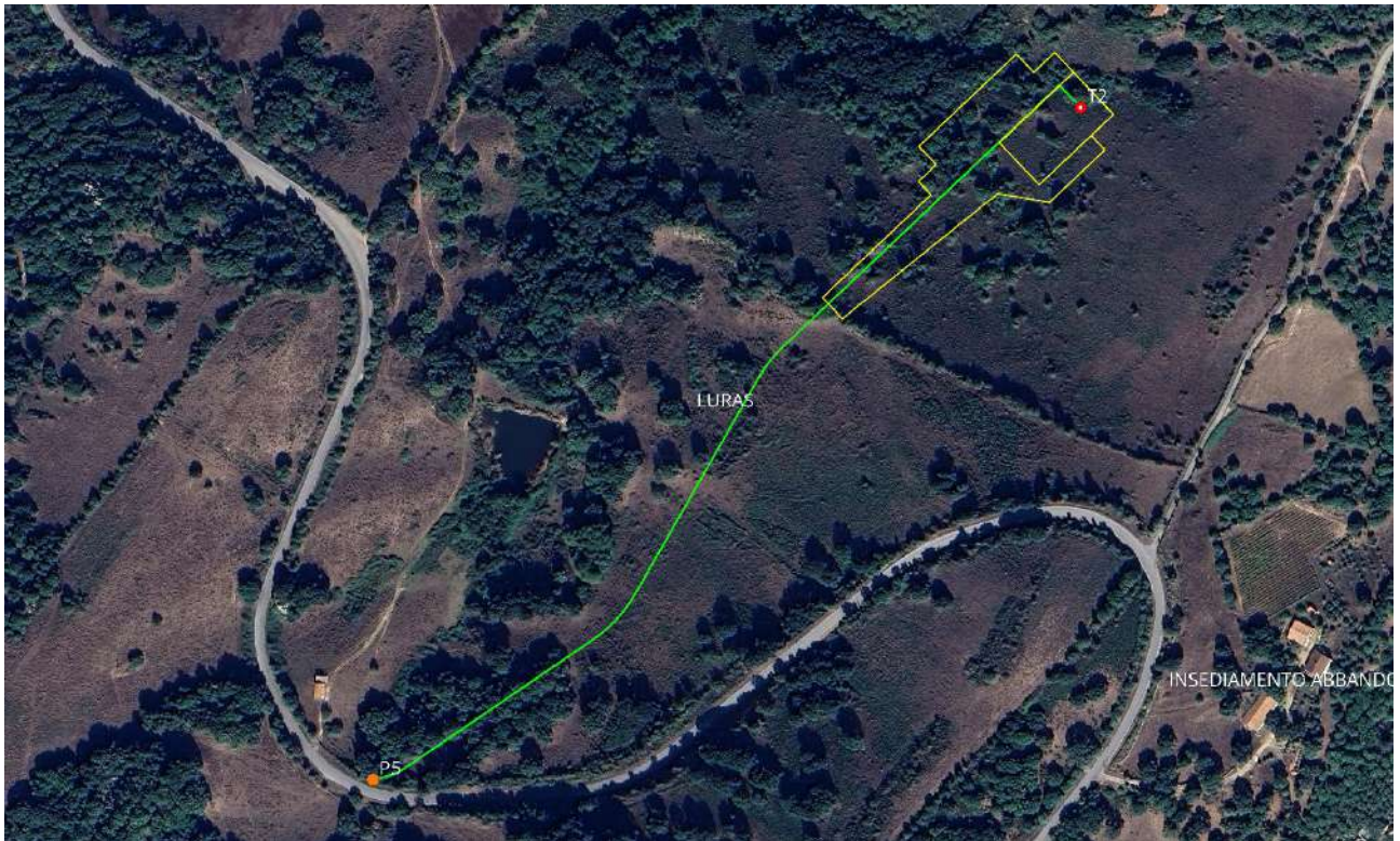
Figura 62: Tratto Vi cavidotto e Punto scatto P5
