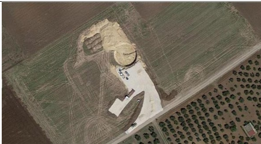
Figura 16: foto satellitare di cantiere per la realizzazione fondazione e piazzola per aerogeneratore
