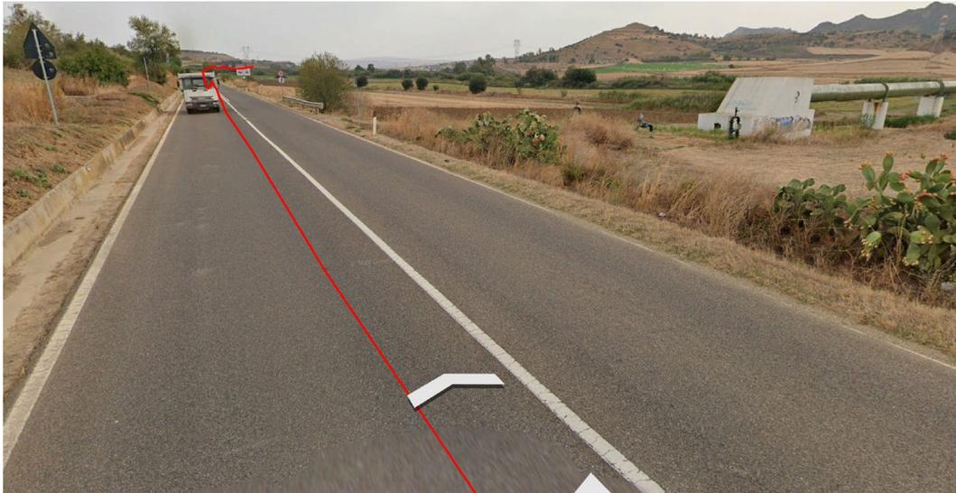
**Figura 42 – Attraversamento tramite TOC acquedotto lato sinistro su strada statale SS197**
