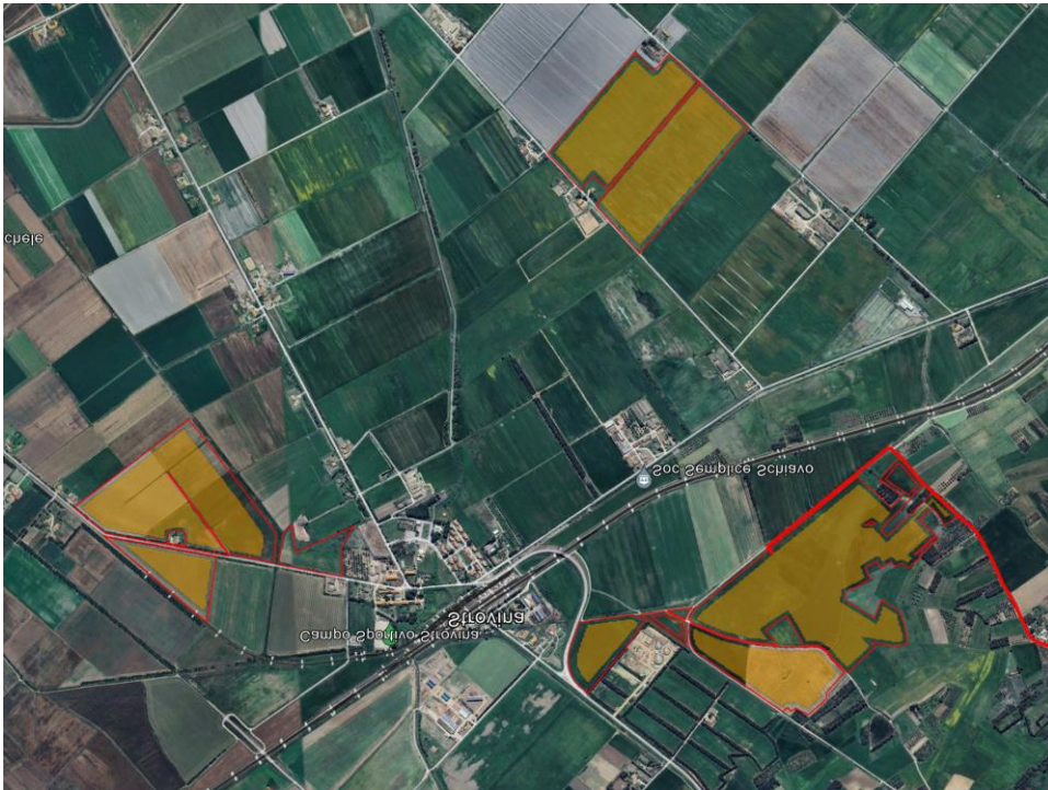
Dettaglio delle Piastre fotovoltaiche
