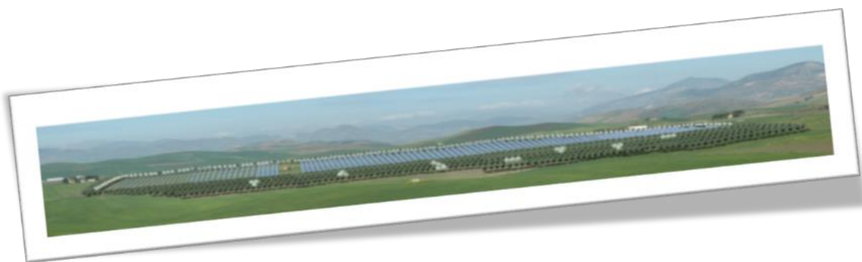
Figura 28 - Impianto fotovoltaico da 5 MW, "Heliospower", Monreale (PA) 2010
