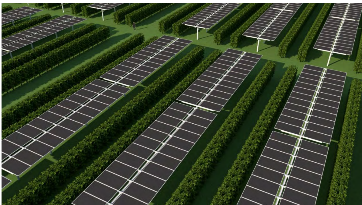
Figura 27 - Schizzo dell'assetto impiantistico: un filare FV e due siepi ulivicole alternate
