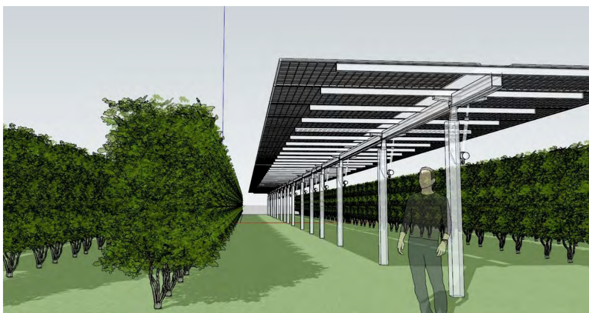
Figura 9 - Immagine impianto, altezza media 2,8 mt
