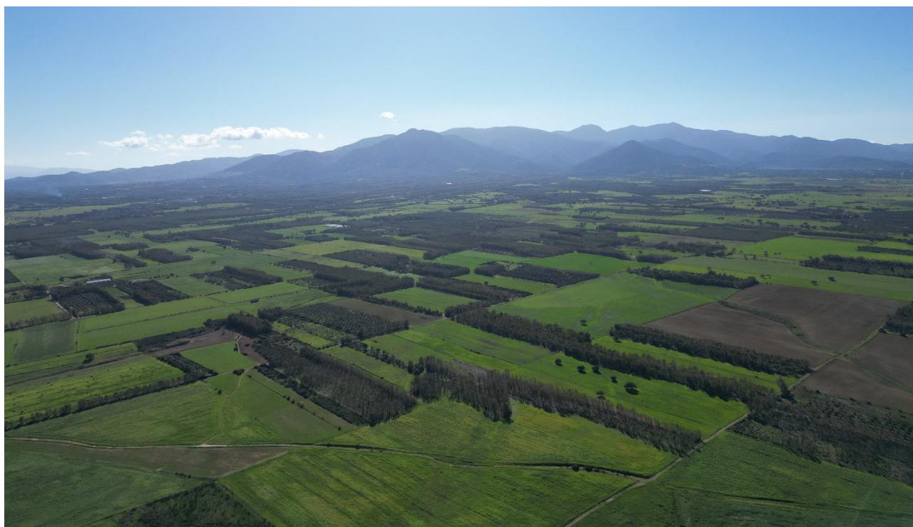
Figura 7.5 - Vista sulla porzione orientale dell'area di impianto. Sullo sfondo i rilievi del Monte Linas. Ripresa aerea da nord-est verso sud-ovest nei pressi della postazione AG05
