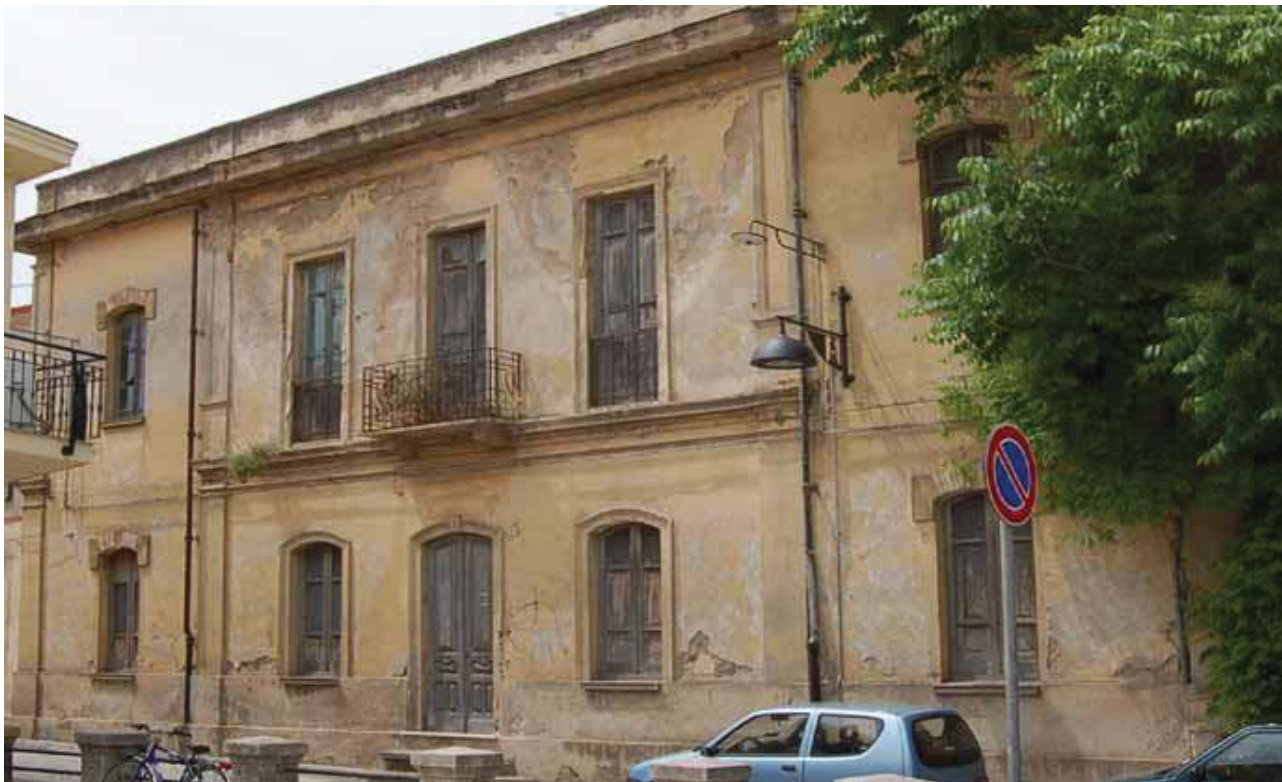
Figura 7.18 - Casa Mereu in via Diaz
