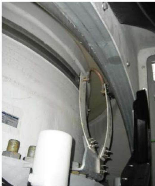
*Figura 6: LCU tra lame e telaio navicella.*
