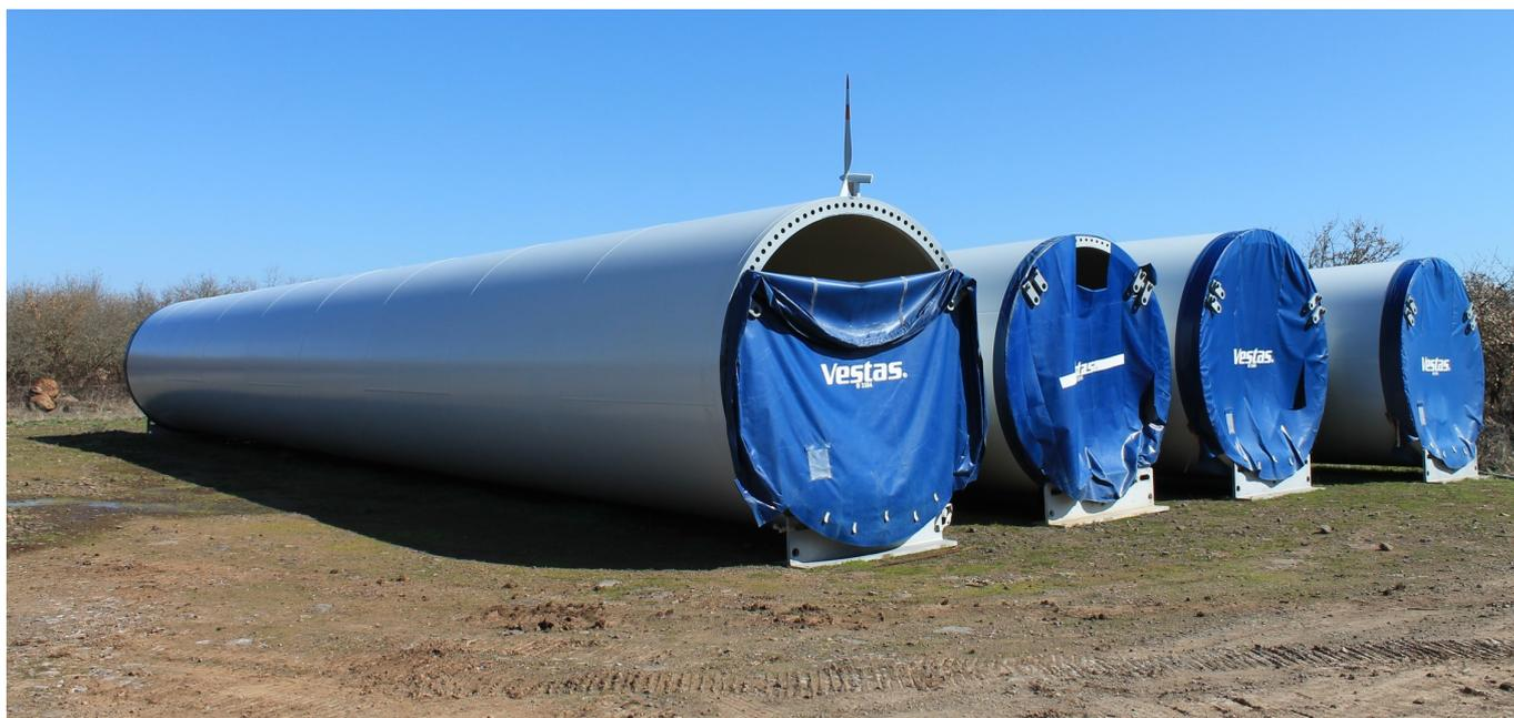
Figura 19: Esempio di area deposito elementi torre
