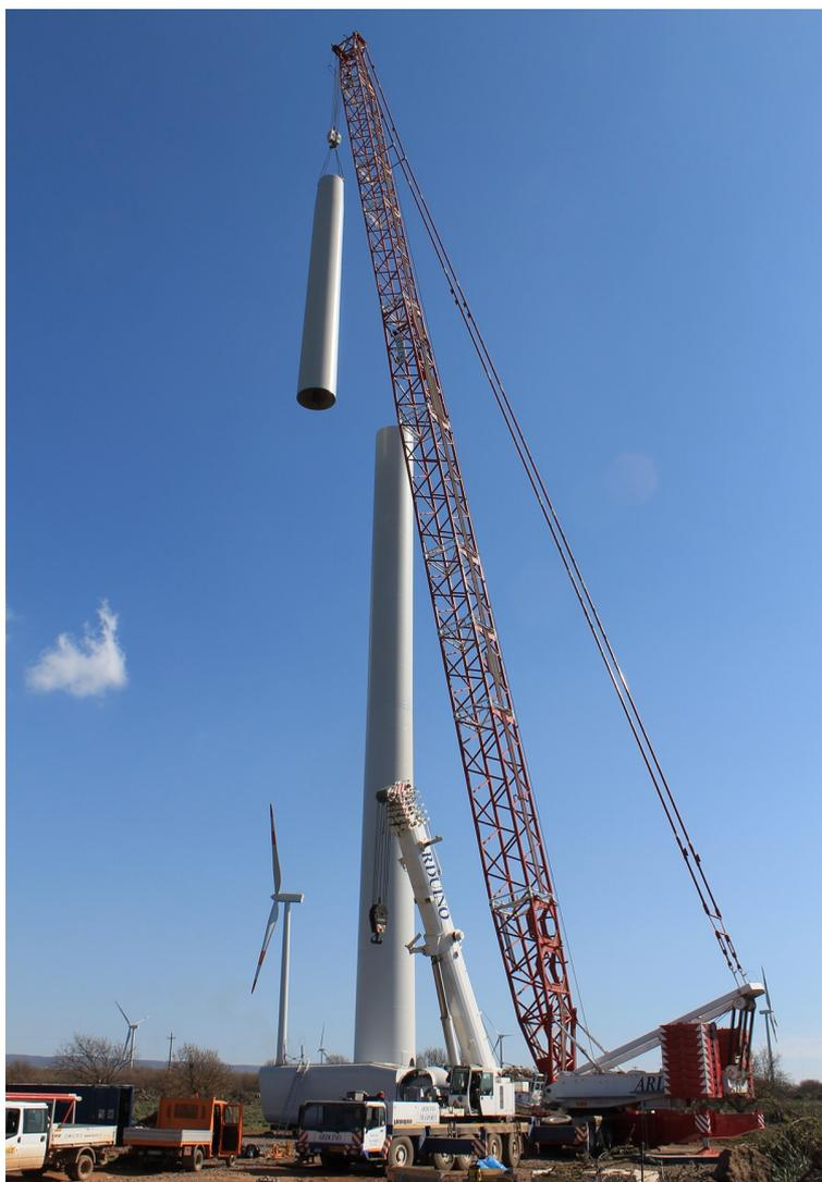
*Figura 23: Fase di montaggio della torre*
