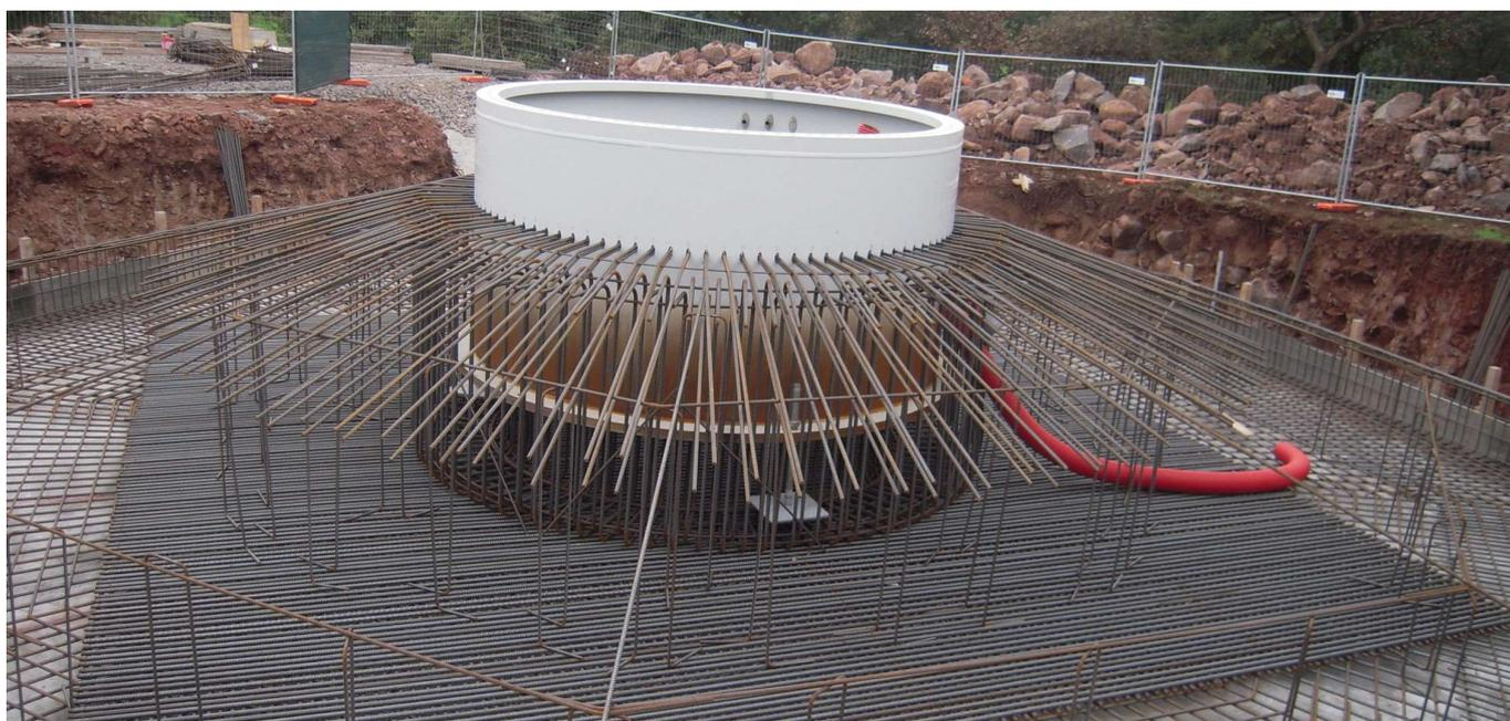
*Figura 20: Esempio di fondazione tipo*
