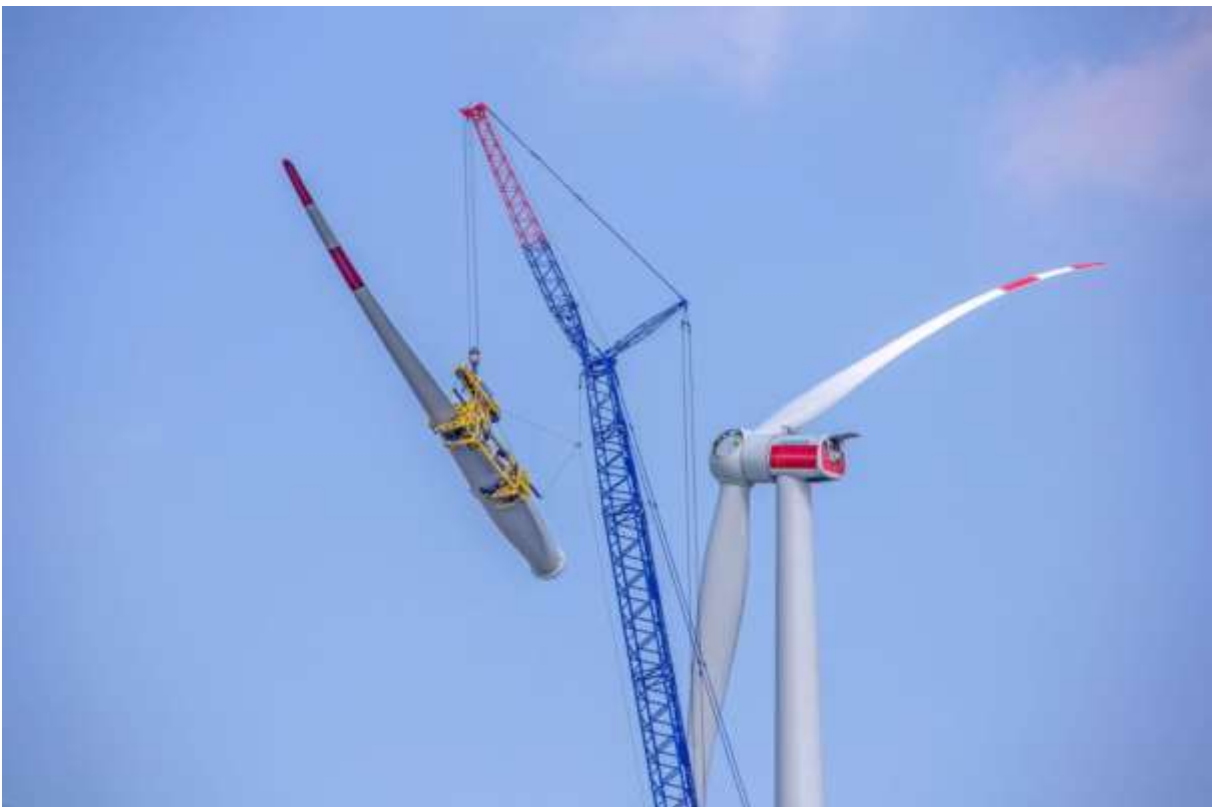
Figura 3—13 Montaggio pale attraverso la gru Liebherr LR 1600 2W.
