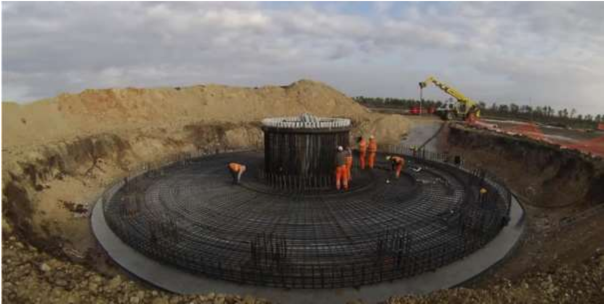
Figura 3—11 fissaggio al basamento della fondazione.
