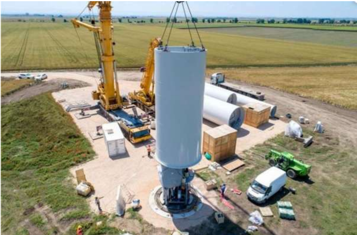
Figura 3—11 fissaggio al basamento della fondazione.
