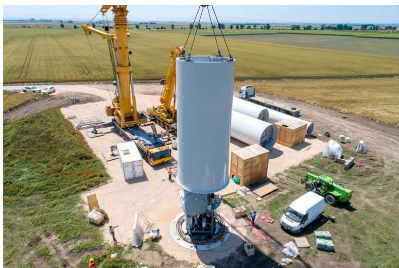
Figure 16 - fissaggio al basamento della fondazione
