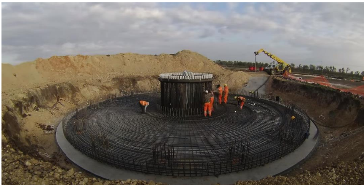
Figure 15 - Predisposizione del plinto di fondazione
