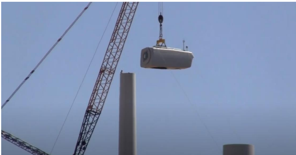
Figure 17 - Installazione navicella
