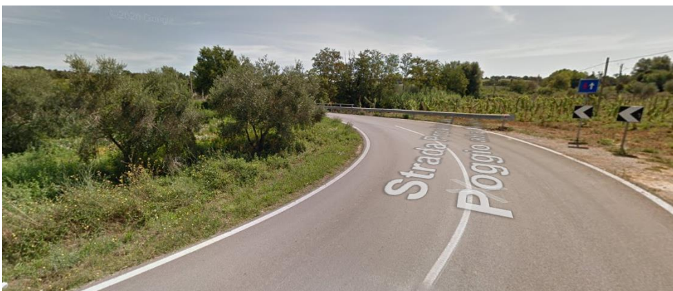
Figure 47 - Stato di fatto sito intervento 38
