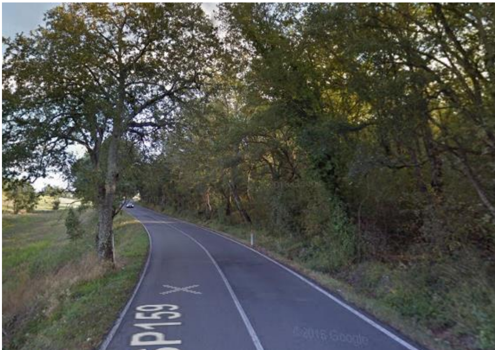
Figure 27 -Stato di fatto sito intervento 18
