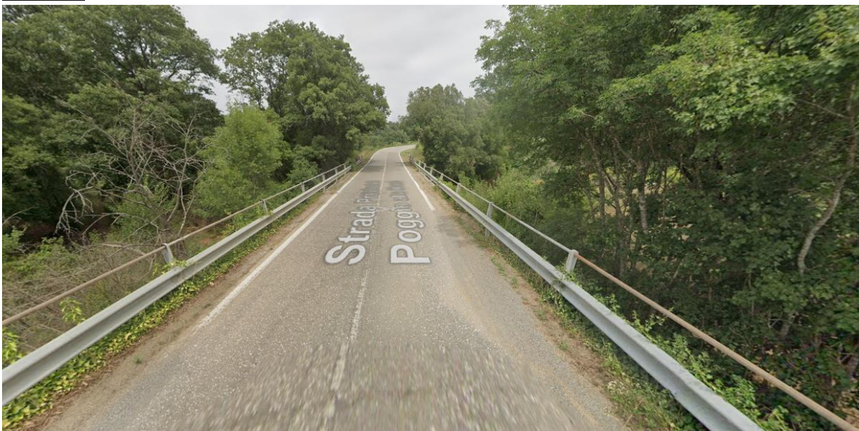
Figure 52 - Stato di fatto sito intervento 43
