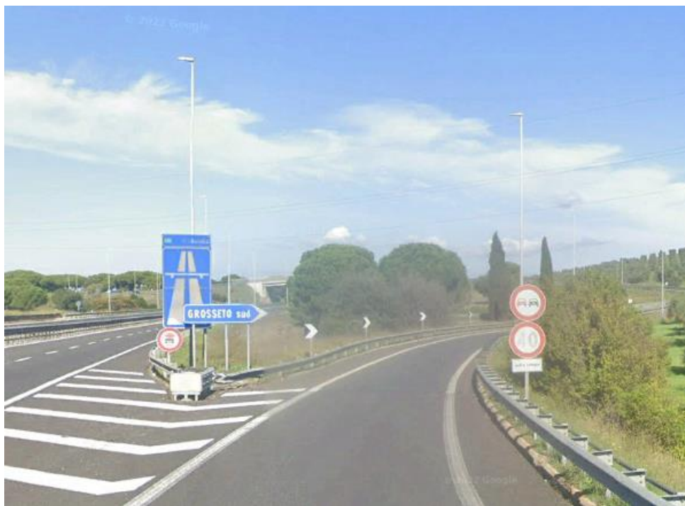
Figure 9 – Stato di fatto sito intervento 1
