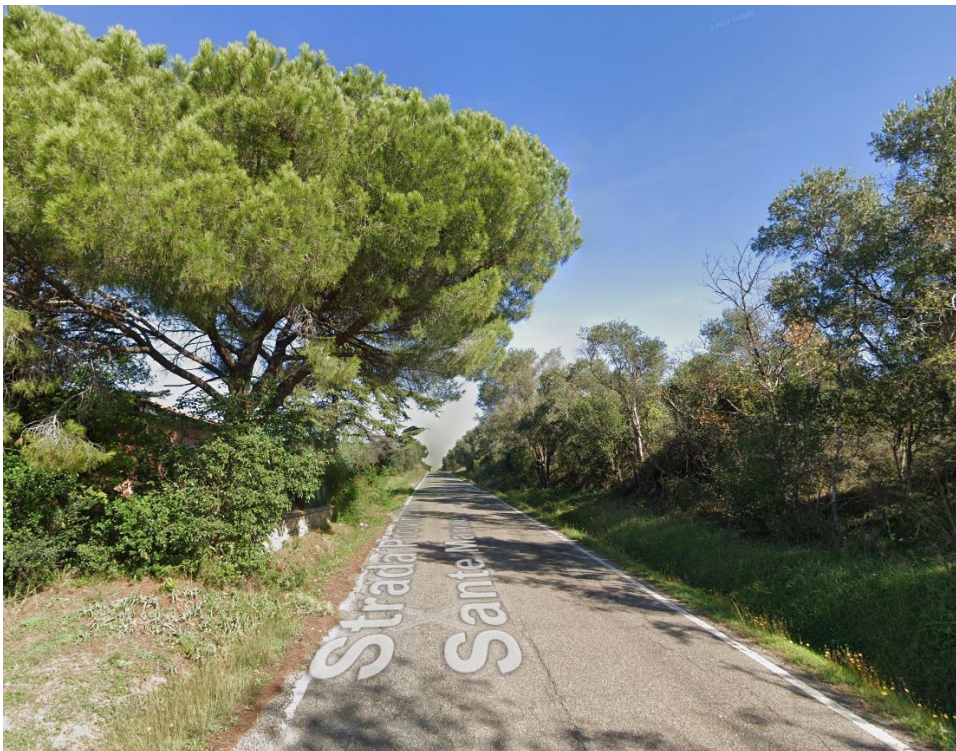
Figure 16 -Stato di fatto sito intervento 7
