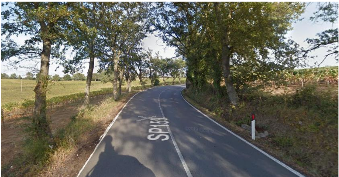
Figure 33 -Stato di fatto sito intervento 24
