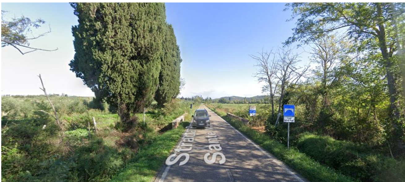
Figure 20 -Stato di fatto sito intervento 11
