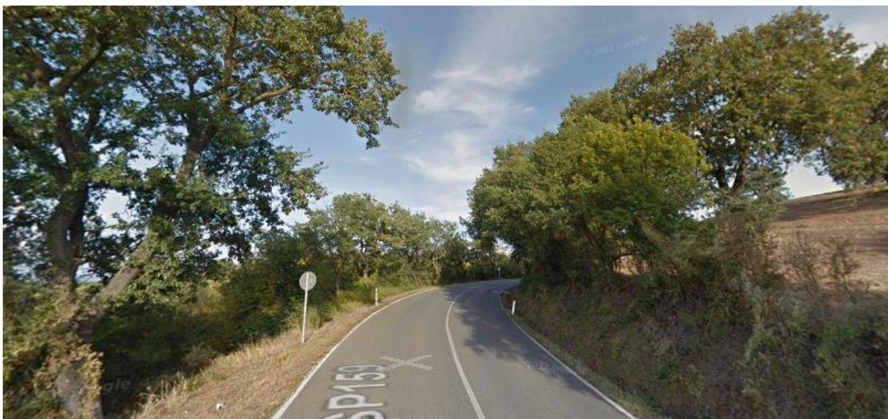
Figure 26 -Stato di fatto sito intervento 17
