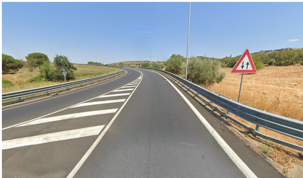
Figure 10 - Stato di fatto sito intervento 2
