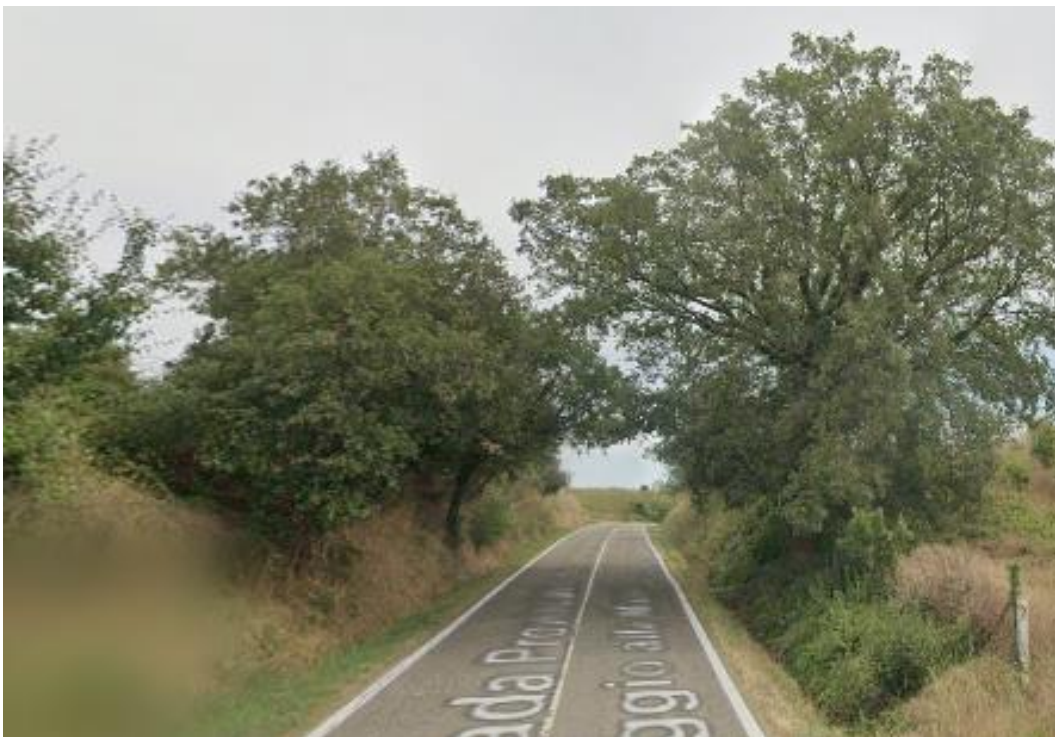
Figure 54 - Stato di fatto sito intervento 45
