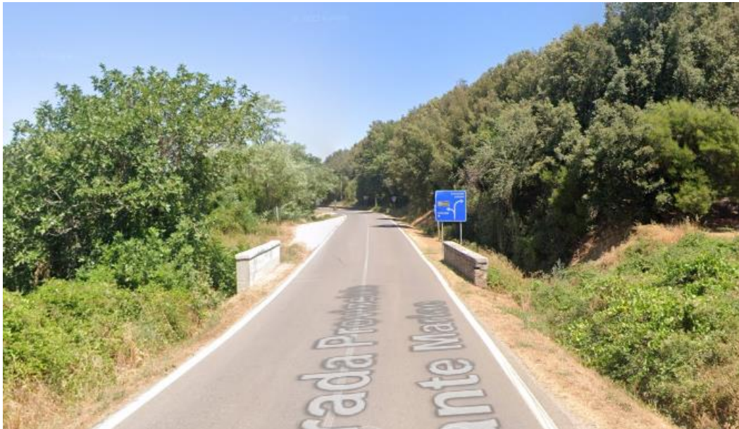
Figure 23 -Stato di fatto sito intervento 14
