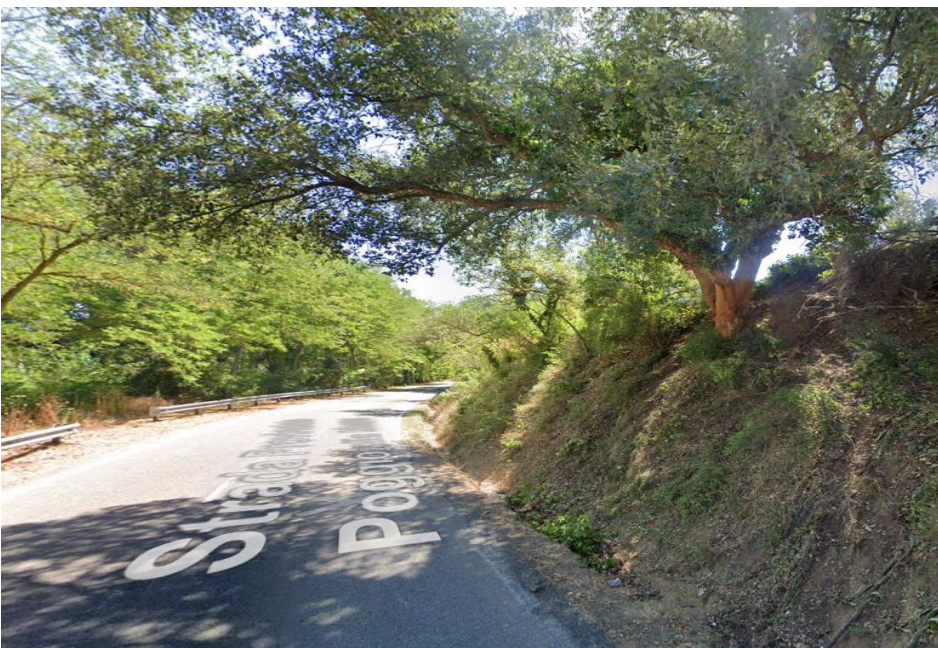
Figure 45 - Stato di fatto sito intervento 36
