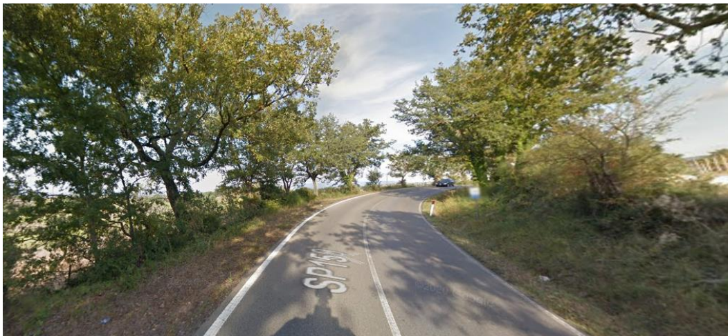
Figure 36 -Stato di fatto sito intervento 27
