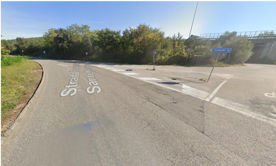
Figure 9 - Stato di fatto sito intervento 6
