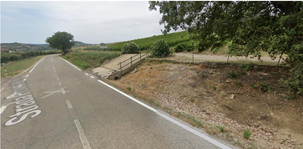
Figure 63 - Stato di fatto sito intervento 54
