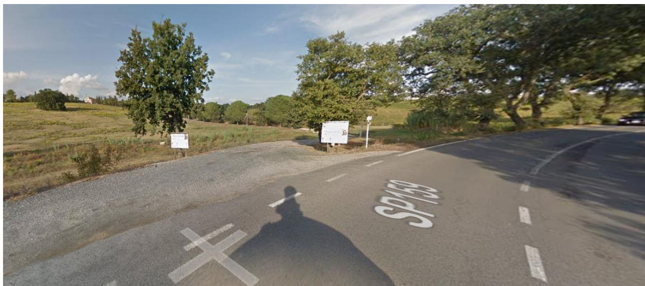
Figure 30 -Stato di fatto sito intervento 21
