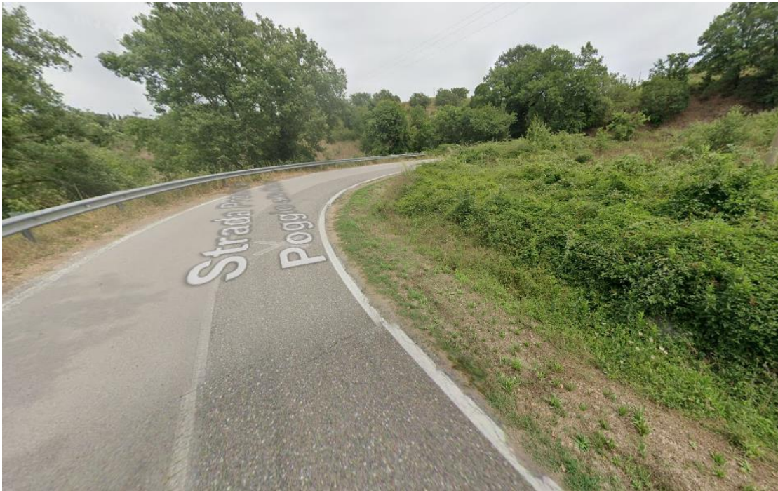
Figure 53 - Stato di fatto sito intervento 44
