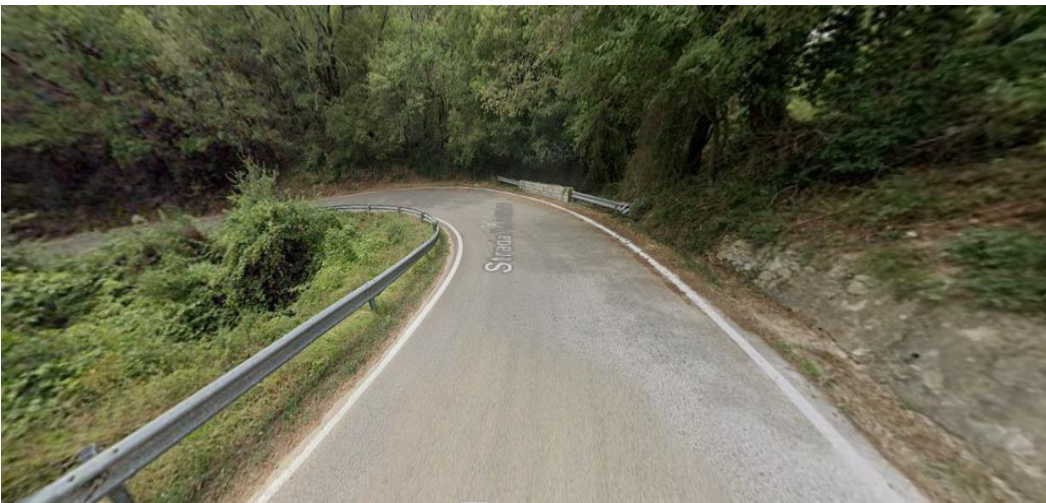
Figure 60 - Stato di fatto sito intervento 51
