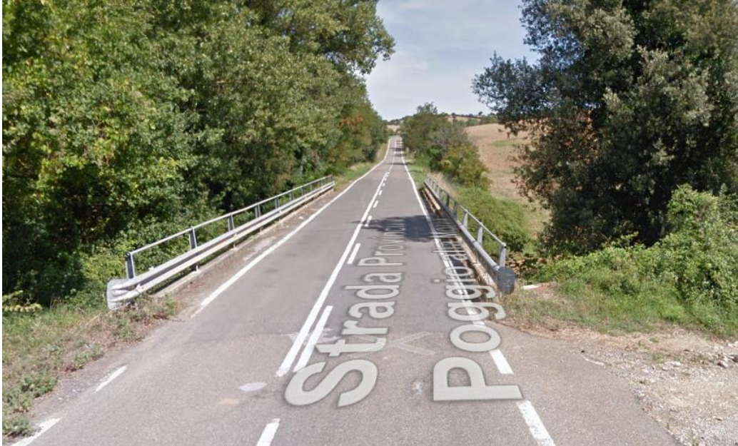
Figure 50 - Stato di fatto sito intervento 41
