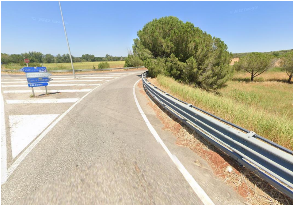
Figure 11 - Stato di fatto sito intervento 3
