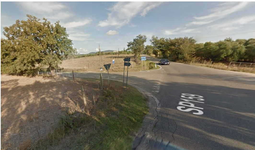
Figure 43 -Stato di fatto sito intervento 34
