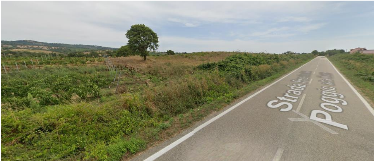
Figure 57 - Stato di fatto sito intervento 48
