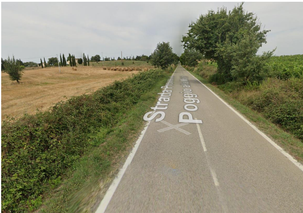
Figure 56 - Stato di fatto sito intervento 47
