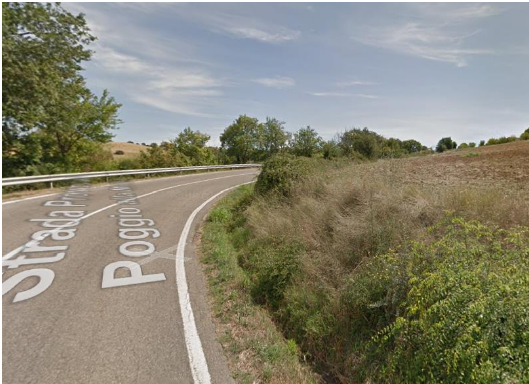
Figure 51 - Stato di fatto sito intervento 42
