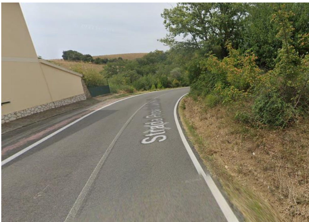
Figure 62 - Stato di fatto sito intervento 53
