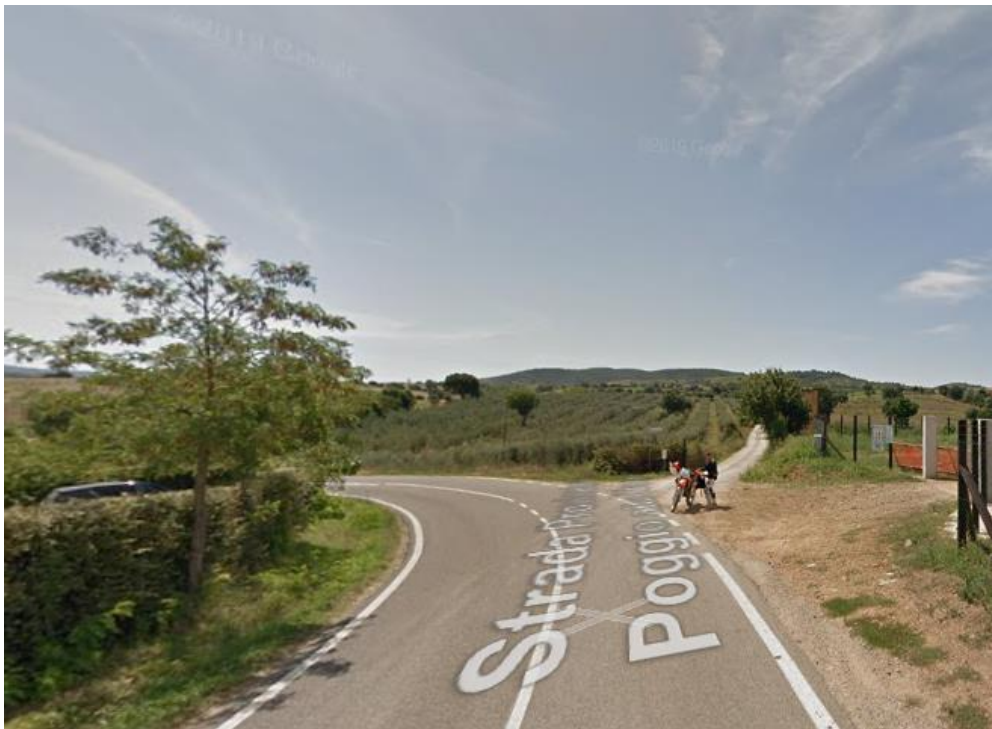
Figure 48 - Stato di fatto sito intervento 39
