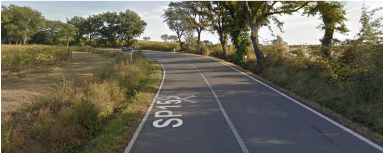
Figure 32 -Stato di fatto sito intervento 23
