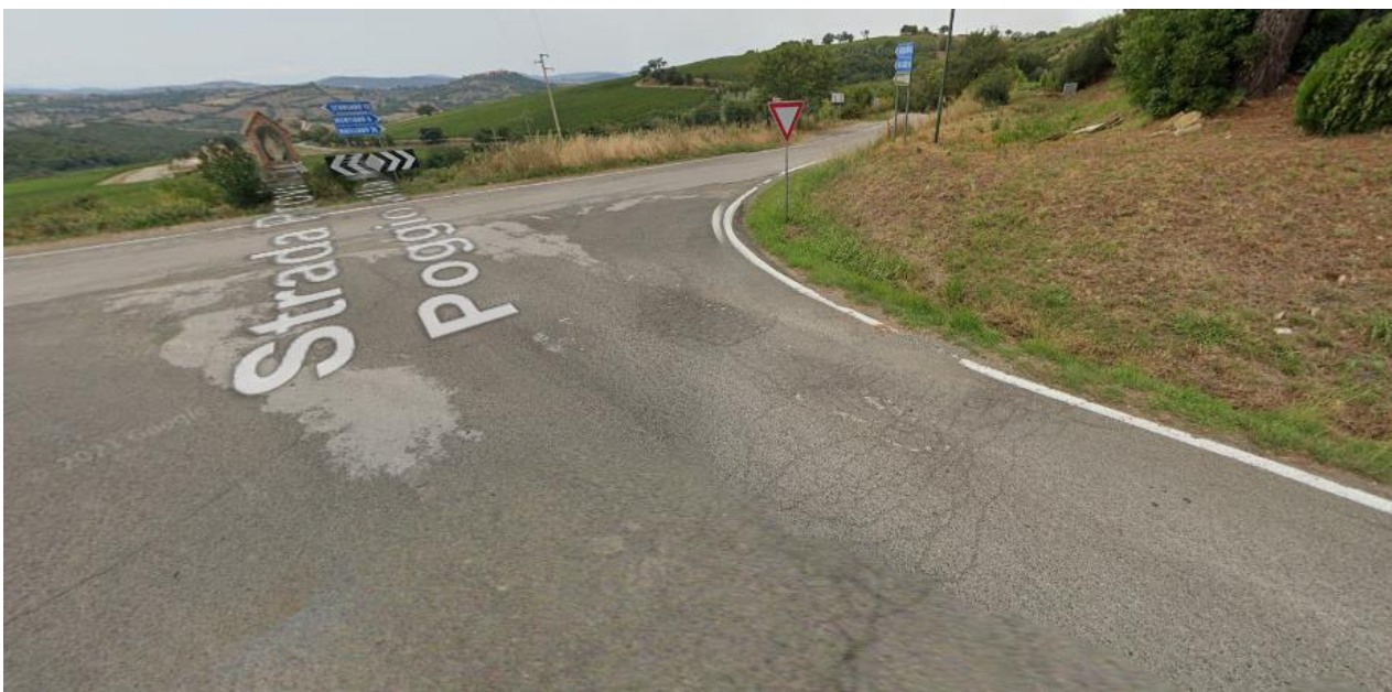
Figure 58 - Stato di fatto sito intervento 49
