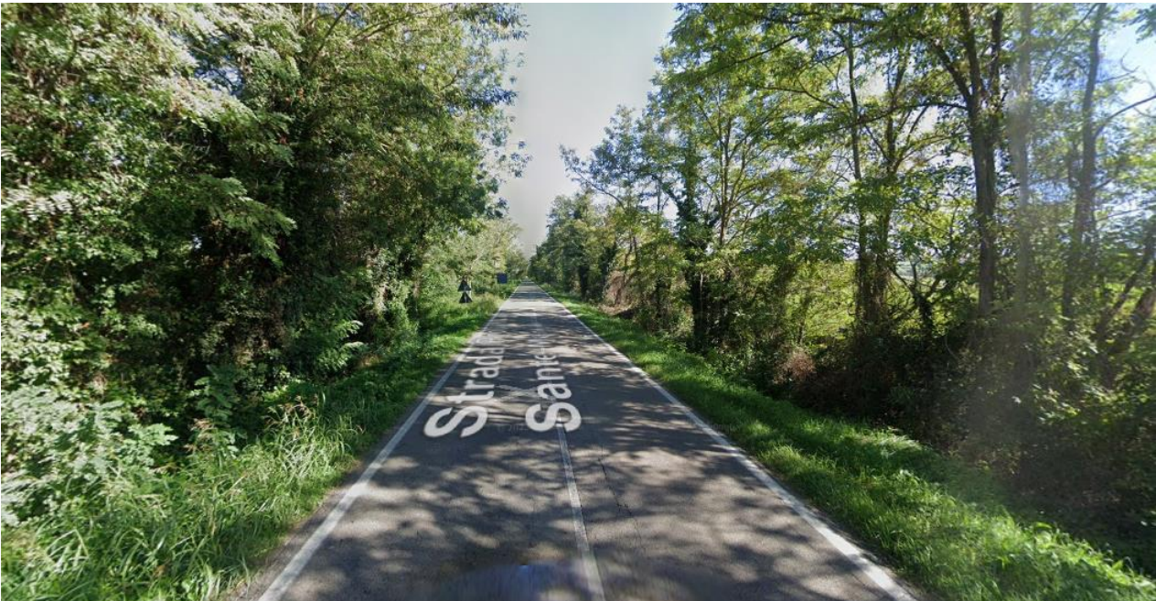
Figure 18 -Stato di fatto sito intervento 9
