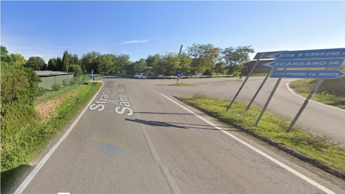
Figure 17 -Stato di fatto sito intervento 8
