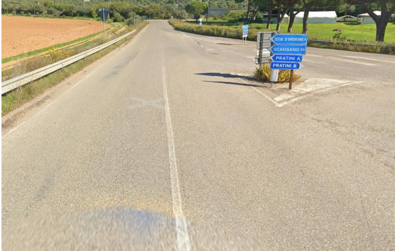
Figure 13 - Stato di fatto sito intervento 5
