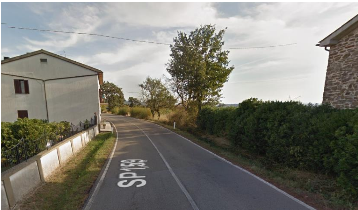
Figure 37 -Stato di fatto sito intervento 28
