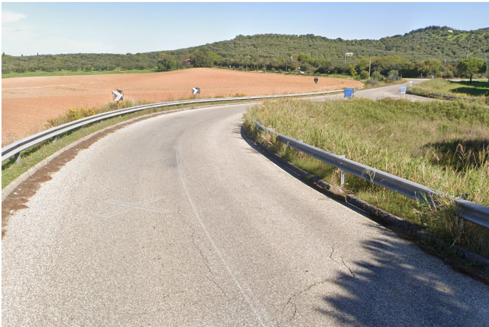
Figure 12 - Stato di fatto sito intervento 4
