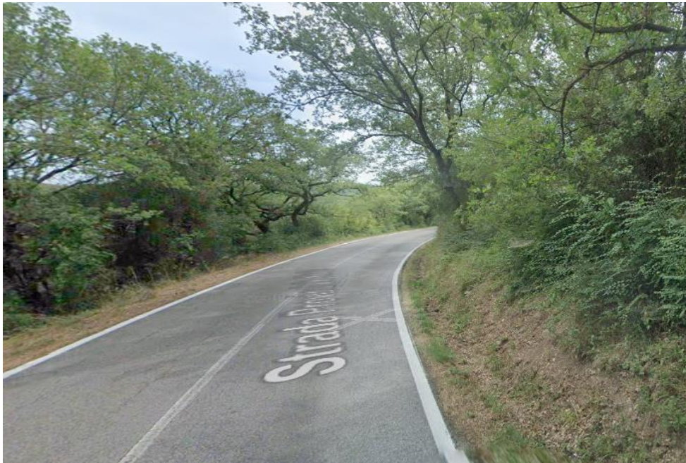
Figure 61 - Stato di fatto sito intervento 52
