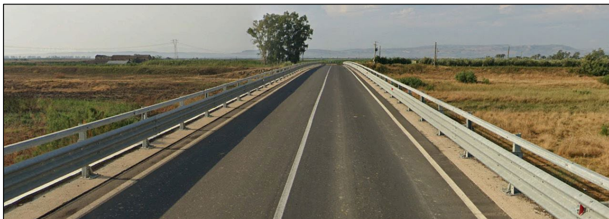
Figura 3.6 - Punto di attraversamento del cavidotto AT all'altezza del fiume Dittaino lungo la SP74/ii
