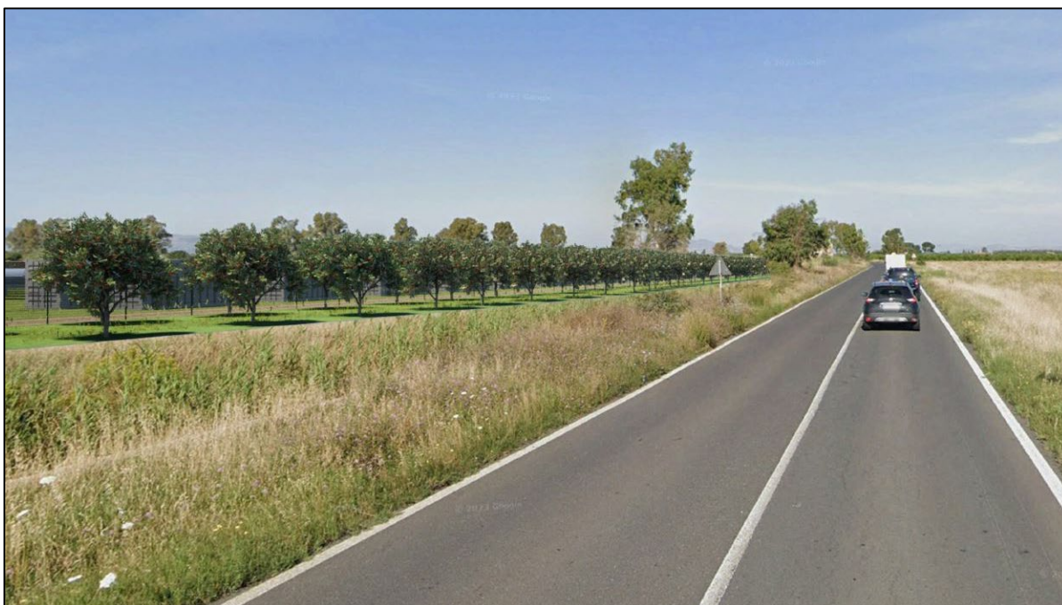
Figura 5.7 - Fotosimulazione vista Plot Ovest dalla SP 106, in corrispondenza del BESS (scatto fotografico dal punto di vista PV04 della figura 5.11). È visibile esclusivamente la fascia arborea di mitigazione che cinge tutto il perimetro dell'impianto per un'ampiezza di 10 m (la visibilità dei moduli fotovoltaici è trascurabile). Si può affermare che già dalla SP 106 (la visibilità sia bassa (poco significativa)).
