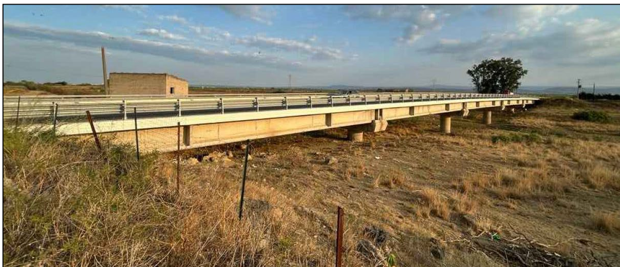
Figura 3.4 - Lato a valle del ponte per l'ancoraggio del cavidotto
