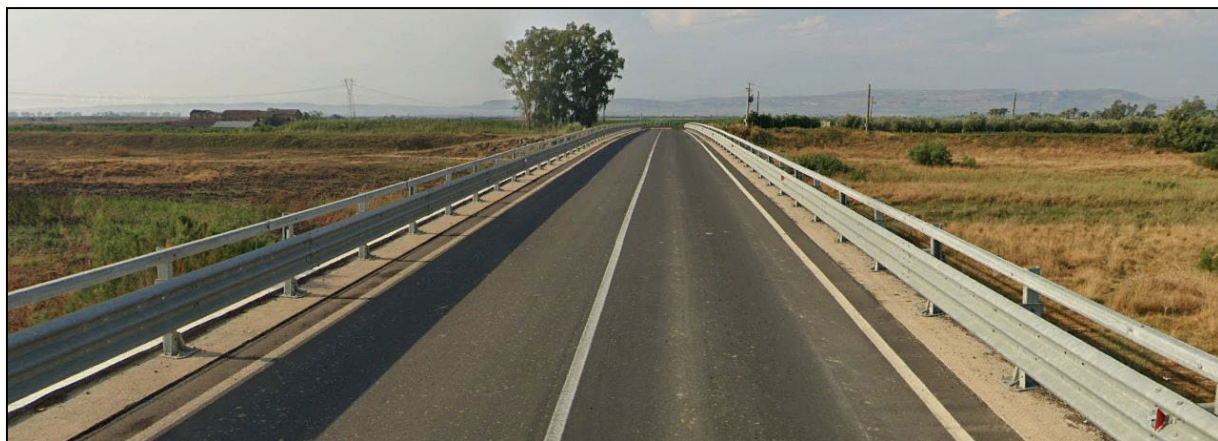
Figura 3.3 - Punto di attraversamento del cavidotto AT all'altezza del fiume Dittaino lungo la SP74/ii
