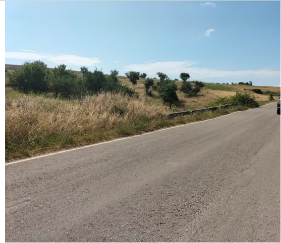
Attraversamento ponticello stradale
