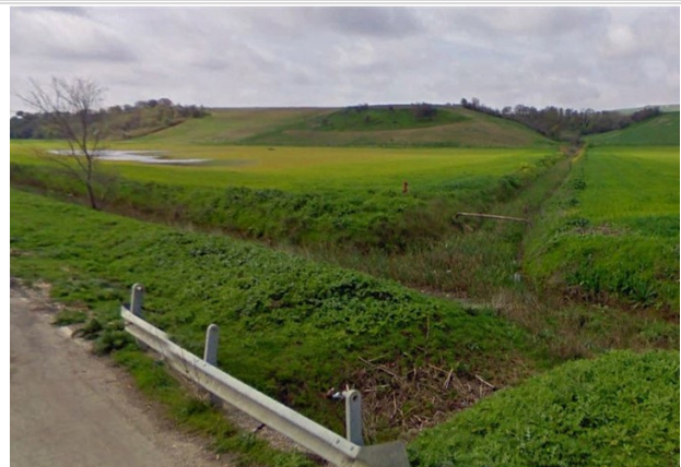
Attraversamento canale di scolo
