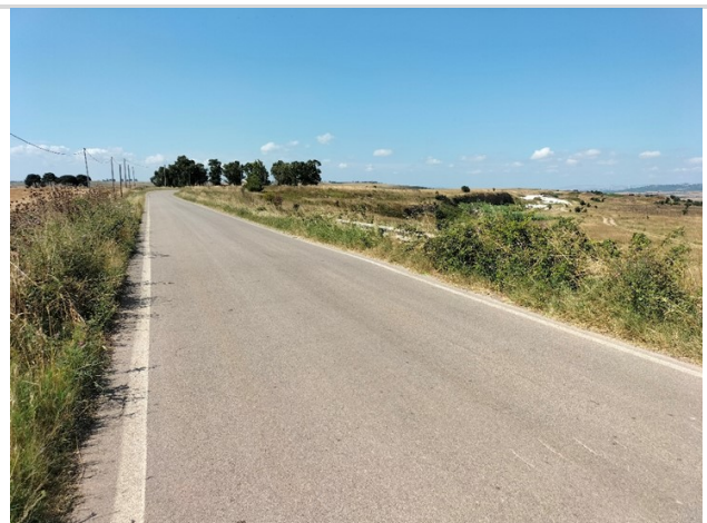
Attraversamento ponticello stradale
