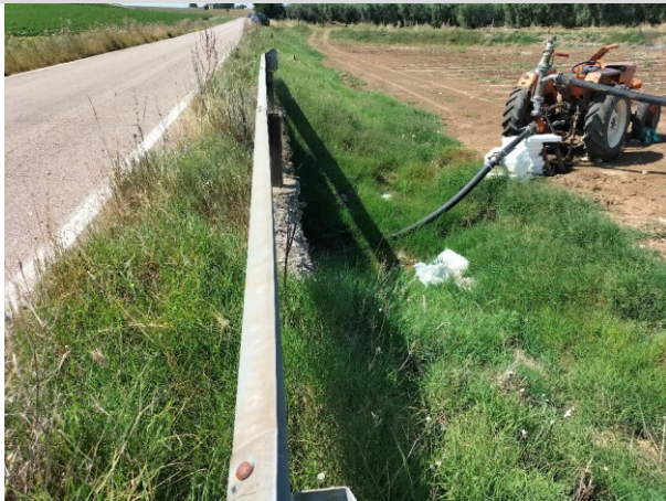
Attraversamento canale idrico
