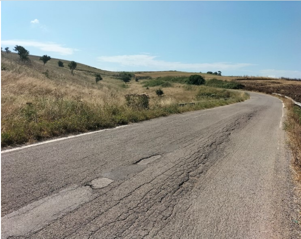
Attraversamento ponticello stradale
