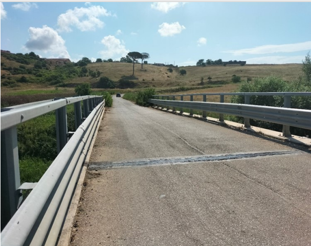
Attraversamento Fiume Fortore
