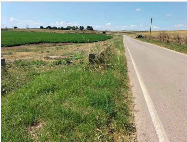
Attraversamento ponticello stradale
