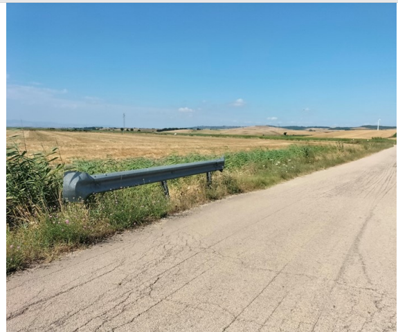
Attraversamento Vallone S.Maria dell'Ischia
