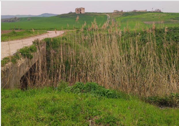
Attraversamento Vallone S.Maria dell'Ischia
