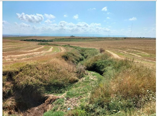
Attraversamento canale idrico
