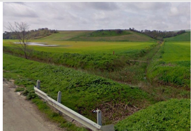
Attraversamento canale di scolo
