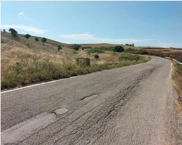
Attraversamento ponticello stradale
