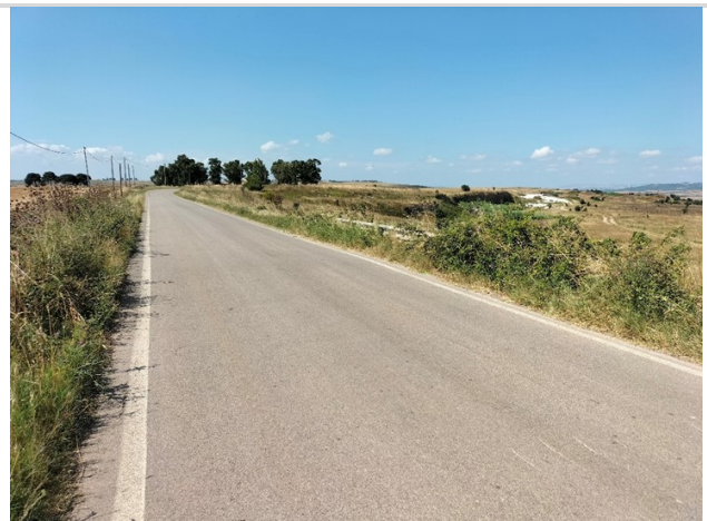
Attraversamento ponticello stradale
