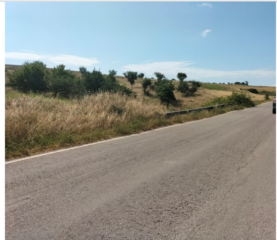
Attraversamento ponticello stradale
