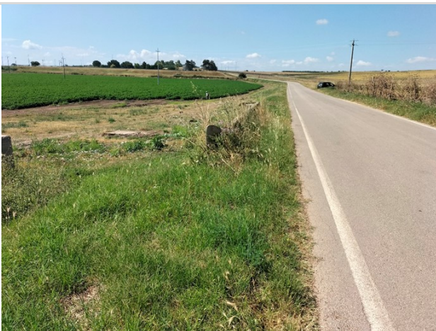
Attraversamento ponticello stradale
