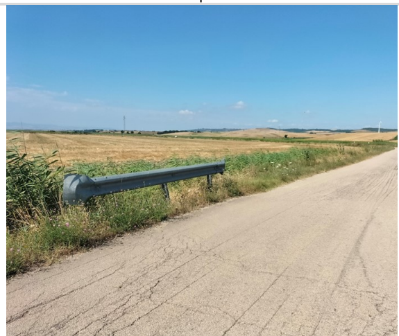
Attraversamento Vallone S.Maria dell'Ischia
