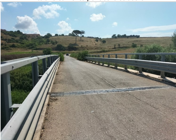
Attraversamento Fiume Fortore
