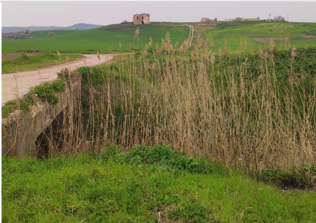
Attraversamento Vallone S.Maria dell'Ischia
