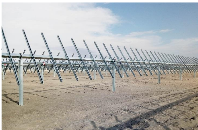
Rappresentazione della struttura di supporto – vista frontale
