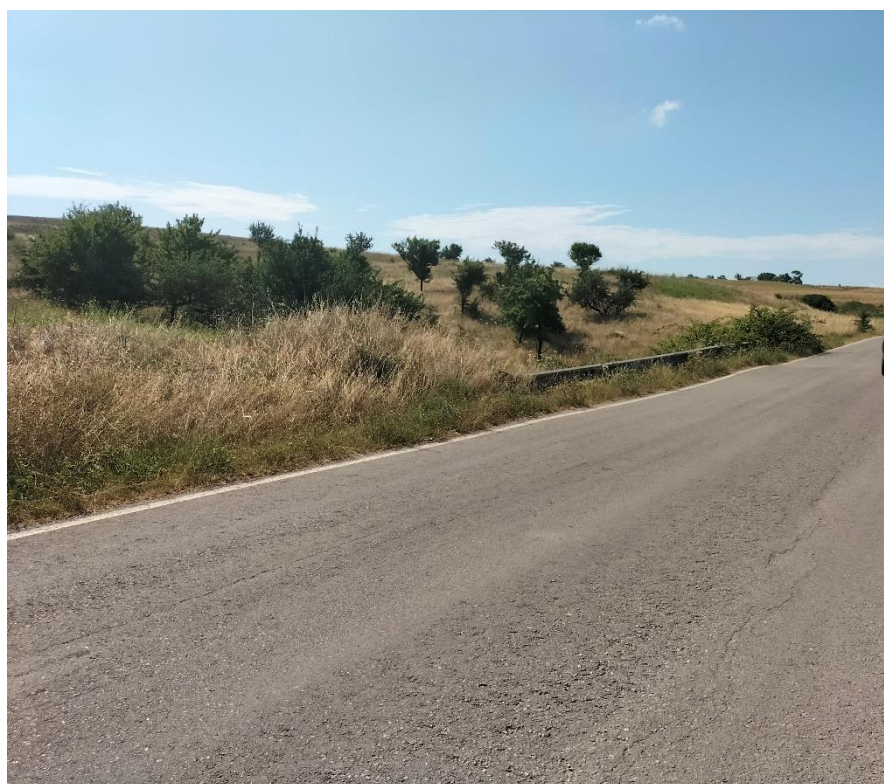
Attraversamento ponticello stradale
