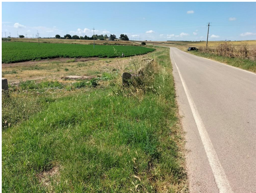
Attraversamento ponticello stradale
