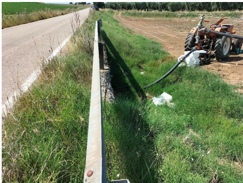
Attraversamento canale idrico
