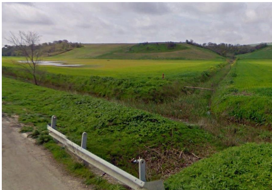
Attraversamento canale di scolo
