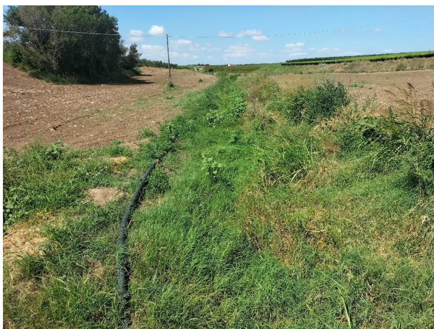
Attraversamento Vallone Carapelle
