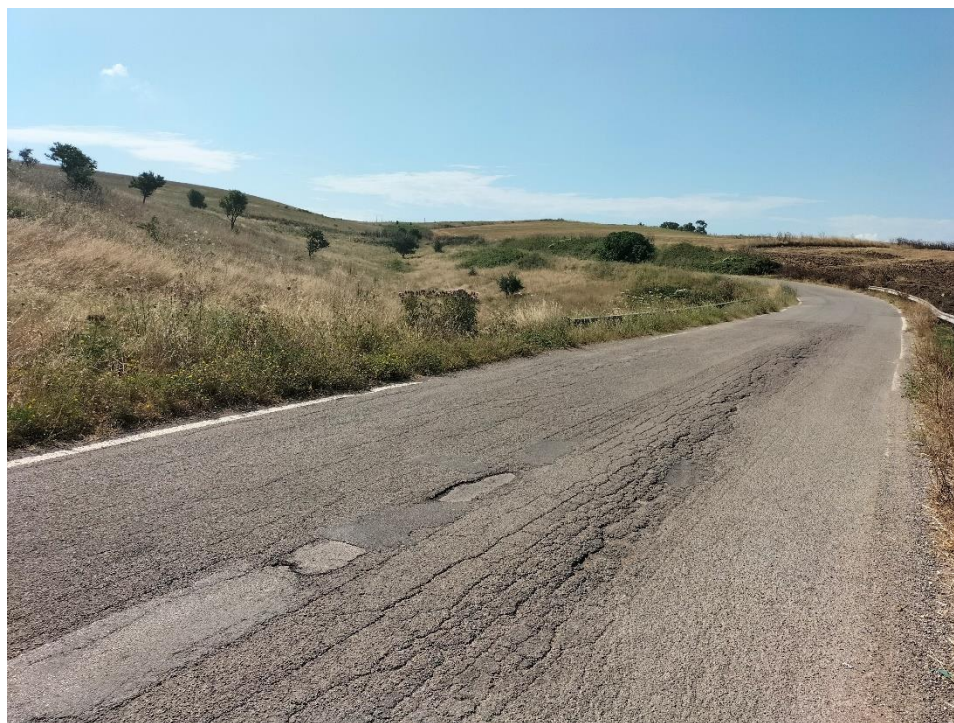
Attraversamento ponticello stradale
