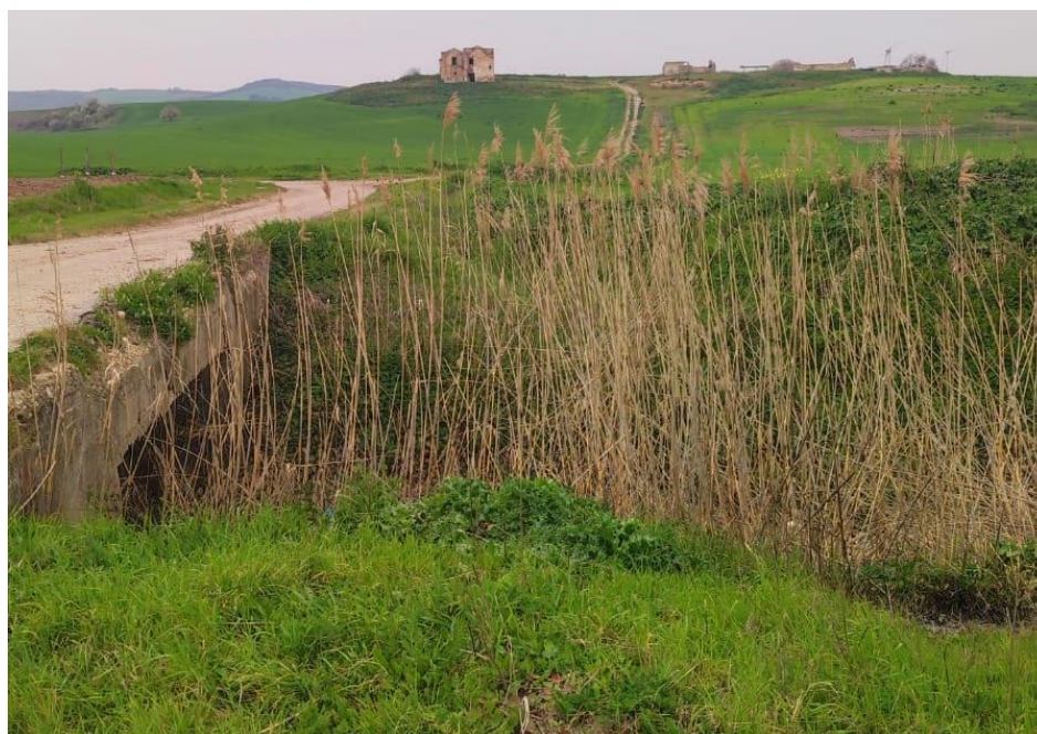
Attraversamento Vallone S.Maria dell'Ischia
