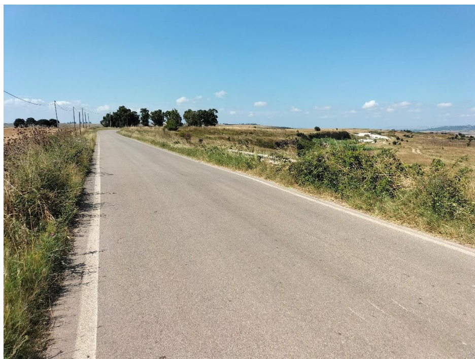
Attraversamento ponticello stradale
