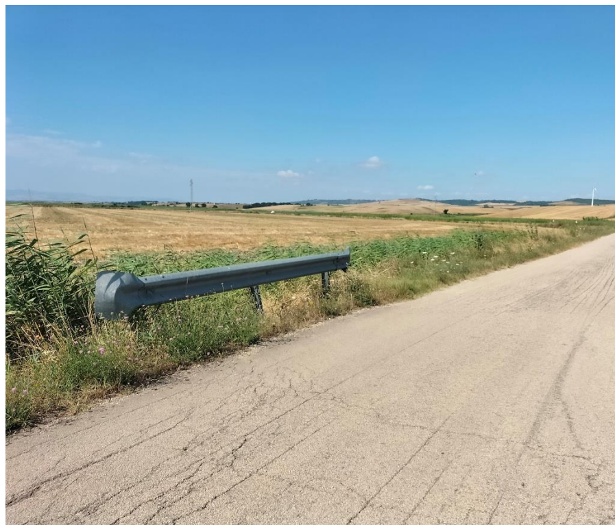
Attraversamento Vallone S.Maria dell'Ischia
