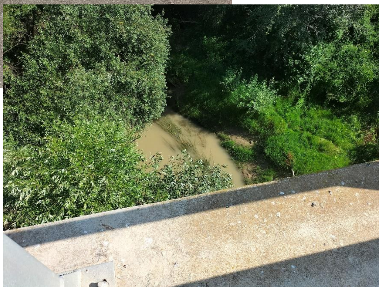
Attraversamento Fiume Fortore
