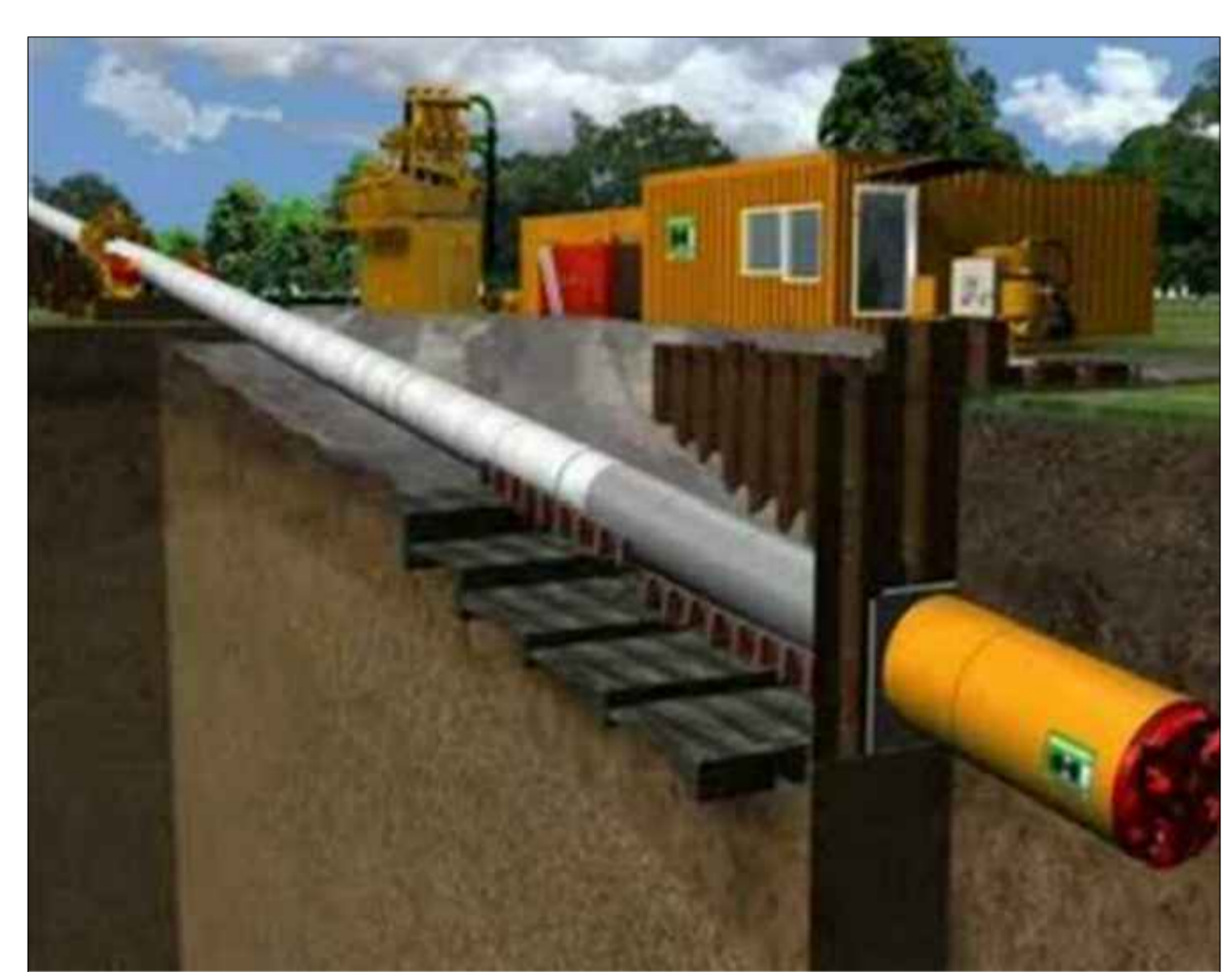
ESEMPIO ESECUZIONE TECNICA "NO DIG"
