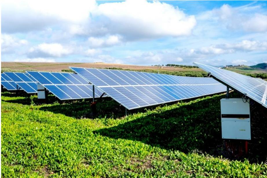
Figure 4-5. Particolare esempio di impianto agri-fotovoltaico
