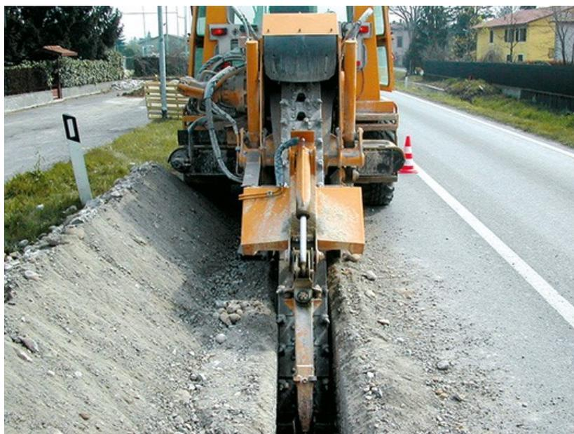
Figura 5-1. Esempio di mezzo di piccole dimensioni per la realizzazione dello scavo per la posa del cavidotto.
