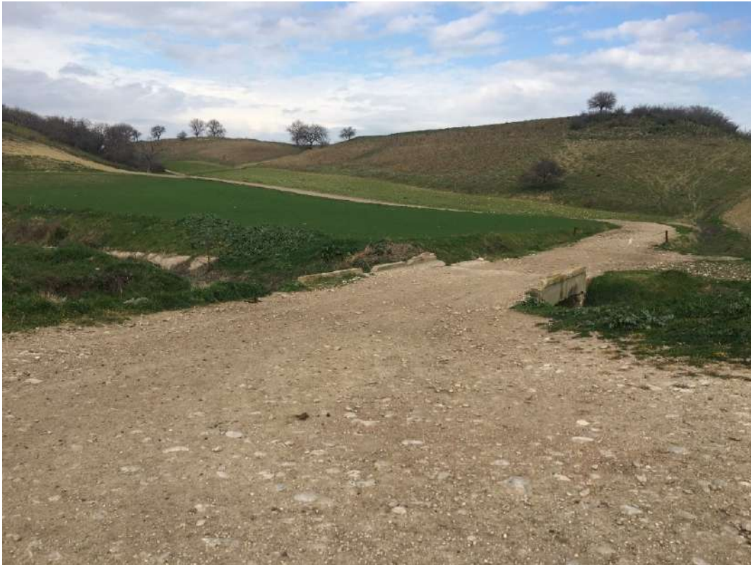
Figura 3-8 Strada interpodereale tratto attraversato con tecnica no dig
