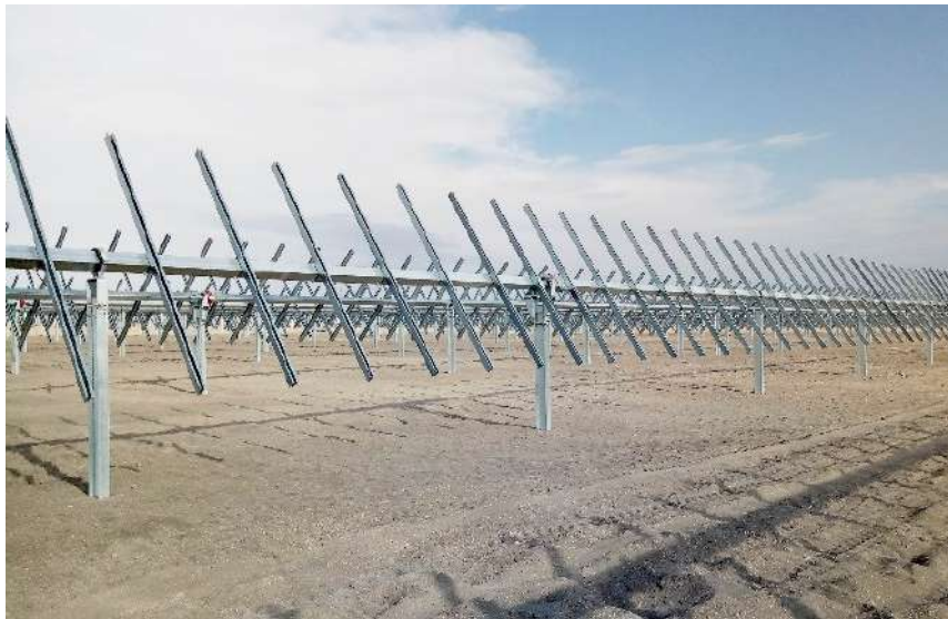
Figure 6-3 Rappresentazione della struttura di supporto
