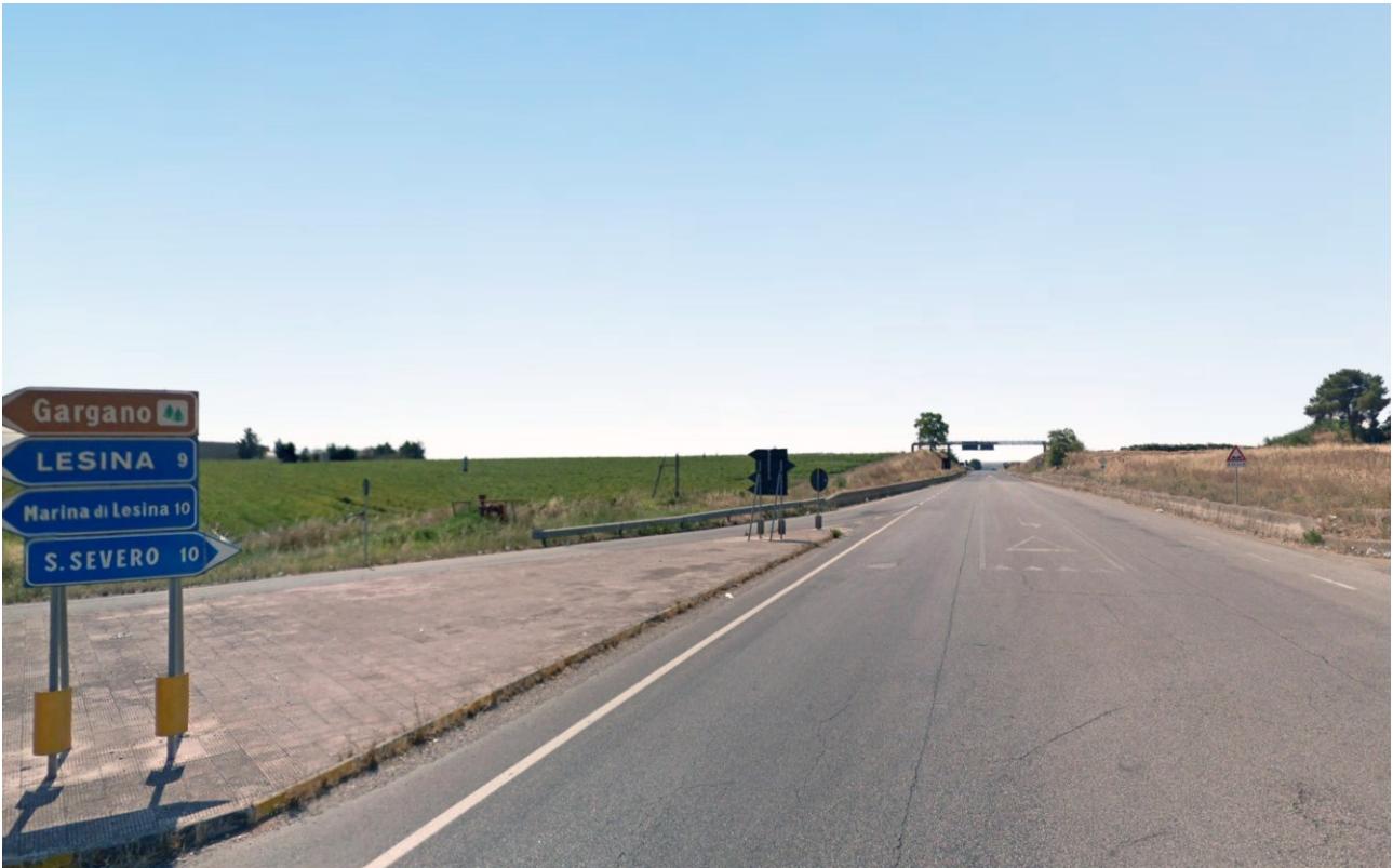
Foto 4 SS16 direzione Foggia_ L'osservatore è posizionato a circa 4,5 Km dall'area d'intervento
