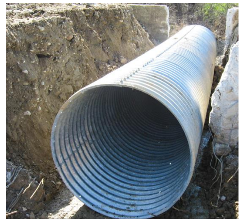
Figura 85. Esempio tubo Armco.
