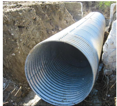
Figura 85. Esempio tubo Armco.
