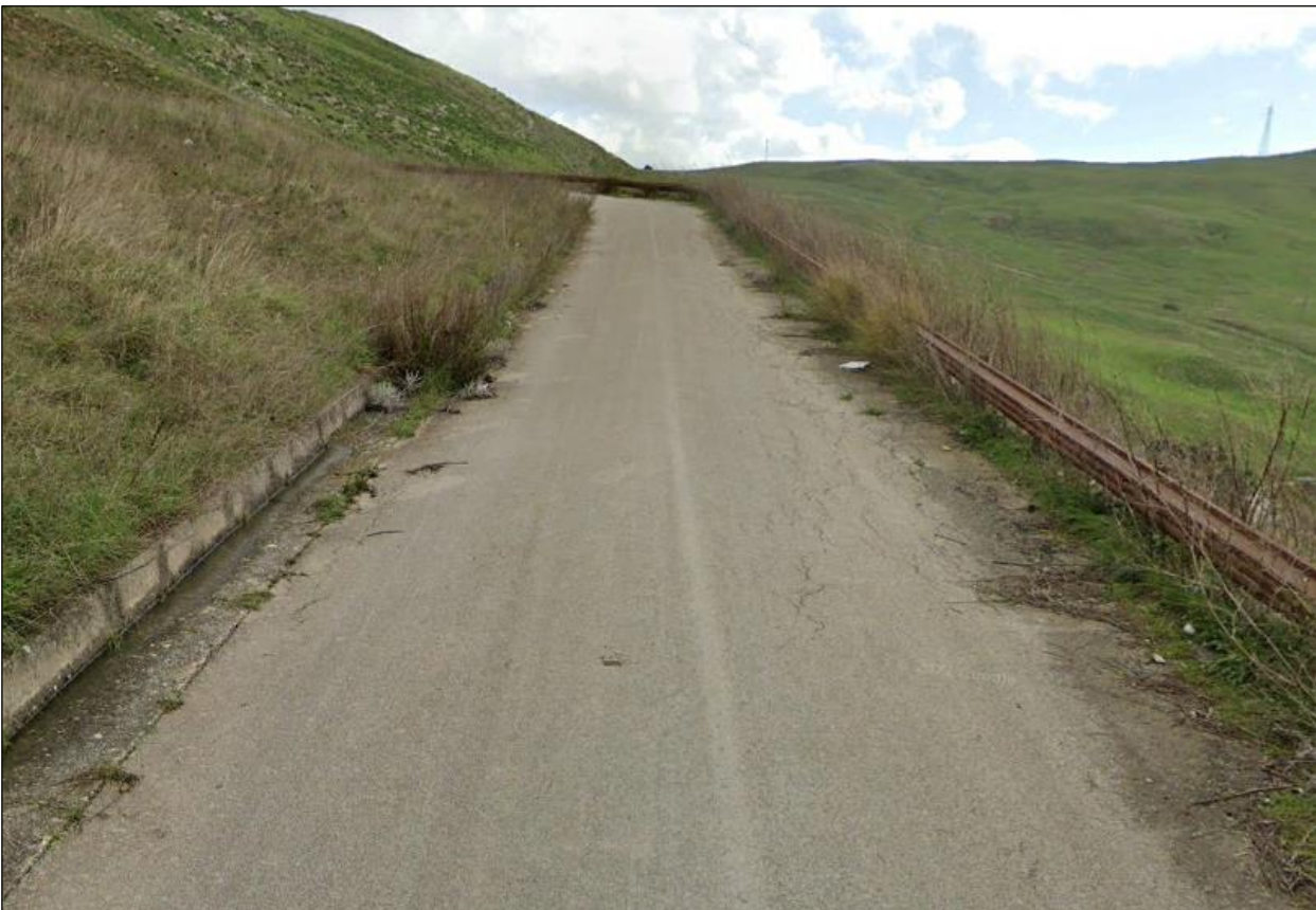
Figura 48. Tratto della SP 102 nel quale verrà interrato il cavidotto 36 kV, che attraversa l'habitat 34.6 "Praterie a specie perennanti (Lygeo-Stipetea)"
