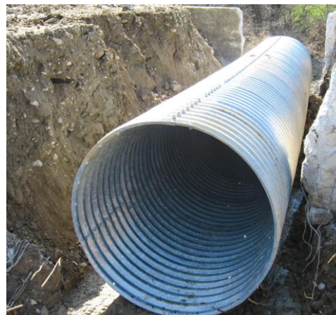
Figura 7. Esempio tubo Armco.
