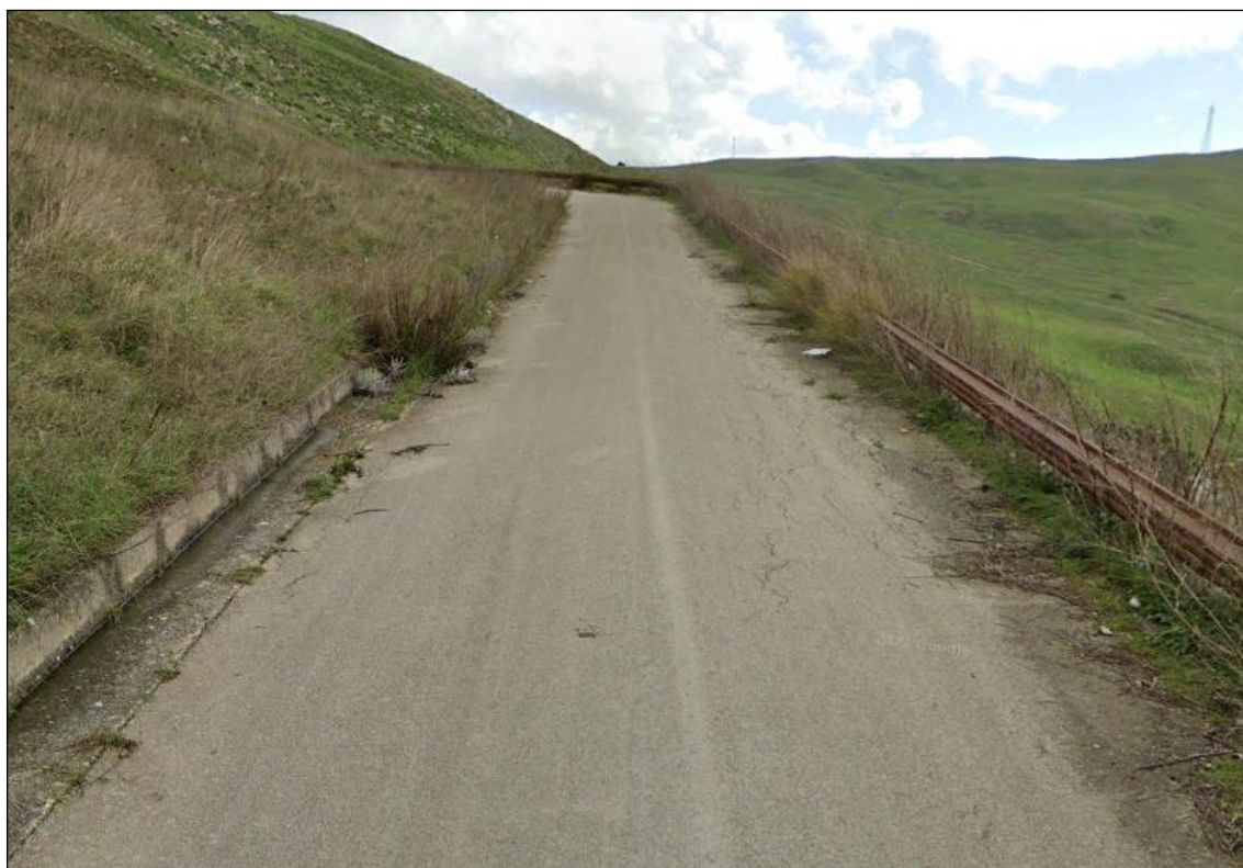
Figura 21. Tratto della SP 102 nel quale verrà interrato il cavidotto 36 kV, che attraversa l'habitat 34.6 "Praterie a specie perennanti ( Lygeo-Stipetea )"
