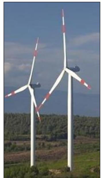
Figura 122. Esempio utilizzo di misure (bande rosse/bianche) che rendono visibile il movimento delle pale.
