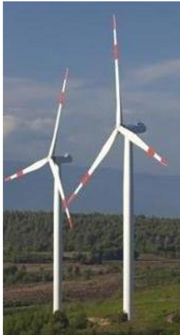
Figura 8: Esempio utilizzo di misure (bande rosse/bianche) che rendono visibile il movimento delle pale.
