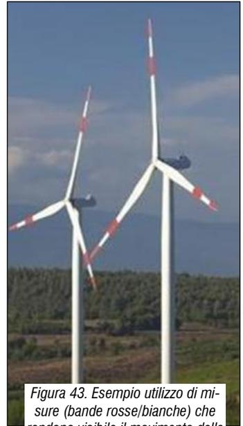
Figura 43. Esempio utilizzo di misure (bande rosse/bianche) che rendono visibile il movimento delle pale.
