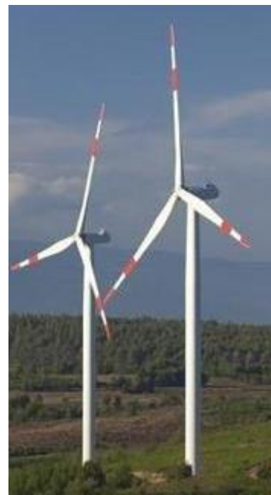
Figura 13. Esempio utilizzo di misure (bande rosse/bianche) che rendono visibile il movimento delle pale.18
