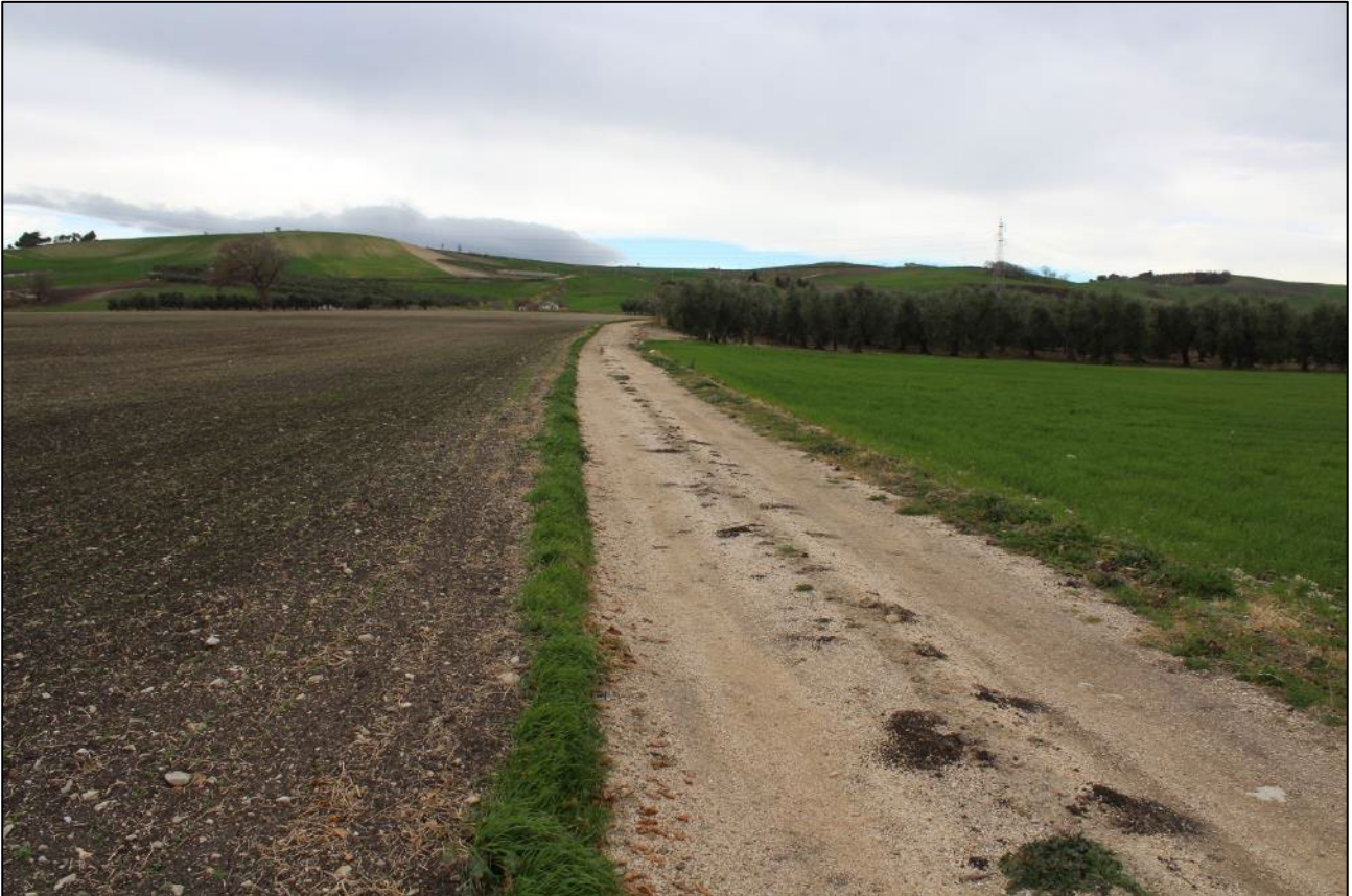
12. Località Masseria De Maria/Masseria Agostinelli, tratto del cavidotto esterno diretto a WSW
