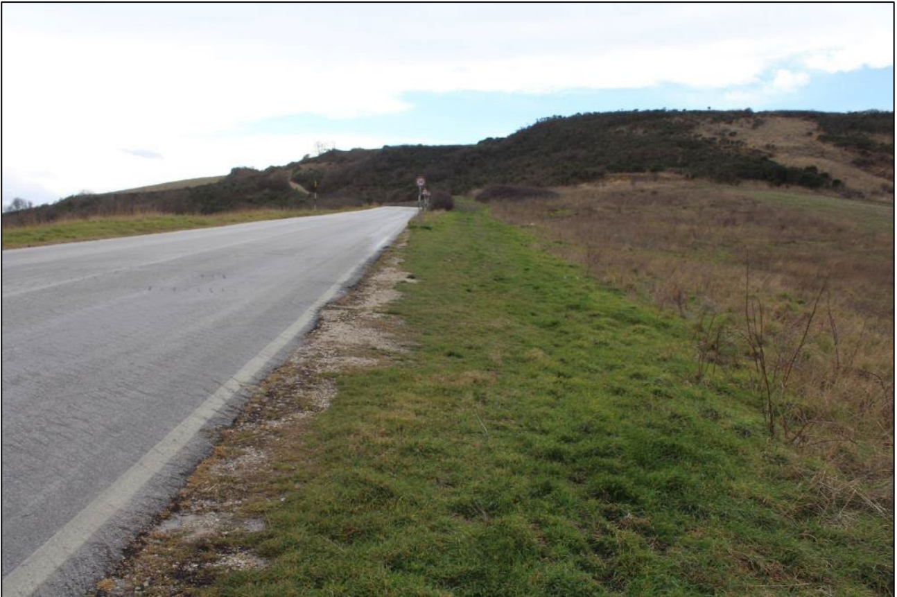
59. Località Colle San Nicola, tratto del cavidotto esterno diretto a SSW
