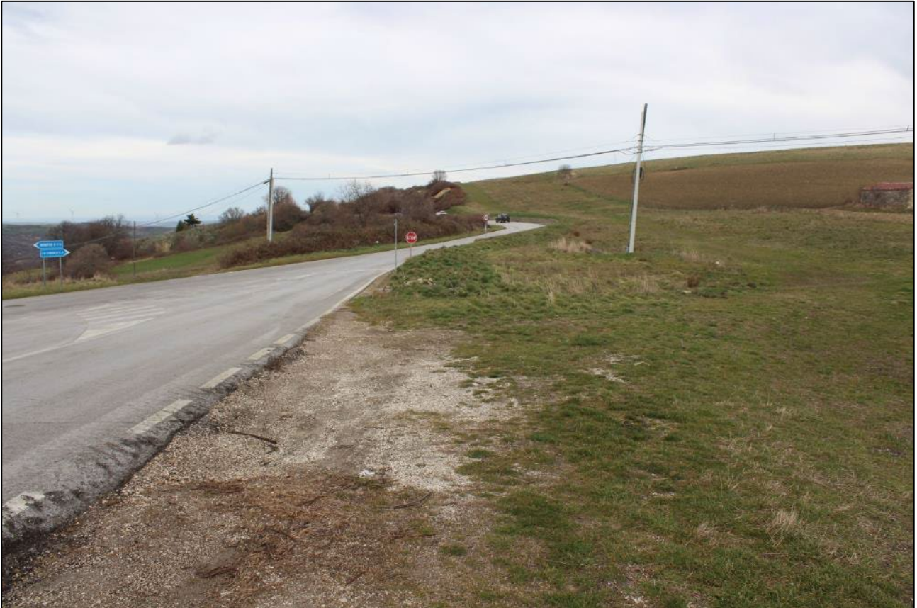
58. Località Colle San Nicola, tratto del cavidotto esterno diretto a NNE
