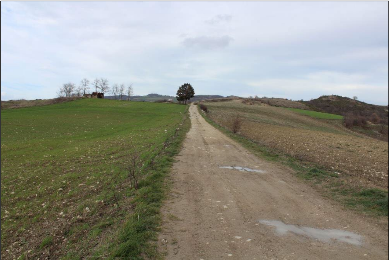
80. Località Versità/Monte delle Case, tratto del cavidotto interno diretto a NNW
