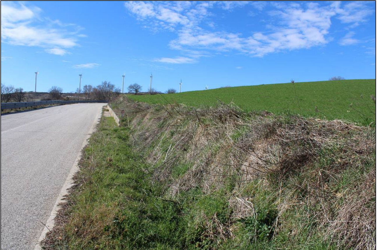
129. Località Taverna Cerrosecco, tratto del cavidotto interno diretto a WSW lungo la SS 87
