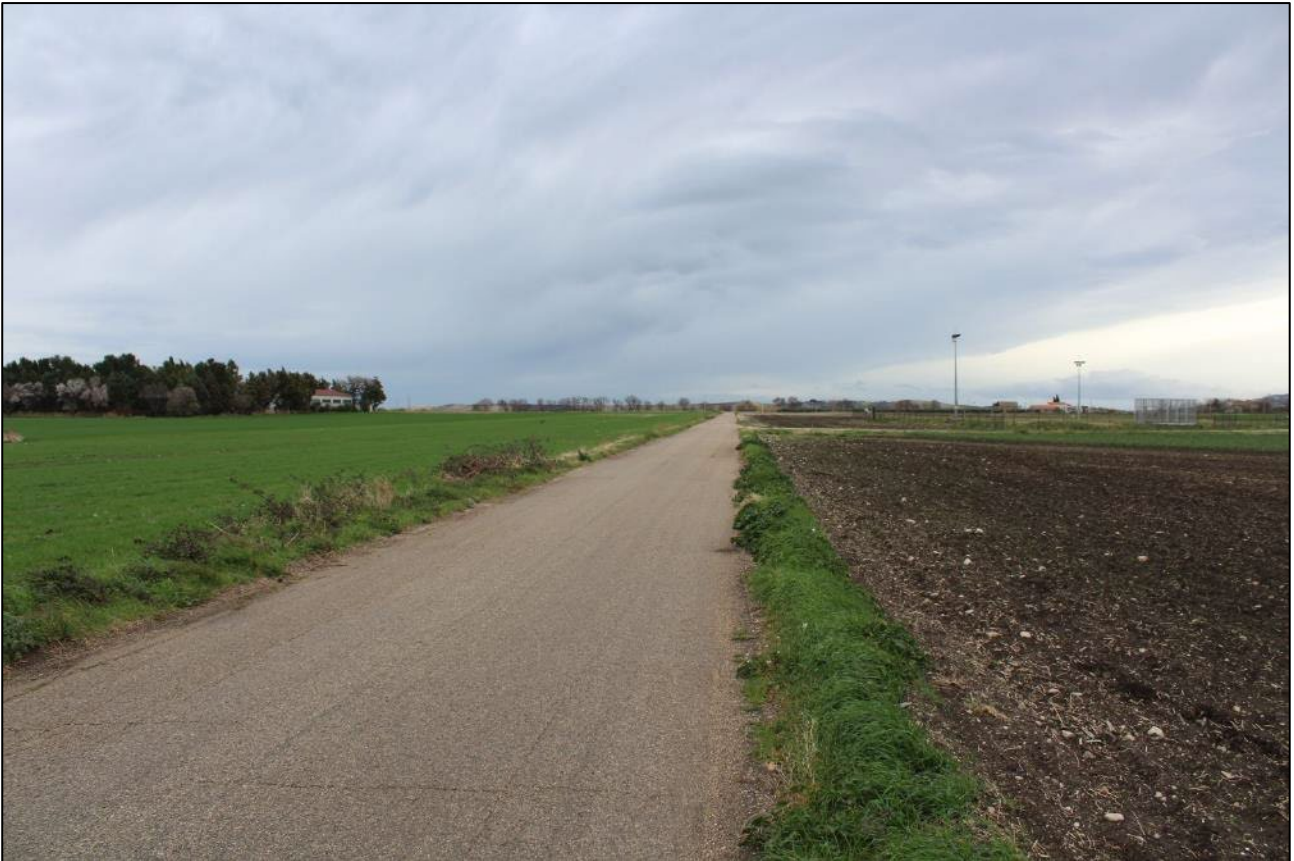
21. Località Piano Palazzo, tratto del cavidotto esterno diretto a NW
