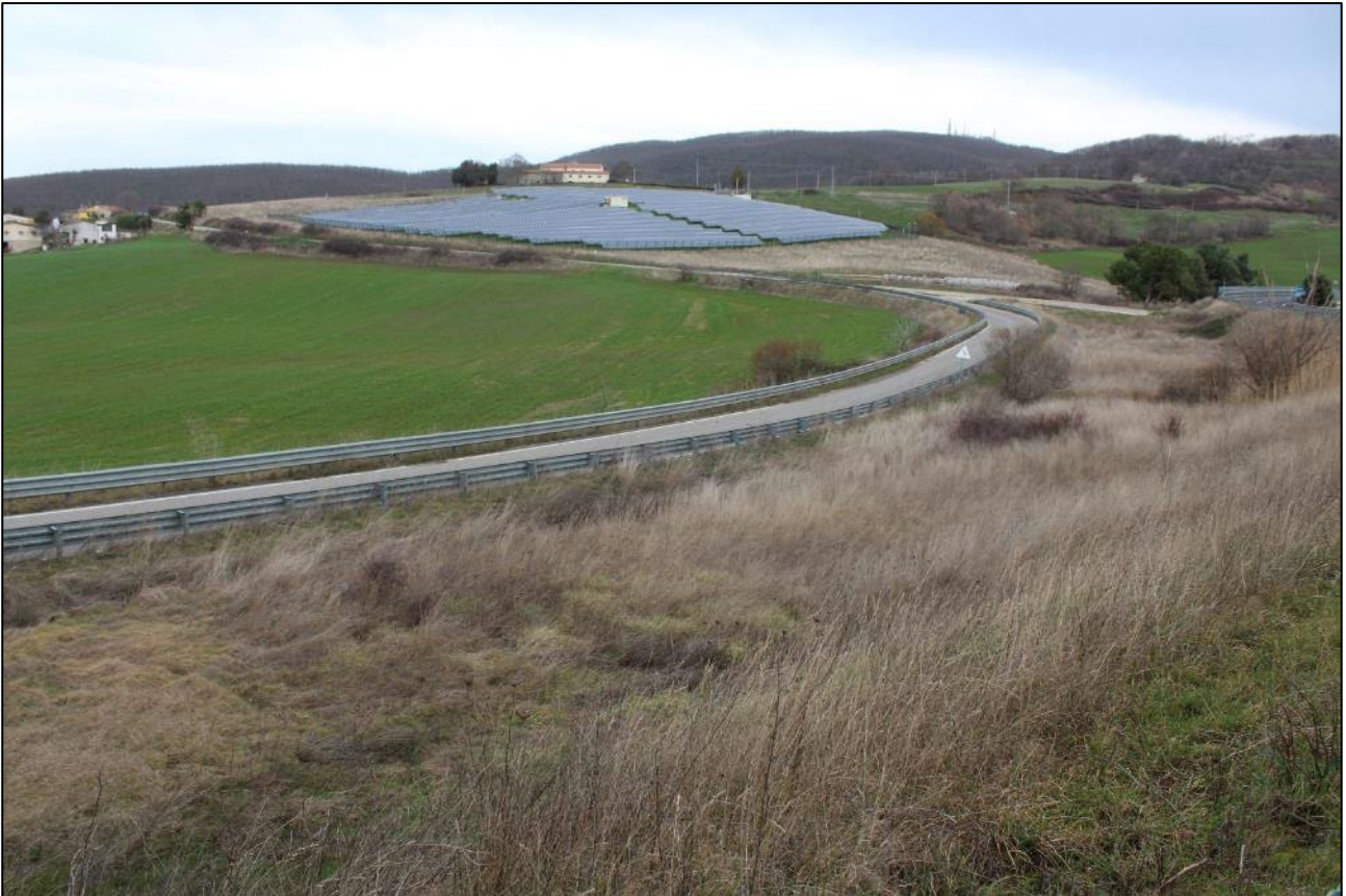
102. Località Masseria San Vito, tratto del cavidotto interno diretto a ENE, in direzione dell'aerogeneratore T7
