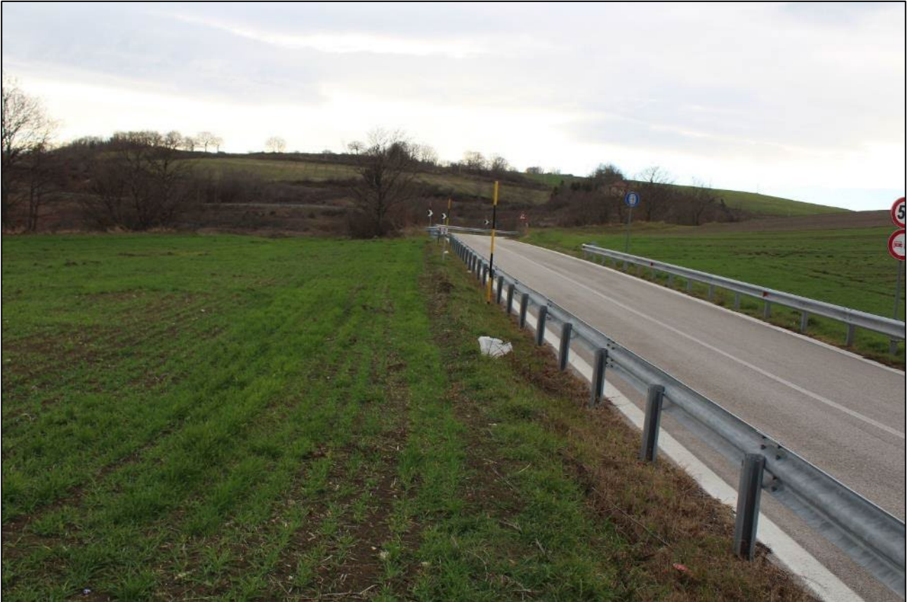
109. Località Masseria San Vito, tratto del cavidotto interno diretto a WSW lungo la SP 146
