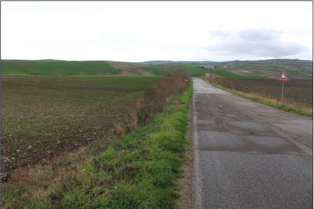
27. Località Piano Palazzo/Casa Cantoniera, tratto del cavidotto esterno diretto a WSW lungo Via delle Croci
