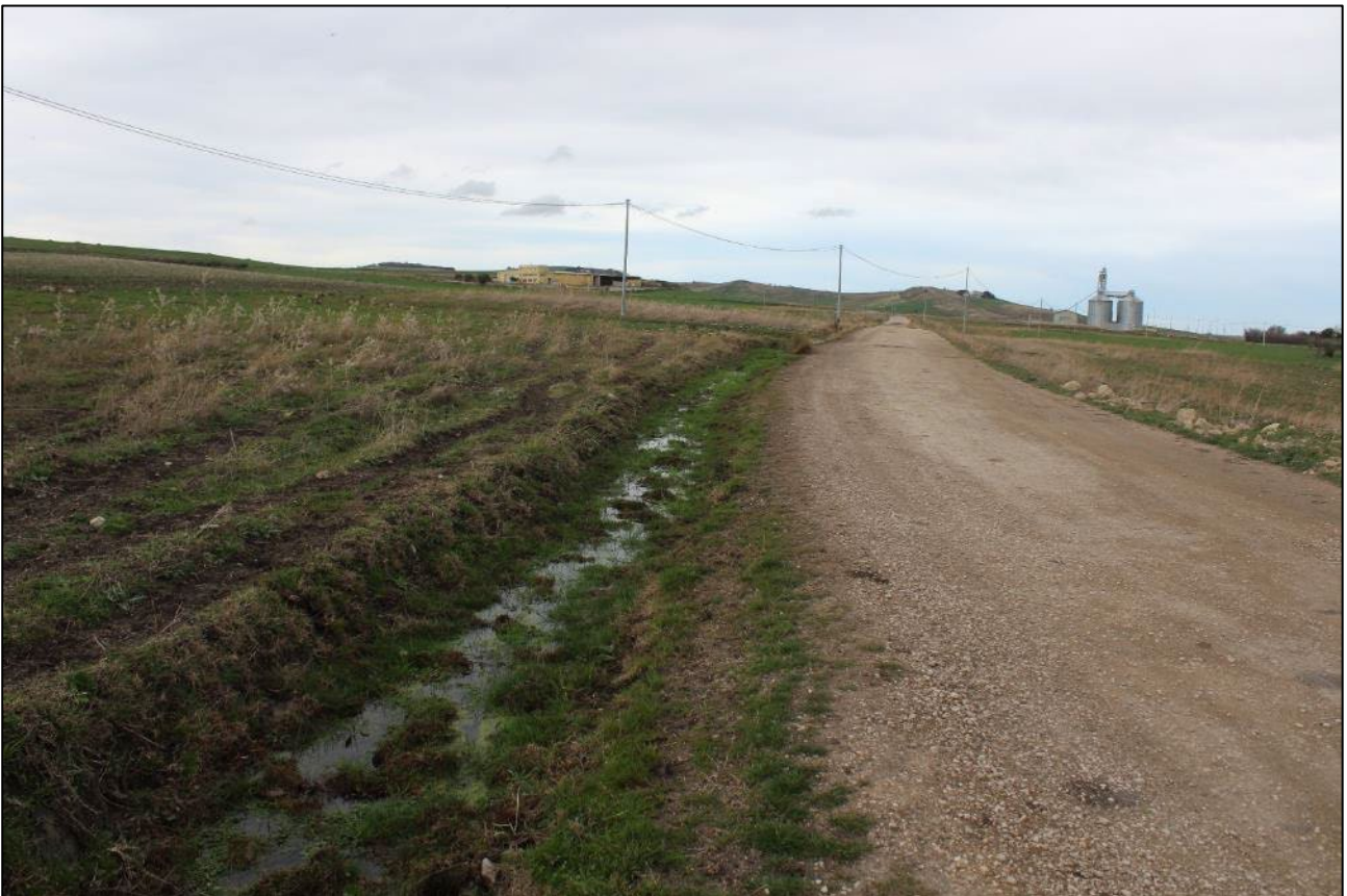
32. Località Masseria Petrucci, tratto del cavidotto esterno diretto a NNW
