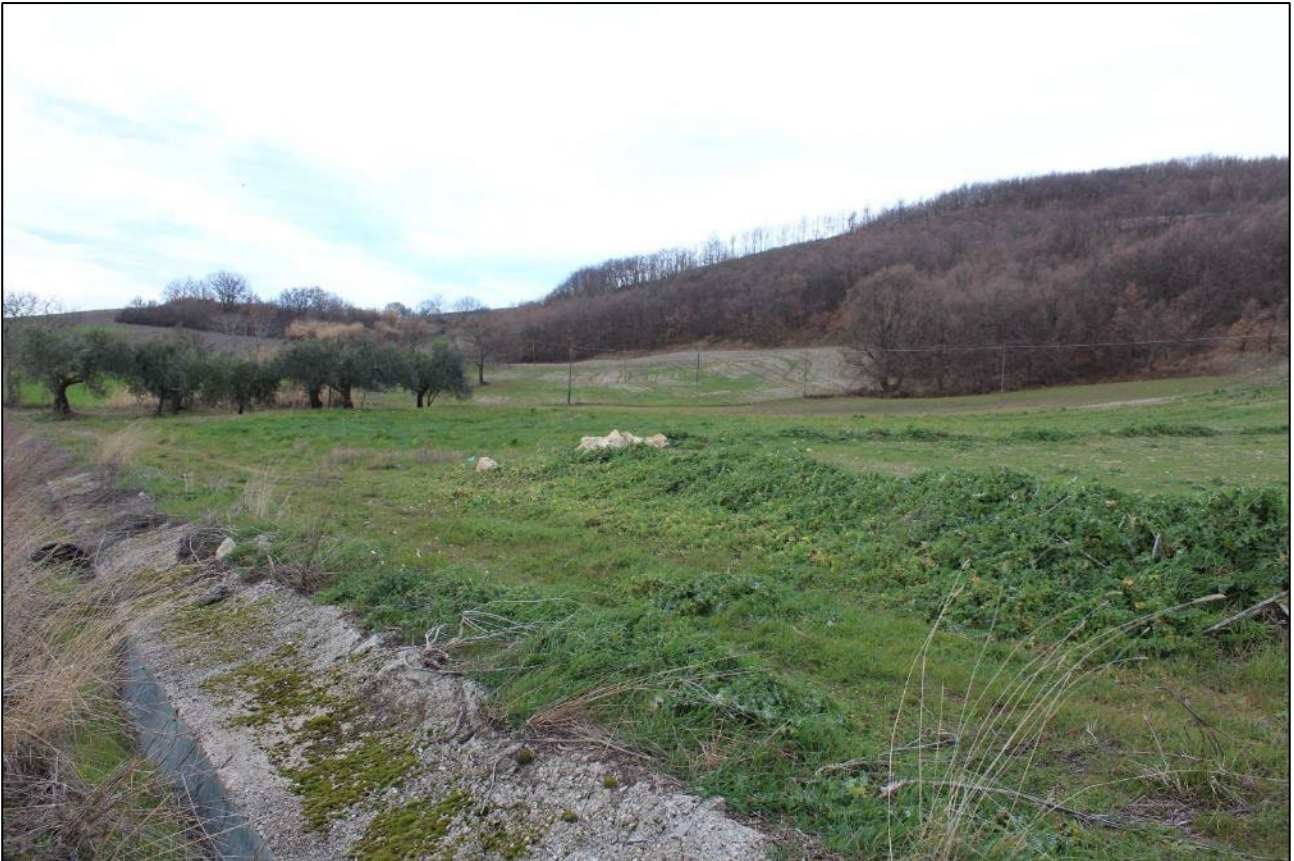
90. Località Masseria Canale, tratto del cavidotto interno diretto a NW, in direzione dell'aerogeneratore T8
