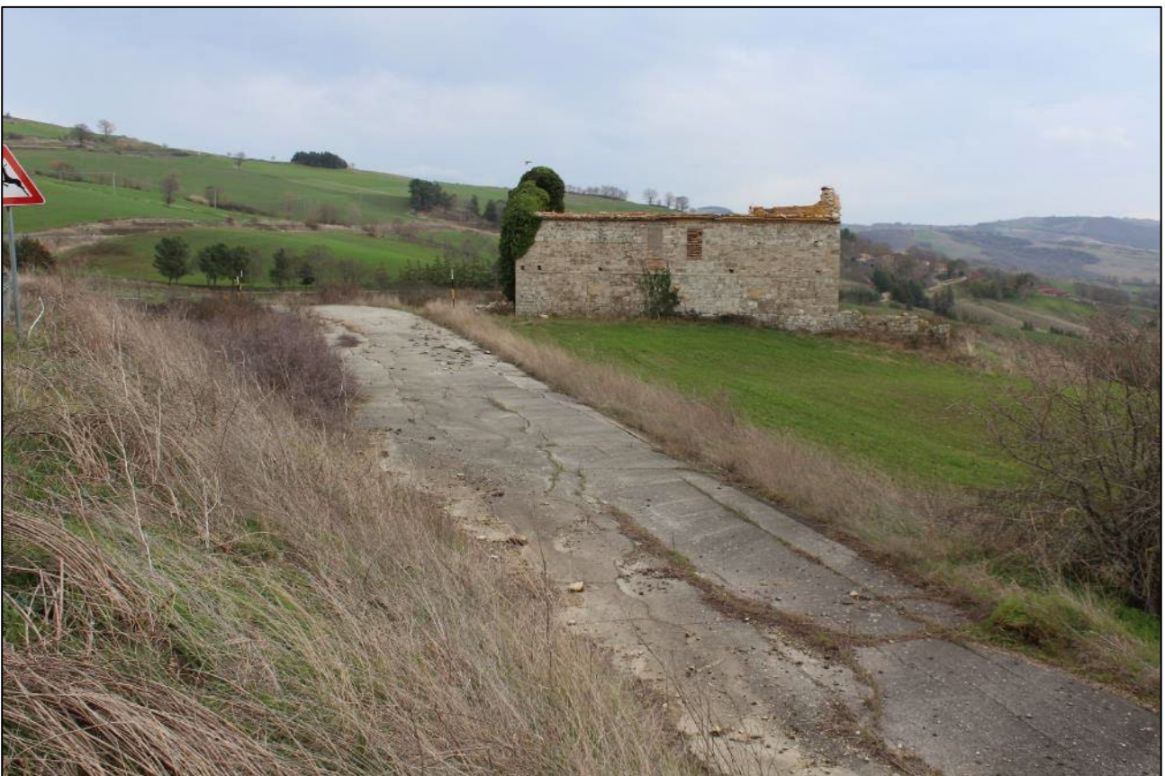
101. Località Masseria San Vito, tratto del cavidotto interno diretto a E, in direzione dell'aerogeneratore T6
