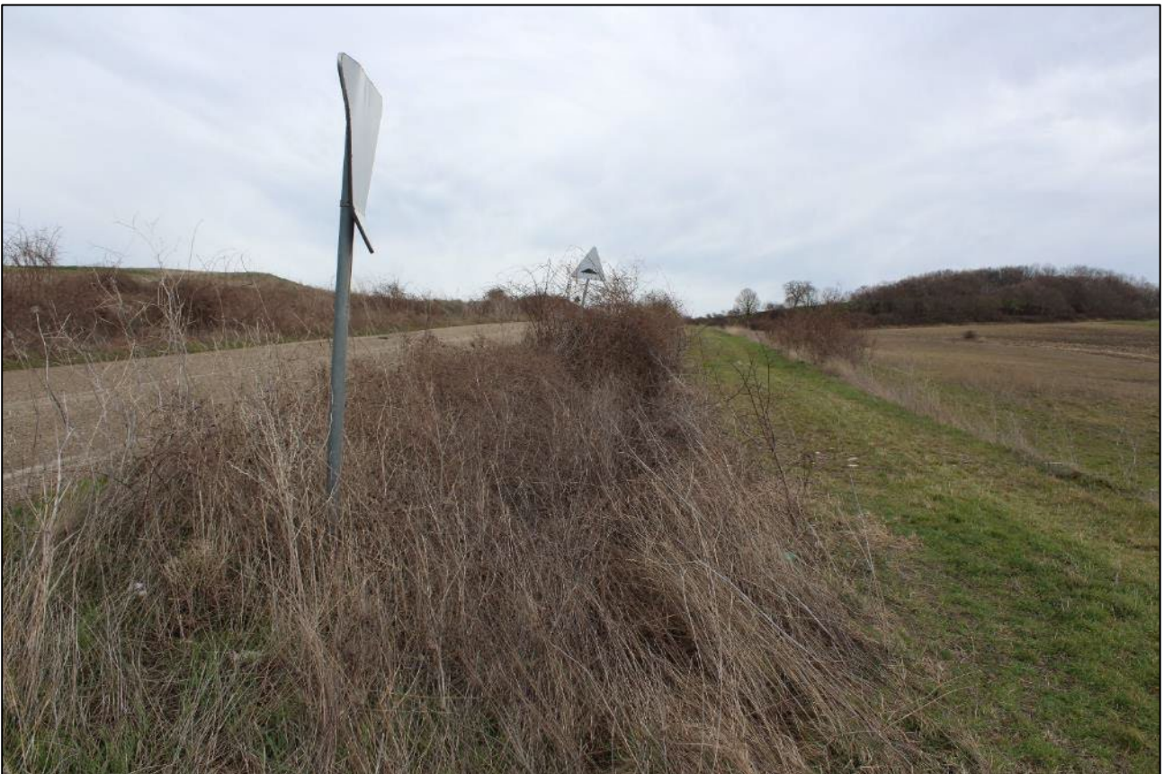
66. Località Masseria Carnevale, tratto del cavidotto esterno diretto a ENE
