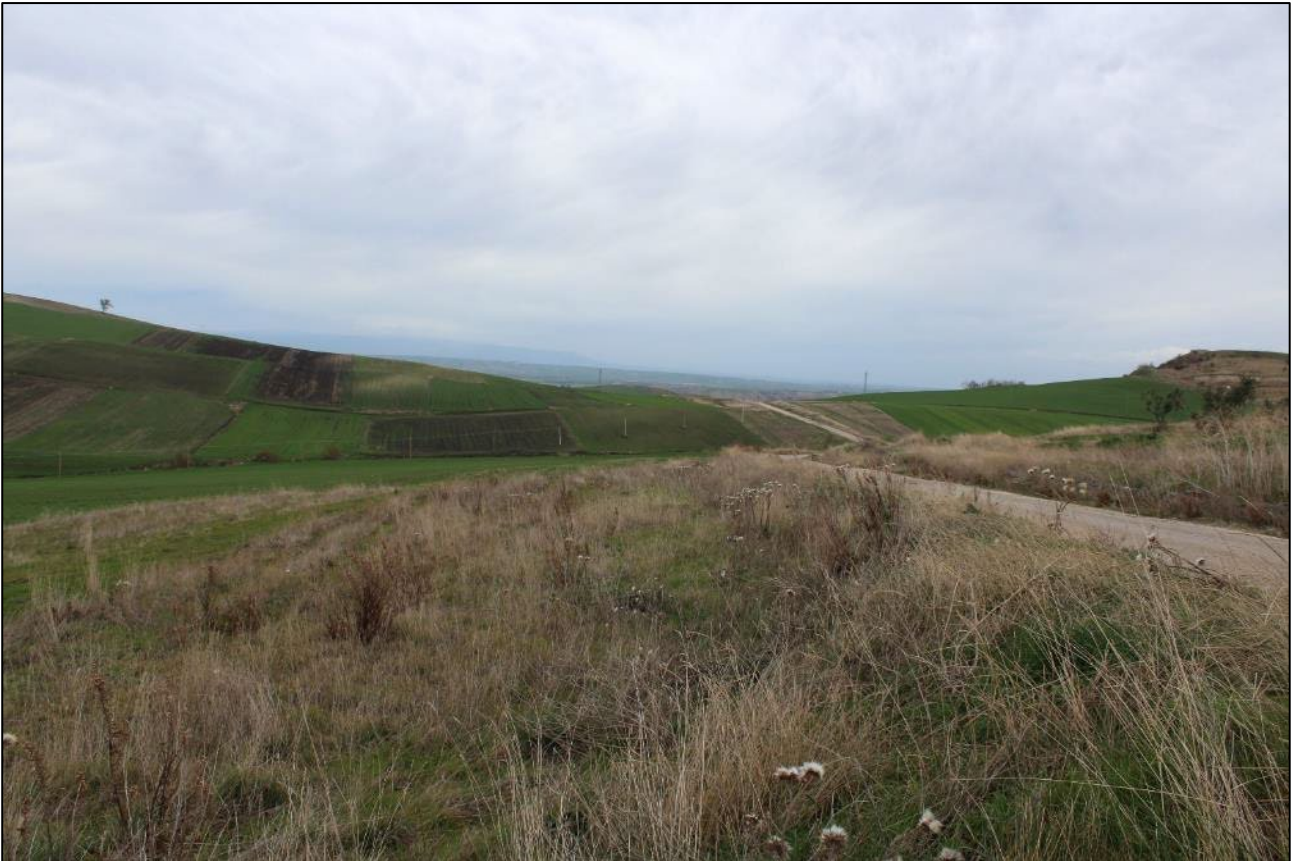
41. Località Masseria Ianiri, tratto del cavidotto esterno diretto a E
