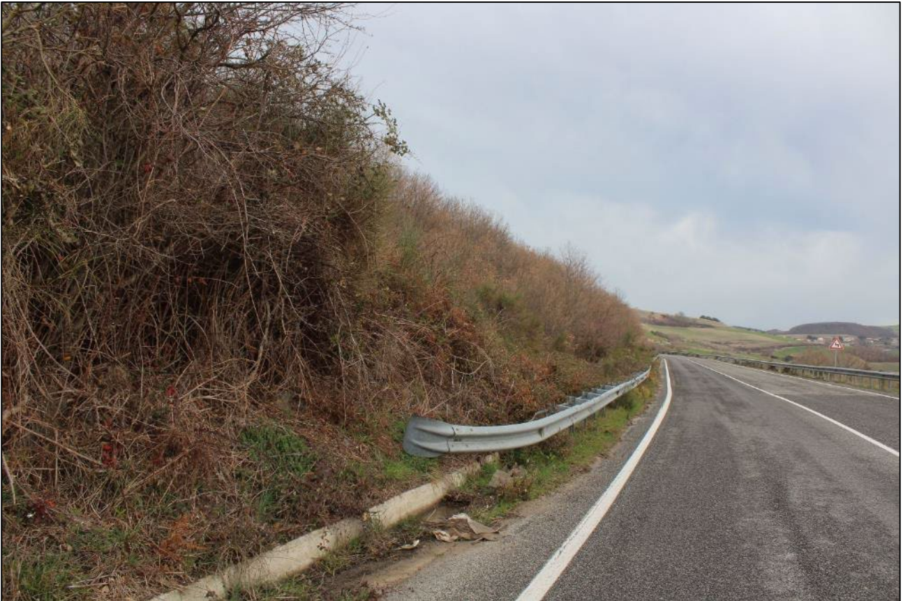
96. Località Spineto/Colle Gilardo, tratto del cavidotto interno diretto a E
