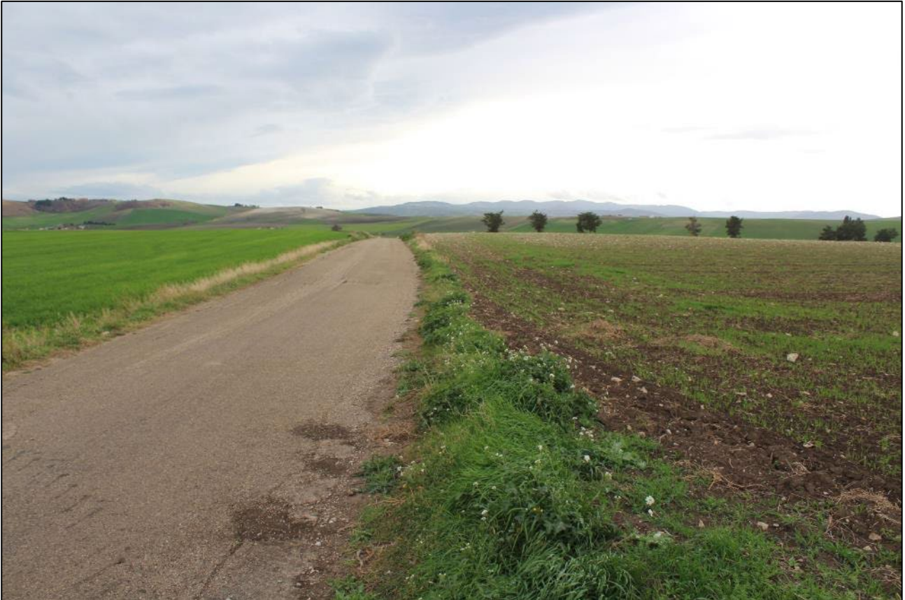
26. Località Piano Palazzo/Masseria Mascia, tratto del cavidotto esterno diretto SSE
