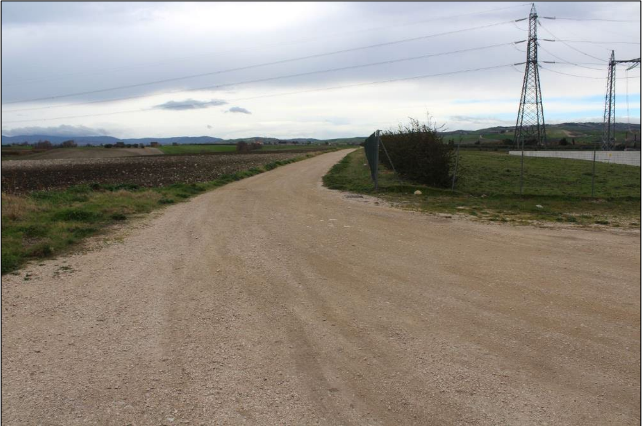
4. Località Piano della Fontana, tratto del cavidotto esterno diretto a SW lungo la strada interpodereale Piano della Cannuccia
