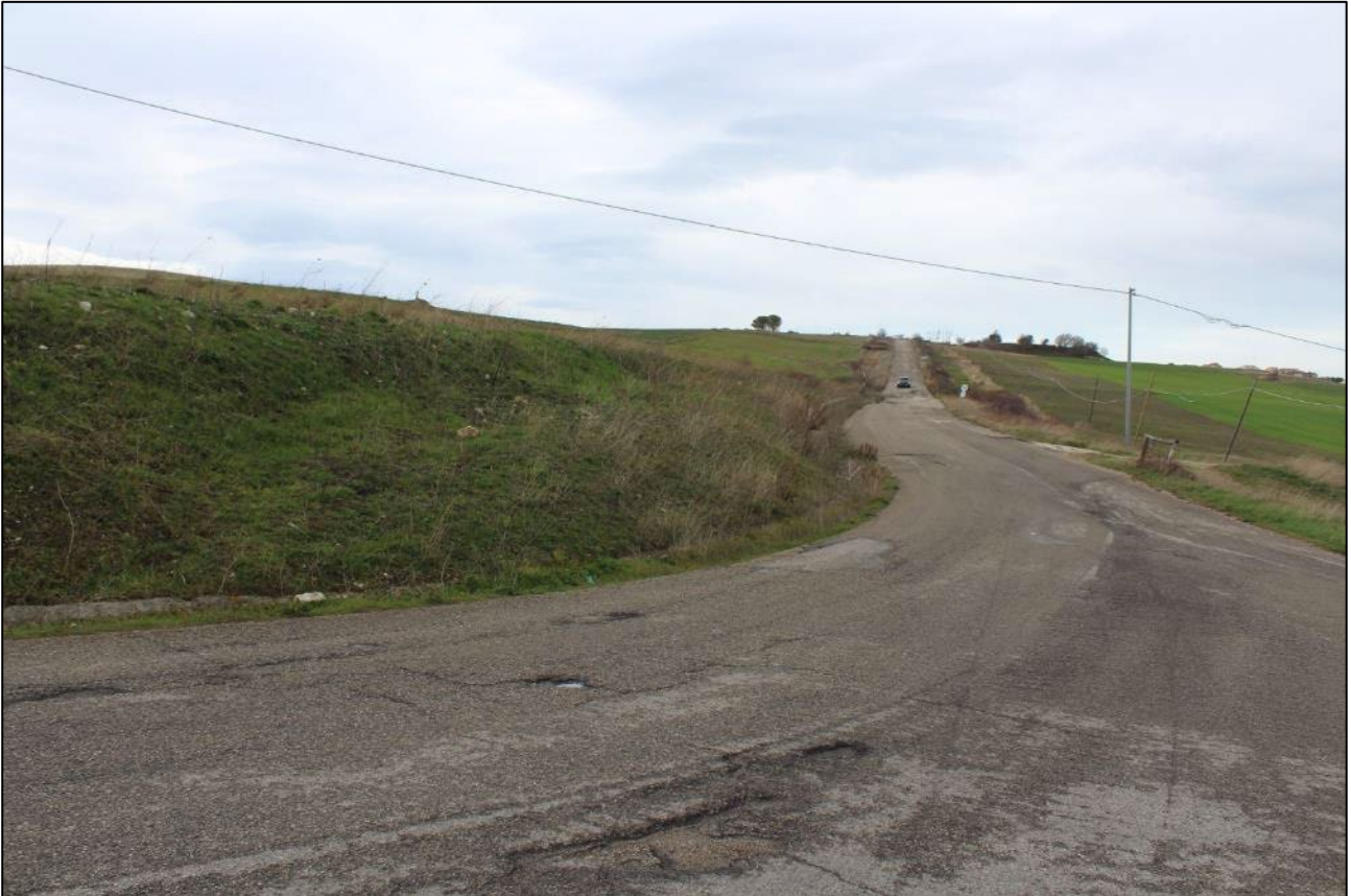
50. Località Fontemerra/Masseria Vicario, tratto del cavidotto esterno diretto a WNW
