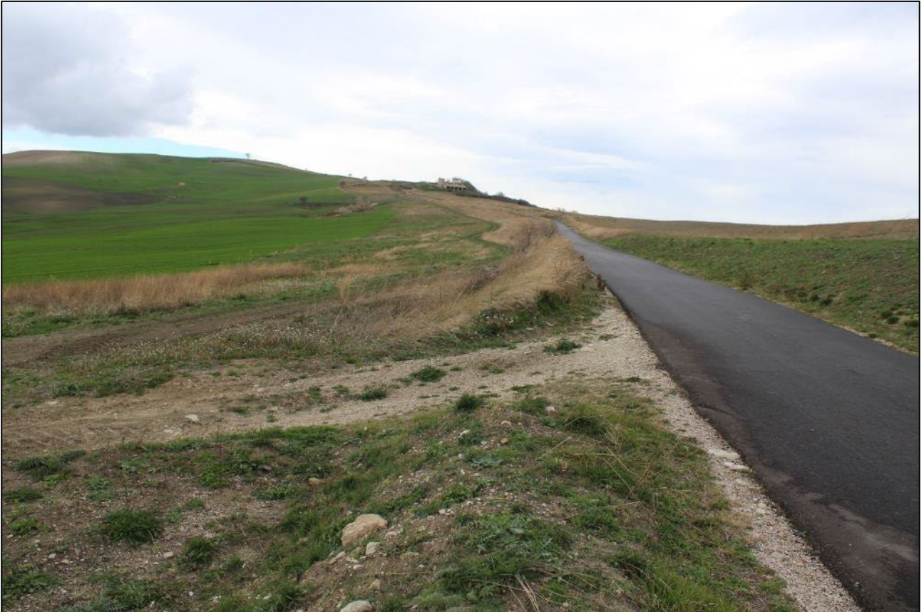
44. Località Casa Lombardi, tratto del cavidotto esterno diretto a WSW lungo la SP Pinciara Posticchio Sterparone
