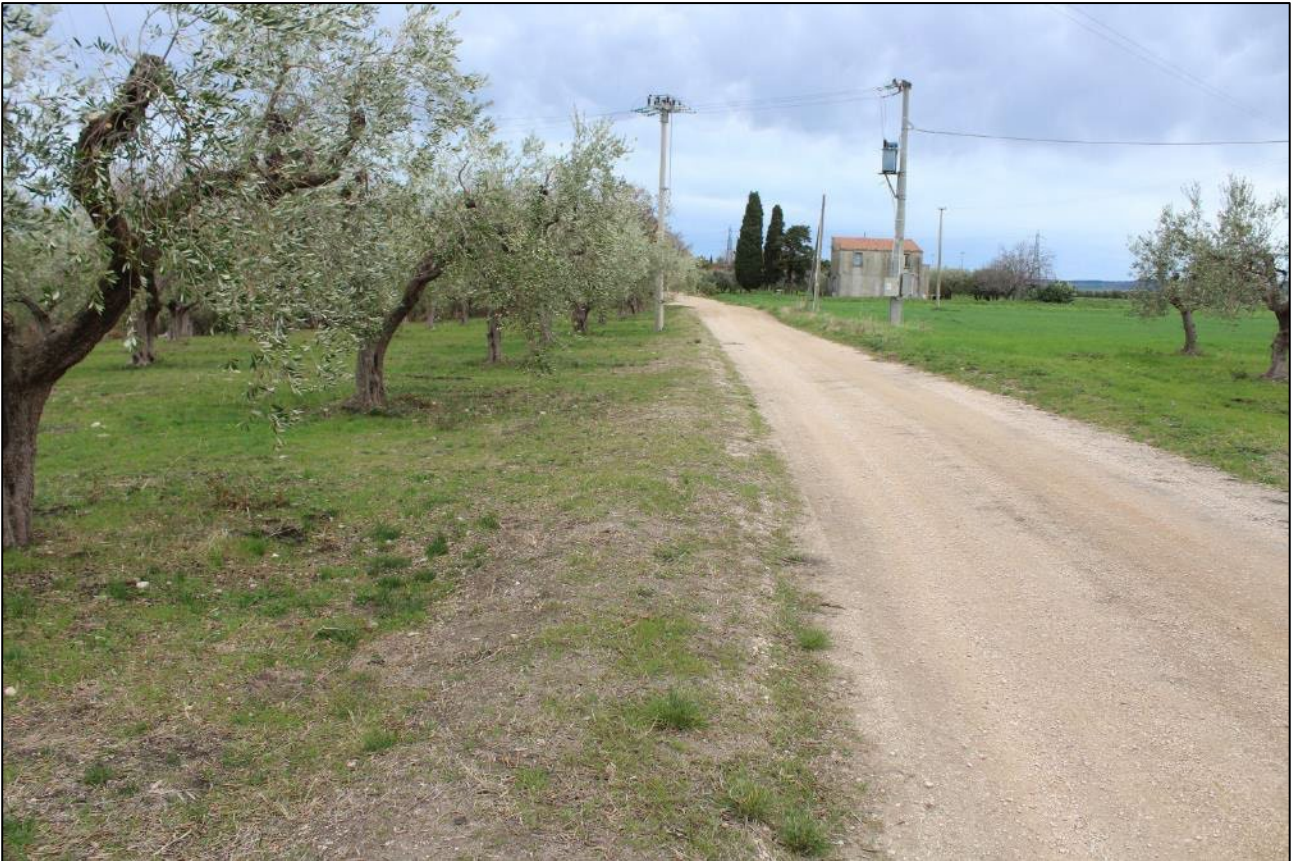
9. Località Podere San Paolo, tratto del cavidotto esterno diretto a NNE lungo la strada interpoderale Piano della Cannuccia
