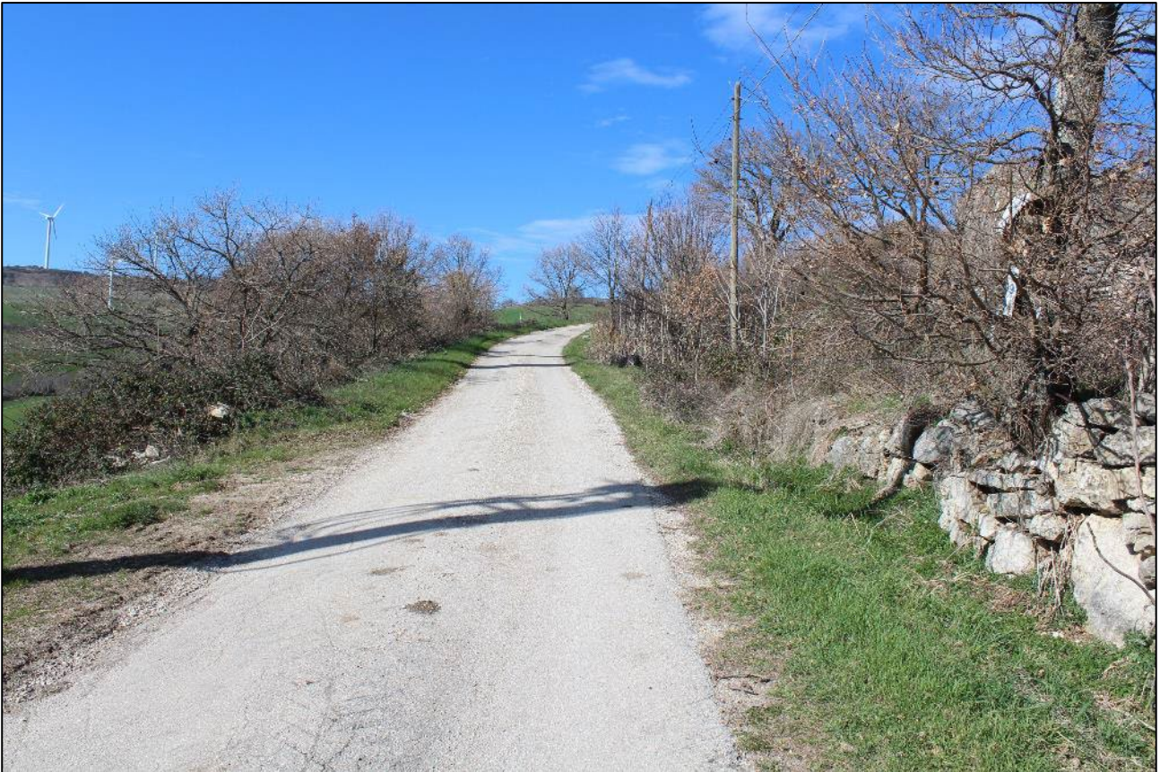
124. Località Folcaro, tratto del cavidotto interno diretto a WNW, in direzione della SS 87
