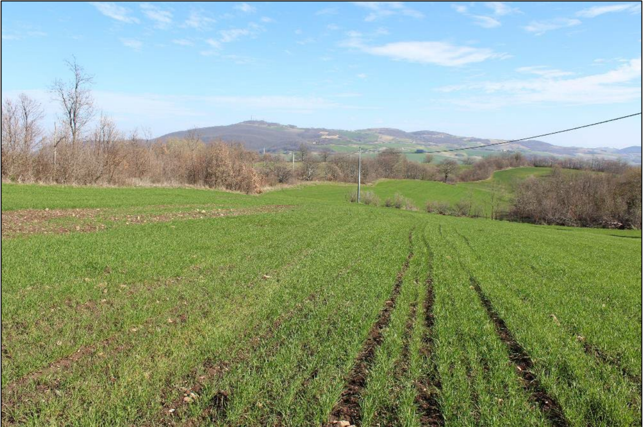
137. Località Cerrosecco, tratto del cavidotto interno diretto a ENE
