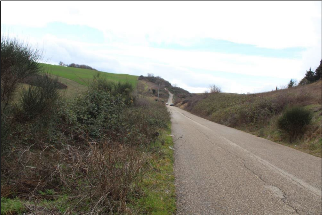
65. Località Colle della Difesa/Santa Maria Mannella, tratto del cavidotto esterno diretto a WSW
