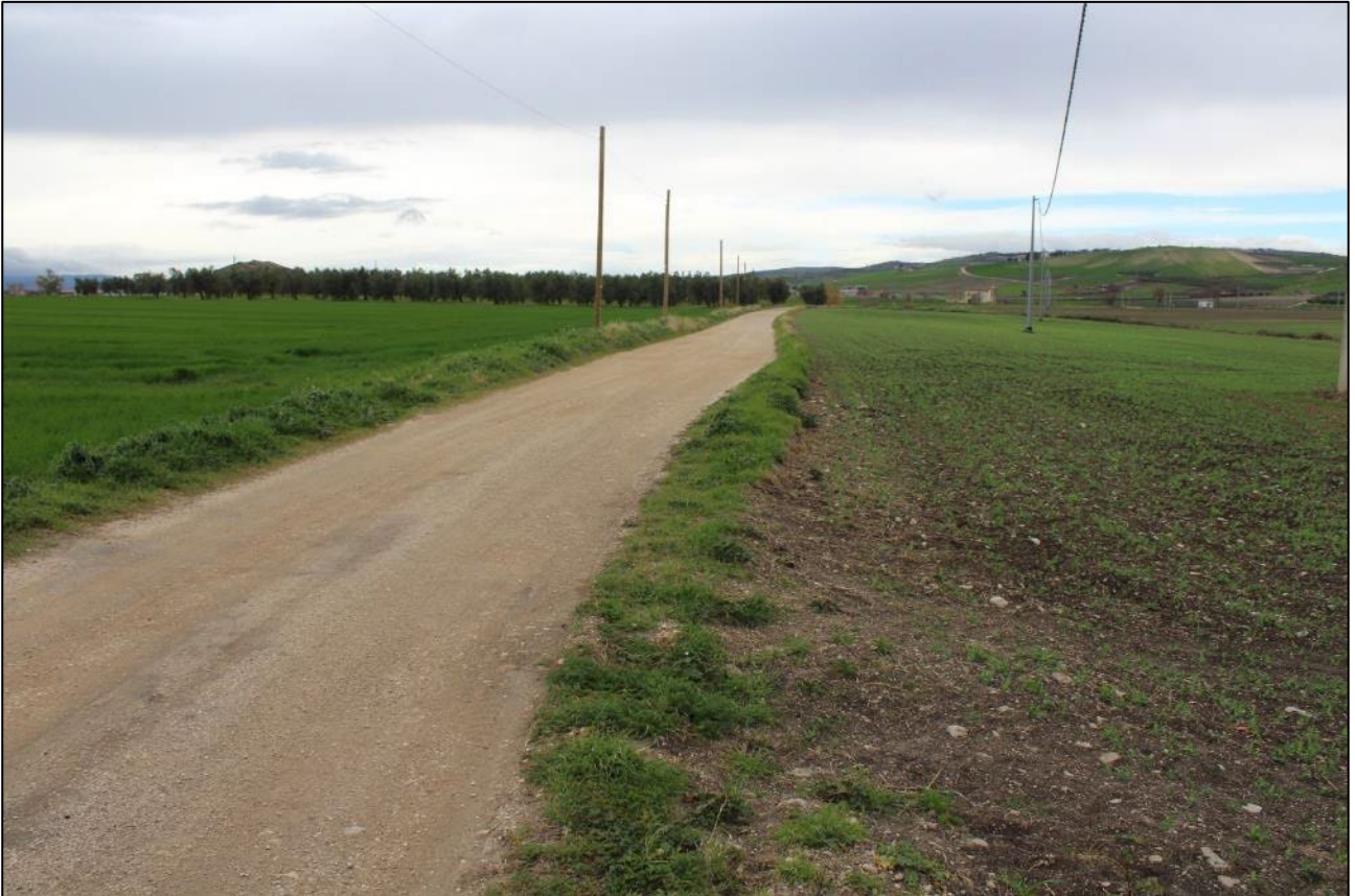
10. Località Podere San Paolo, tratto del cavidotto esterno diretto a SW lungo la strada interpoderale Piano della Cannuccia
