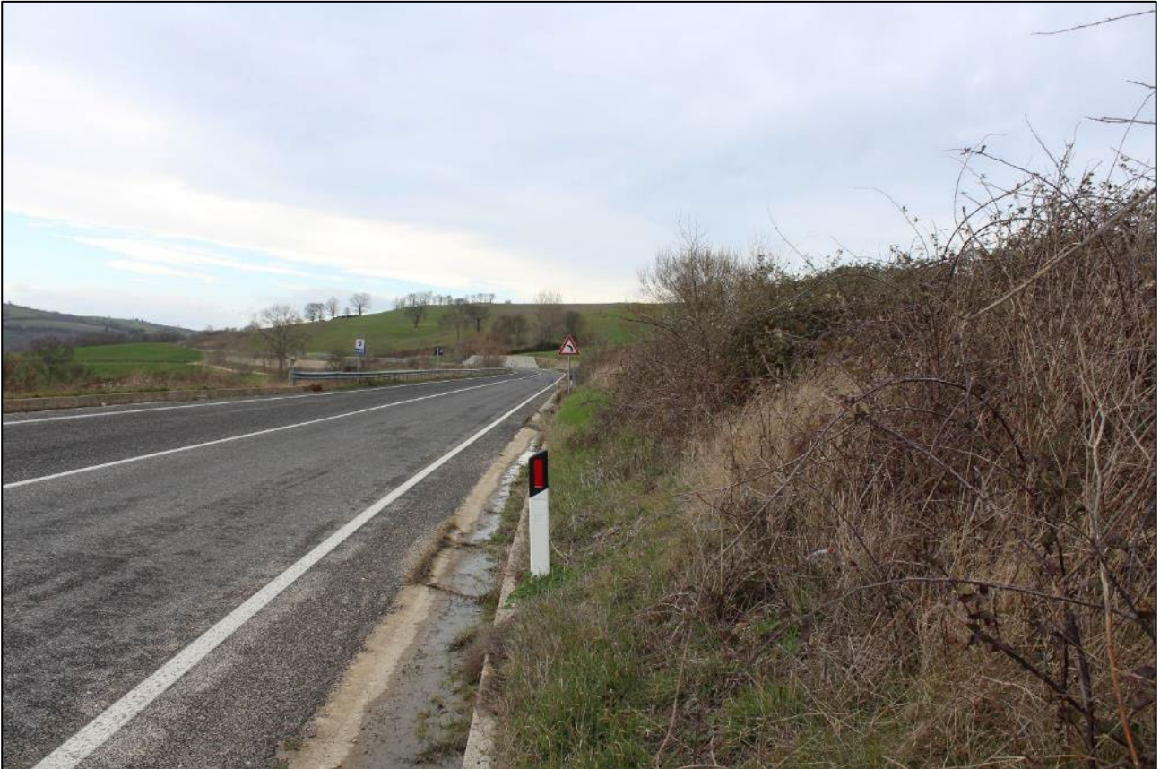
97. Località Spineto/Colle Gilardo, tratto del cavidotto interno diretto a WNW
