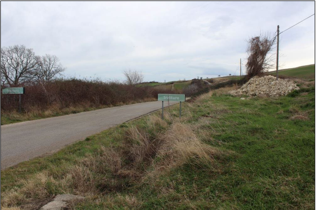
47. Località Salce/Masseria Cassano, tratto del cavidotto esterno diretto a SE
