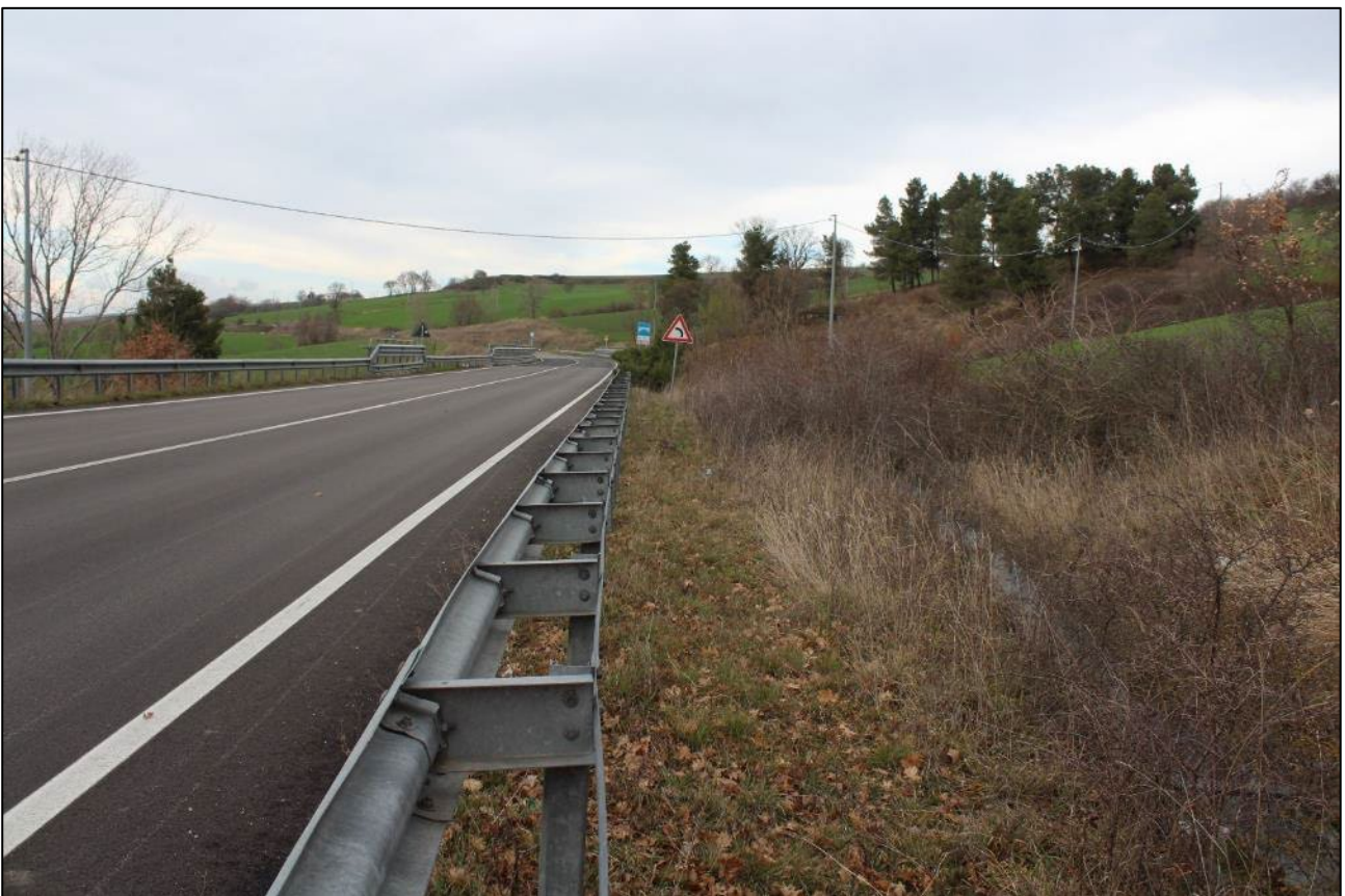
99. Località Masseria Di Memmo, tratto del cavidotto interno diretto a NW
