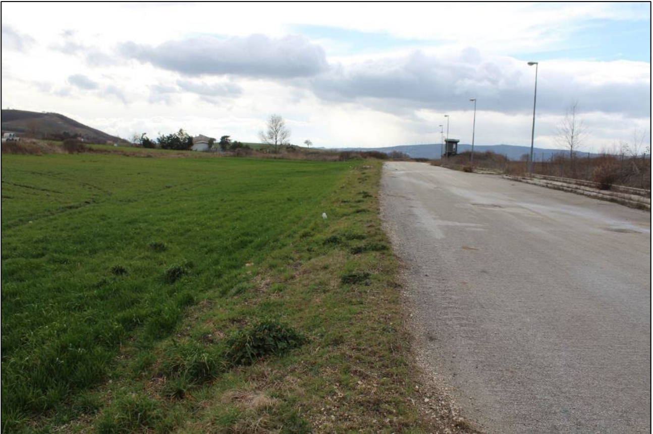
75. Località Pianto delle Donne, tratto del cavidotto interno diretto a SSW
