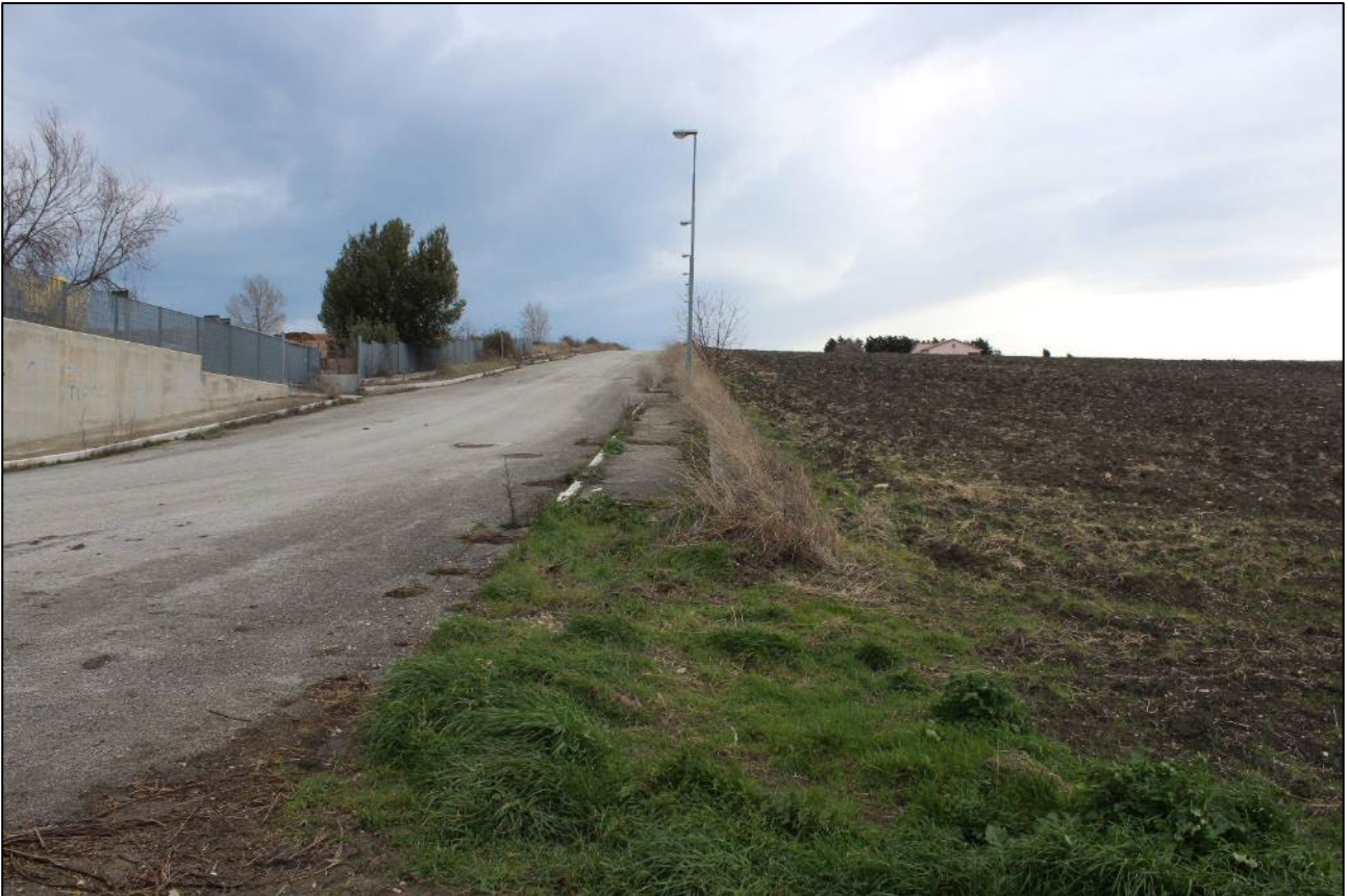
86. Località Bosco D'Ogna, tratto del cavidotto interno diretto a SE
