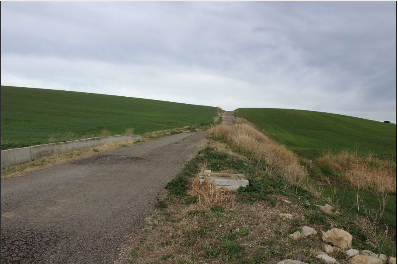
35. Località Codarda/Masseria Colamussi, tratto del cavidotto esterno diretto a NE
