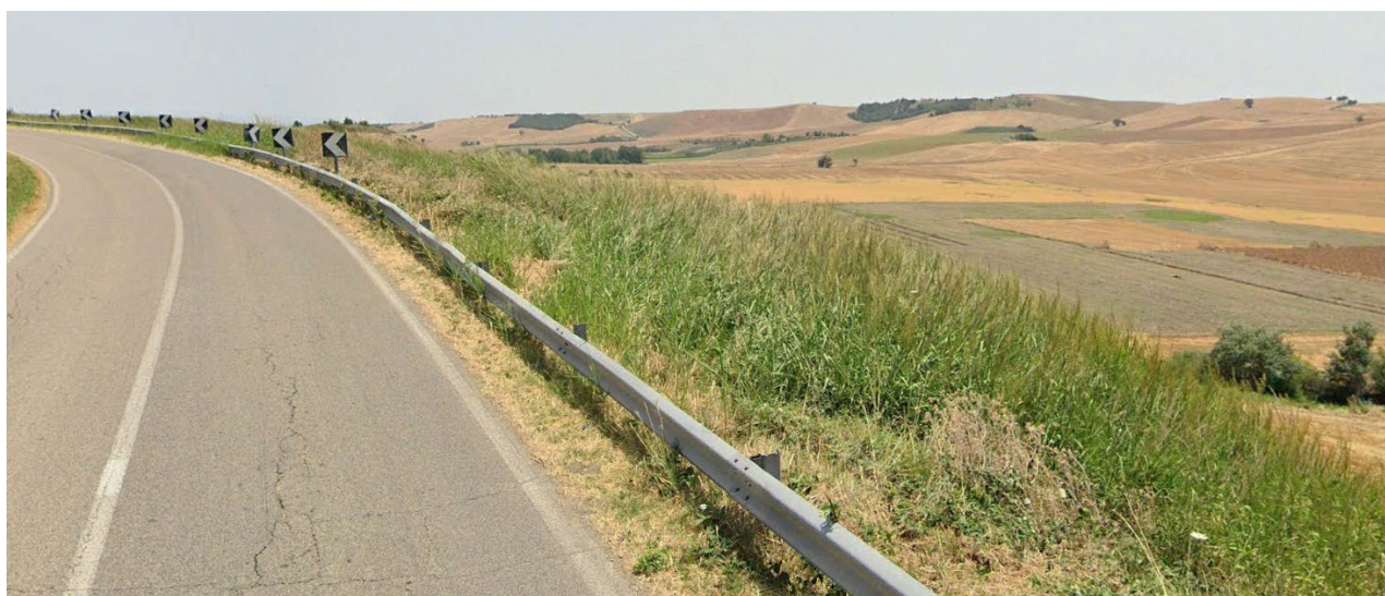
Figura 8-2: panoramica fascia prospiciente la strada, interessata dagli scavi per il cavidotto e priva di vegetazione tipica del Thero-Brachypodietea
