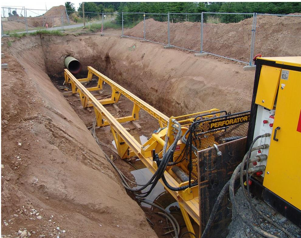
Fig. 33 - Esempio di tecnologia no dig per la posa di tubazioni
