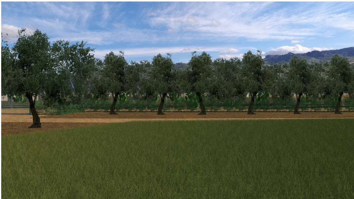
Fig. 12- Vista perimetrale dall'esterno dell'impianto
