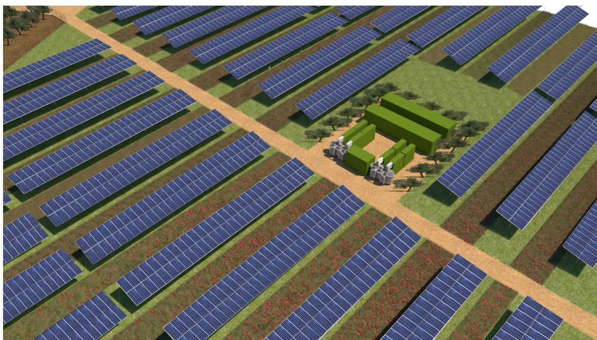
Fig. 8 - Vista cabine dall'alto
