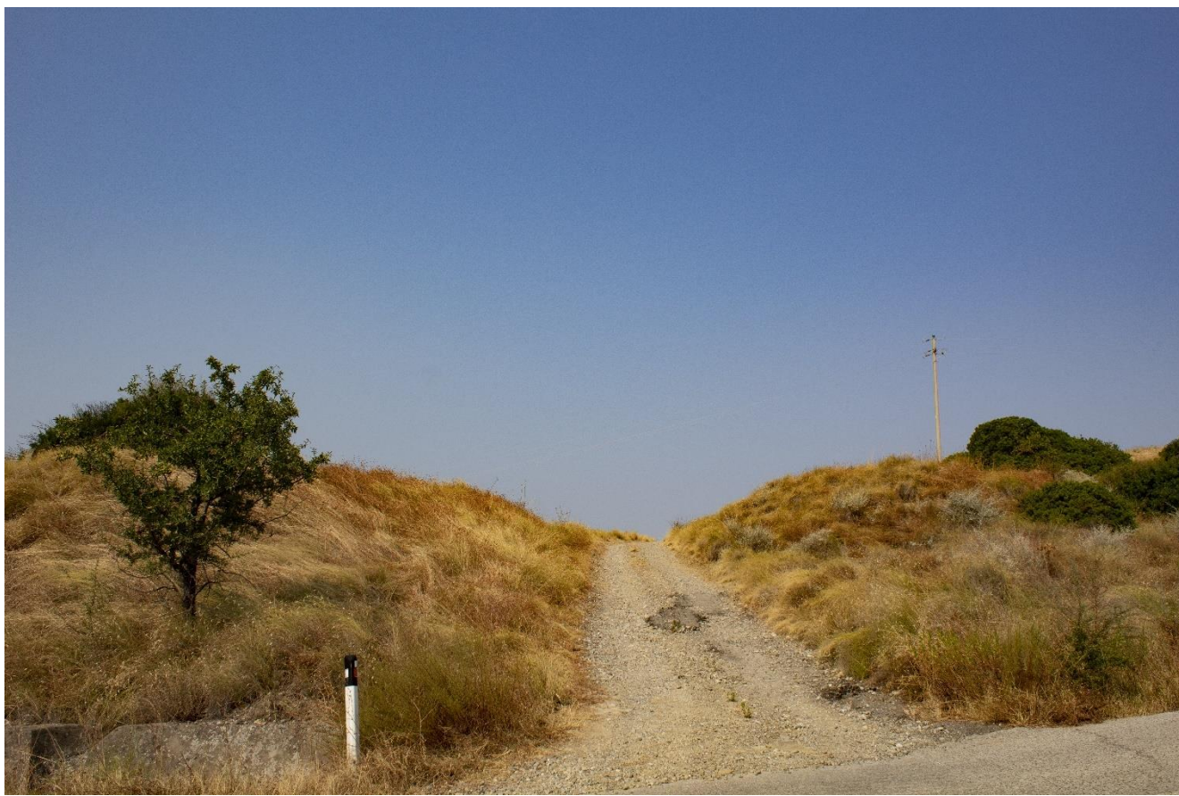
Figura 41 - Foto Strade interne impianto
