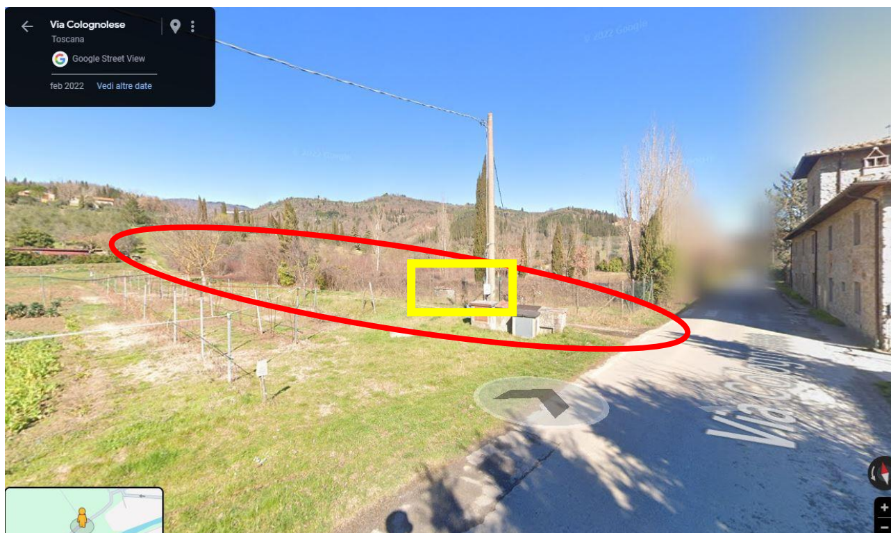
Foto 1 - Via Colognese, strada Poderale con casottini dei contatori metano ecc. Nel riquadro giallo: casottino e pozzo artesiano, nostri
