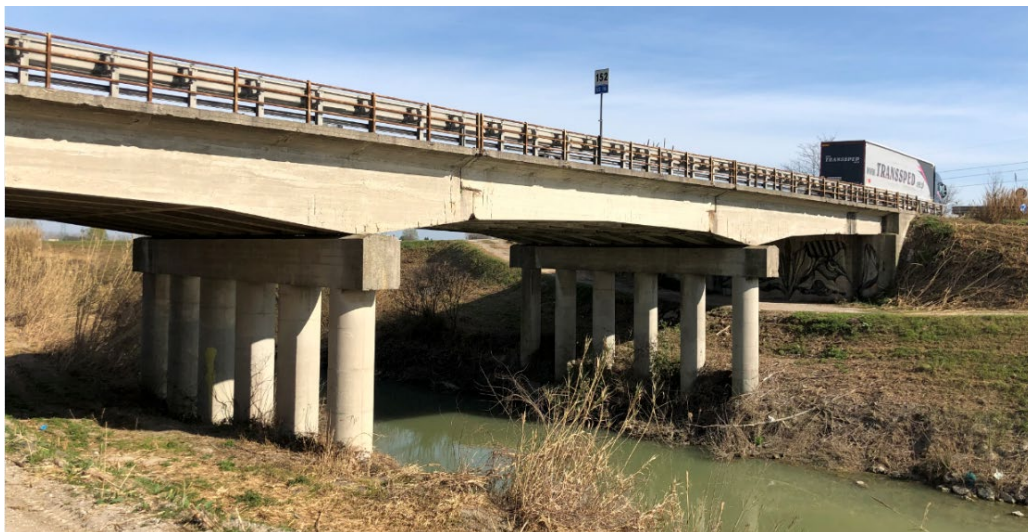
Figura 15: Vista del ponte sul fiume Montone
