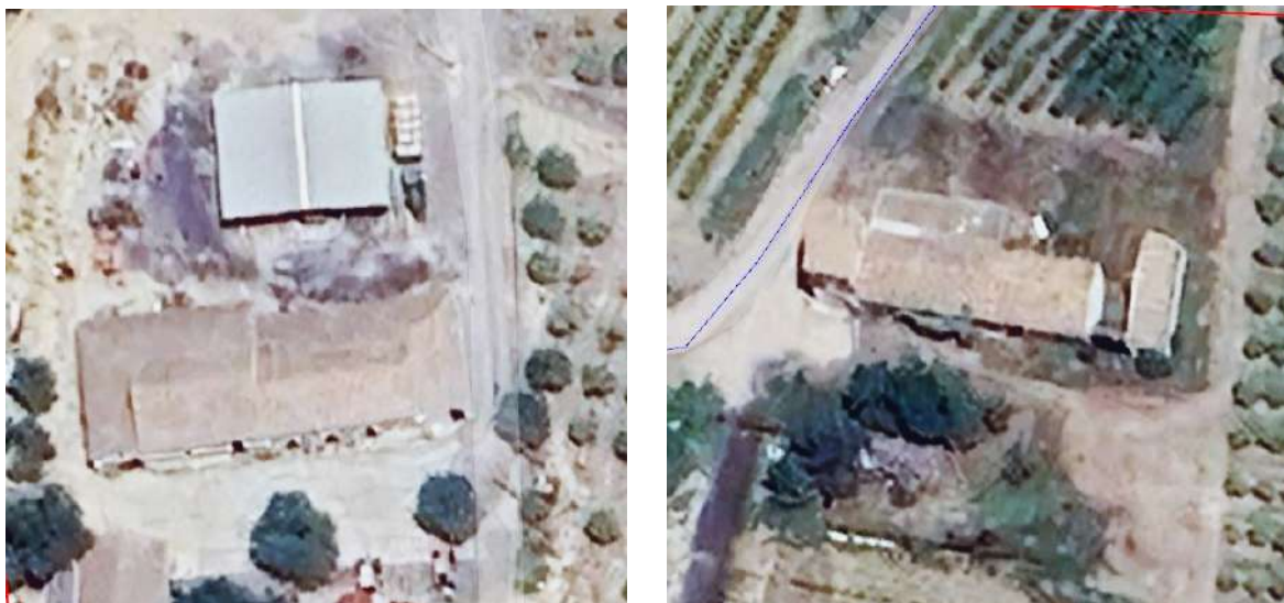
Fabbricati presenti nell'area interessata dalle opere in progetto
