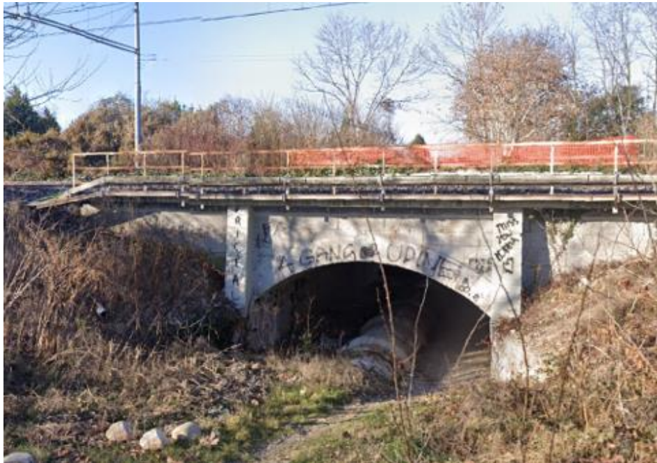
Figura 4.4 Attraversamento ferroviario della Lavia di Galleriano visto da SUD verso Nord, fonte Google
