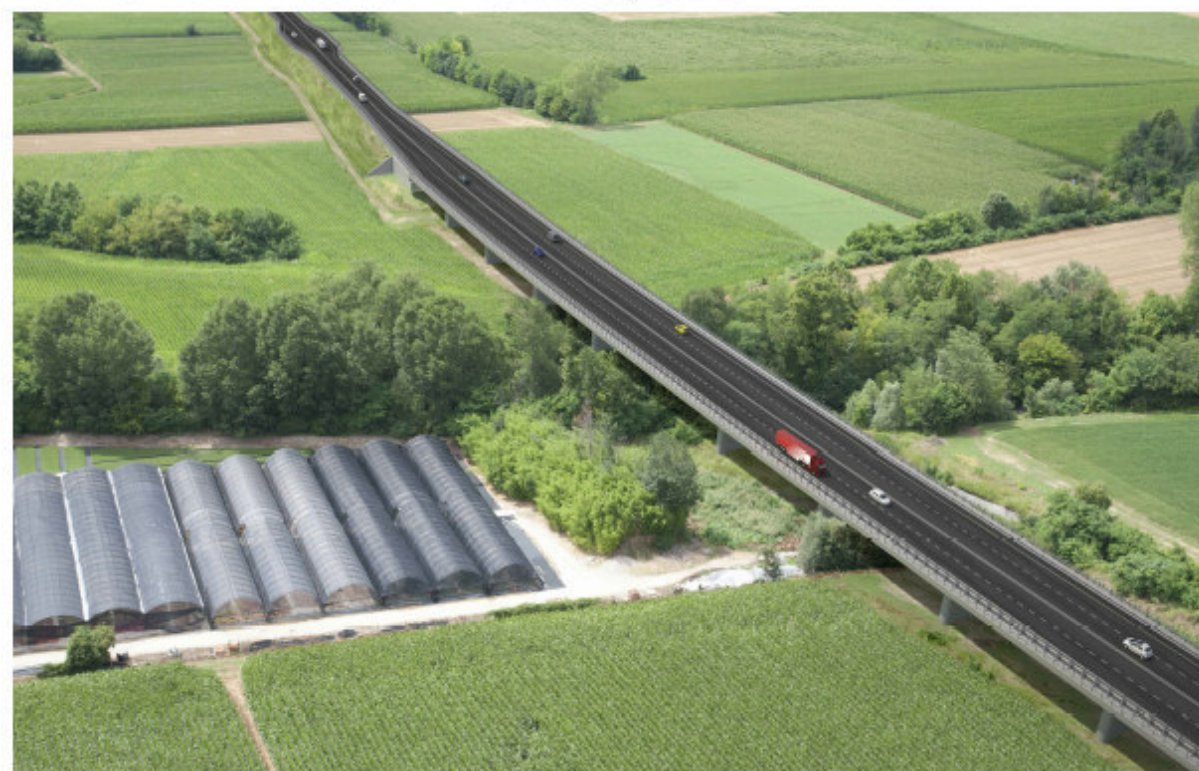
PONTE SUL TORRENTE CORMOR – vista da est/sud-est
