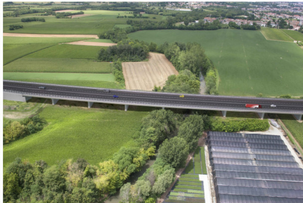
PONTE SUL TORRENTE CORMOR – vista da sud
