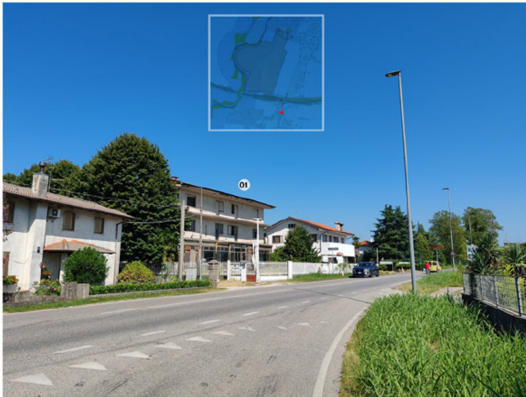
STATO DI FATTO FOTO 2 01 - Edifici da demolire per opere di mitigazione
