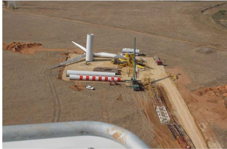
Figura 4 – Piazzola per il montaggio dell'aerogeneratore
