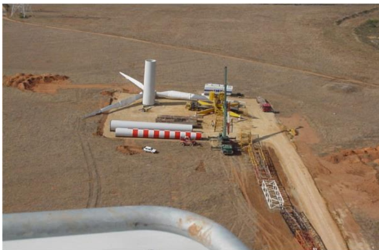
Figura 4 – Piazzola per il montaggio dell'aerogeneratore
