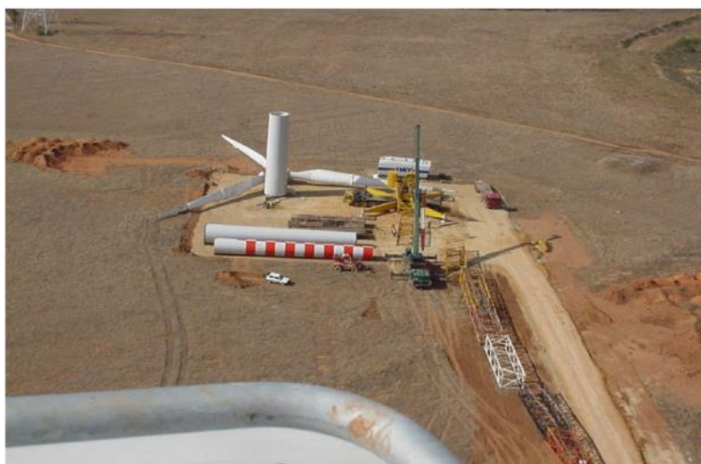
Figura 11 – Piazzola per il montaggio dell'aerogeneratore
