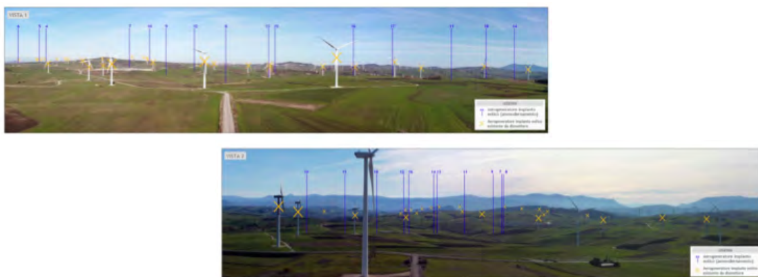
Fig. 3. Panoramica dell’impianto esistente con l’indicazione delle strutture da eliminare.
