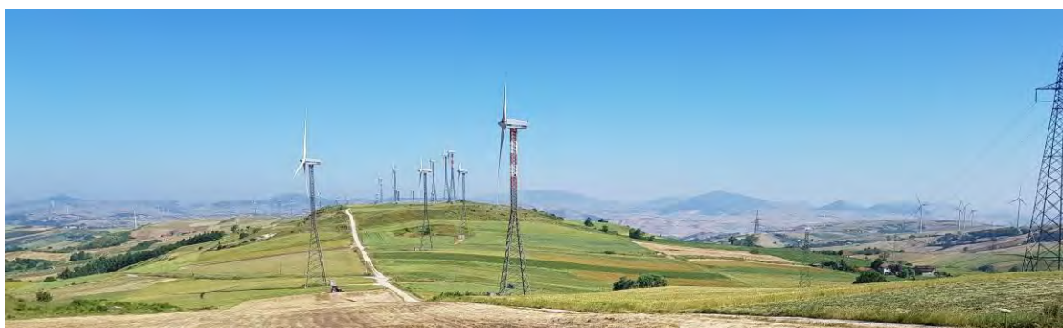
Panoramica Impianto in esercizio, Bisaccia, Loc. Serro Pignataro.
