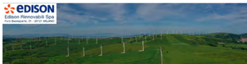
Fig. 9. Una panoramica dell'impianto esistente (Fonte: Edison, relazione tecnica)
