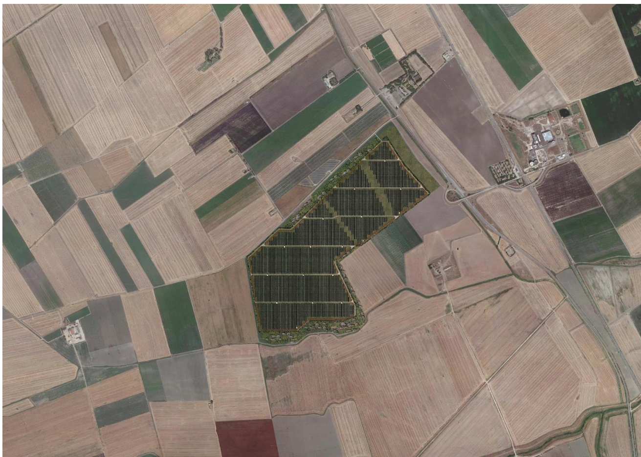
Fotoinserimento - Area interessata dall'impianto agrivoltaico
