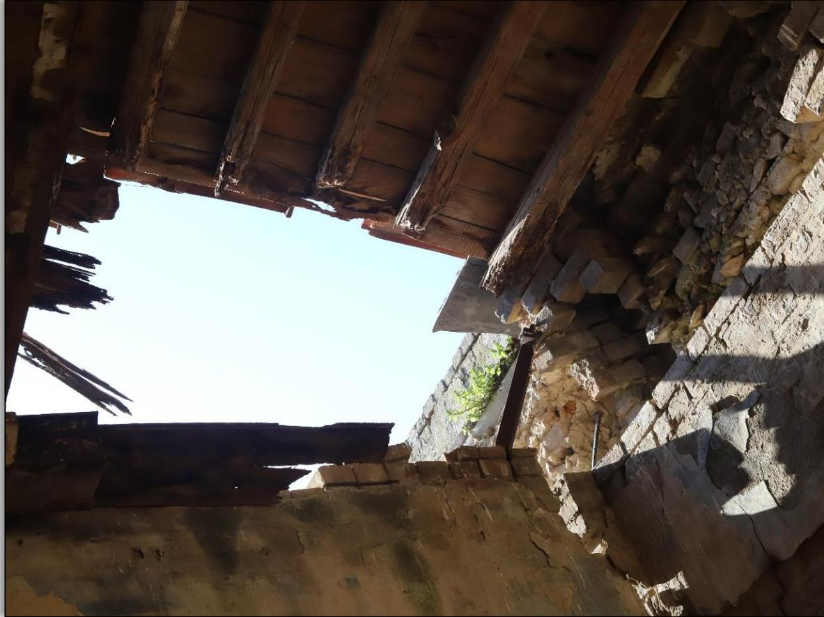
Pareti perimetrali verticali portanti in muratura realizzata in pietra calcarea. L'apparecchio si compone prevalentemente di elementi grossi, irregolari, posti di punta, ingranati e assestati, e da elementi medio-piccoli con funzione di riempimento dei vuoti lasciati dagli elementi più grandi. Lo spessore è variabile.
